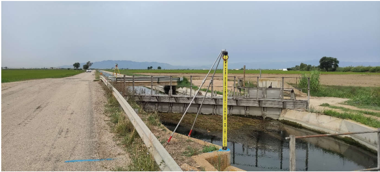
Figura 6: Mira invar GPCL2 estacionada sobre un clavo.
