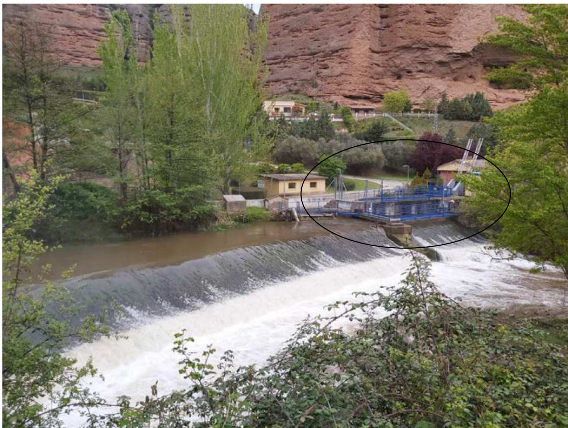
Figura 5. Fotografía del azud y de las instalaciones de la toma de agua en margen izquierda
