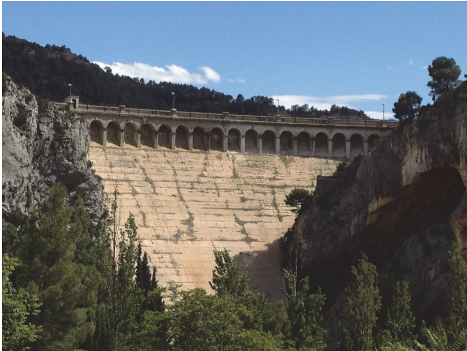
Figura 7. Vista de la presa del embalse desde aguas abajo.
