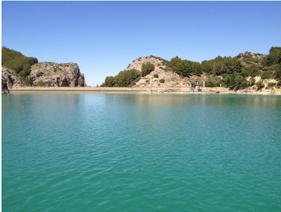
Figura 7. Vista de la presa del embalse
