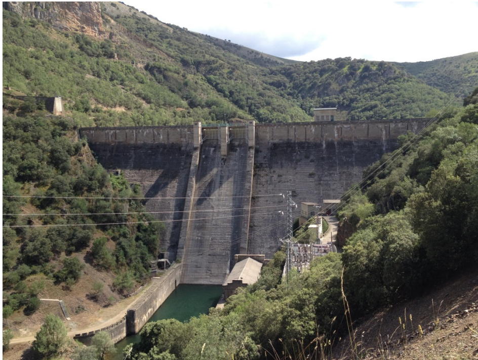
Figura 7. Vista de la presa desde aguas abajo del embalse.
