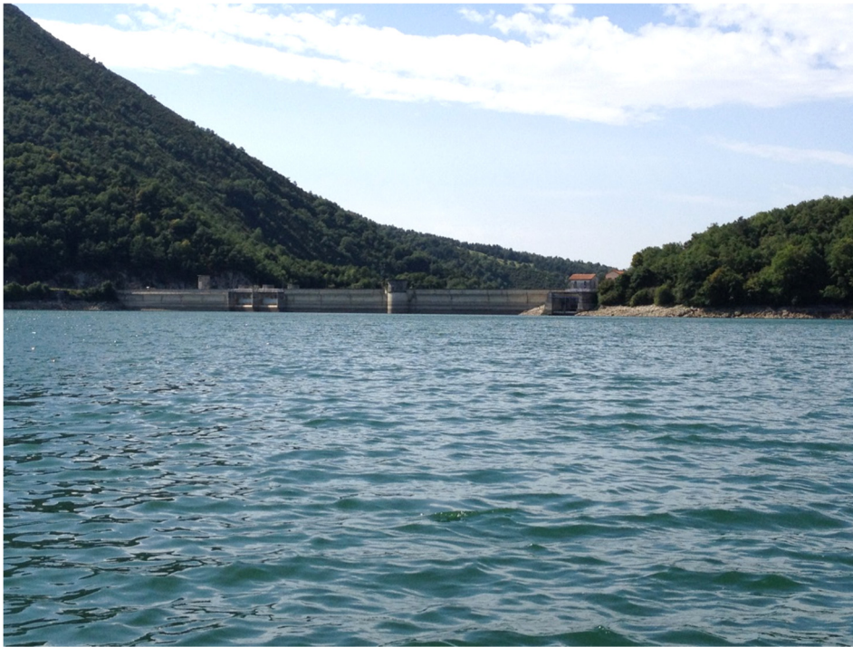
Figura 7. Vista de la presa del embalse
