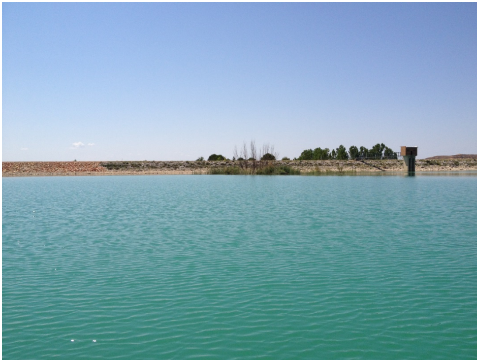
Figura 7. Vista de la presa del embalse.
