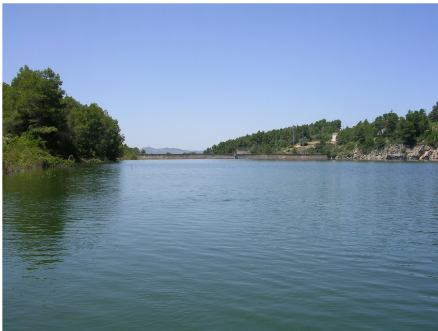
Figura 7. Vista de la presa del embalse
