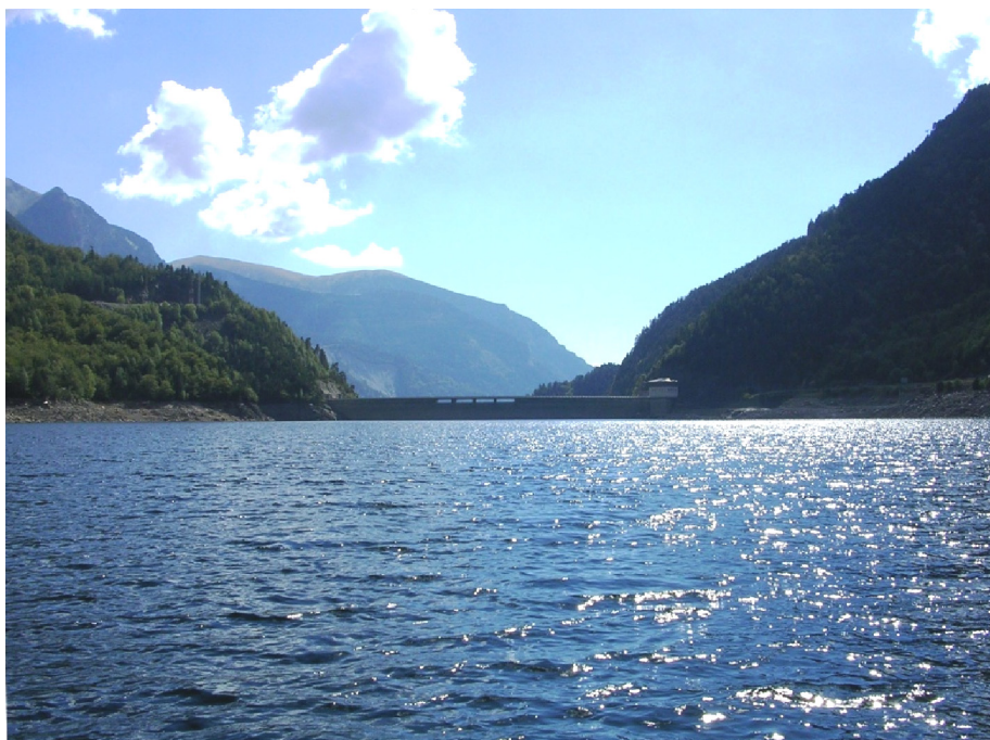
Figura 7. Vista de la presa del embalse
