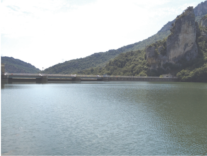
Figura 7: Presa del embalse
