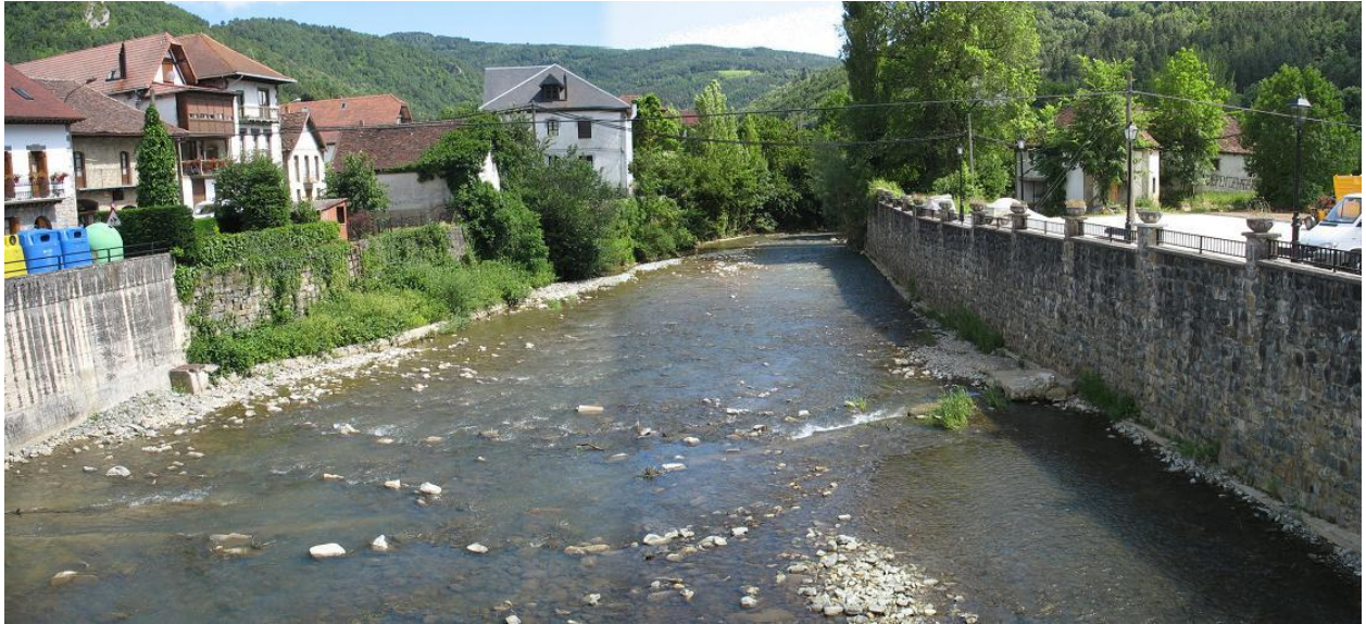
Figura 4-34. Canalización del río Salazar en Ezcaroz.
