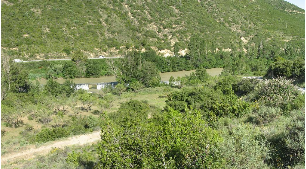
Figura 4-13. Azud aguas abajo de Liédena.
