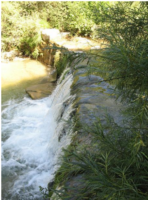
Figura 4-26. Pequeño azud de derivación en el río Areta.
