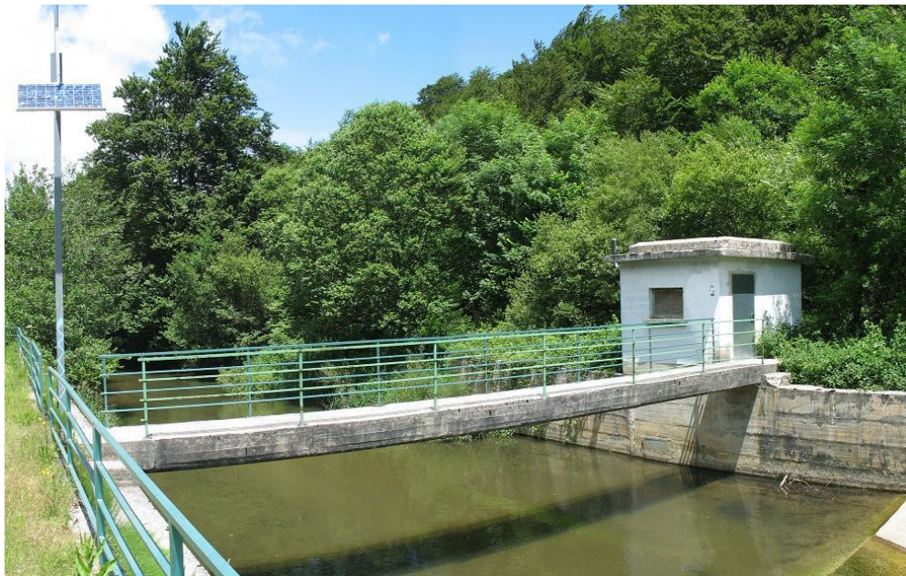
Figura 4-18. Estación de aforos aguas abajo de Burguete.
