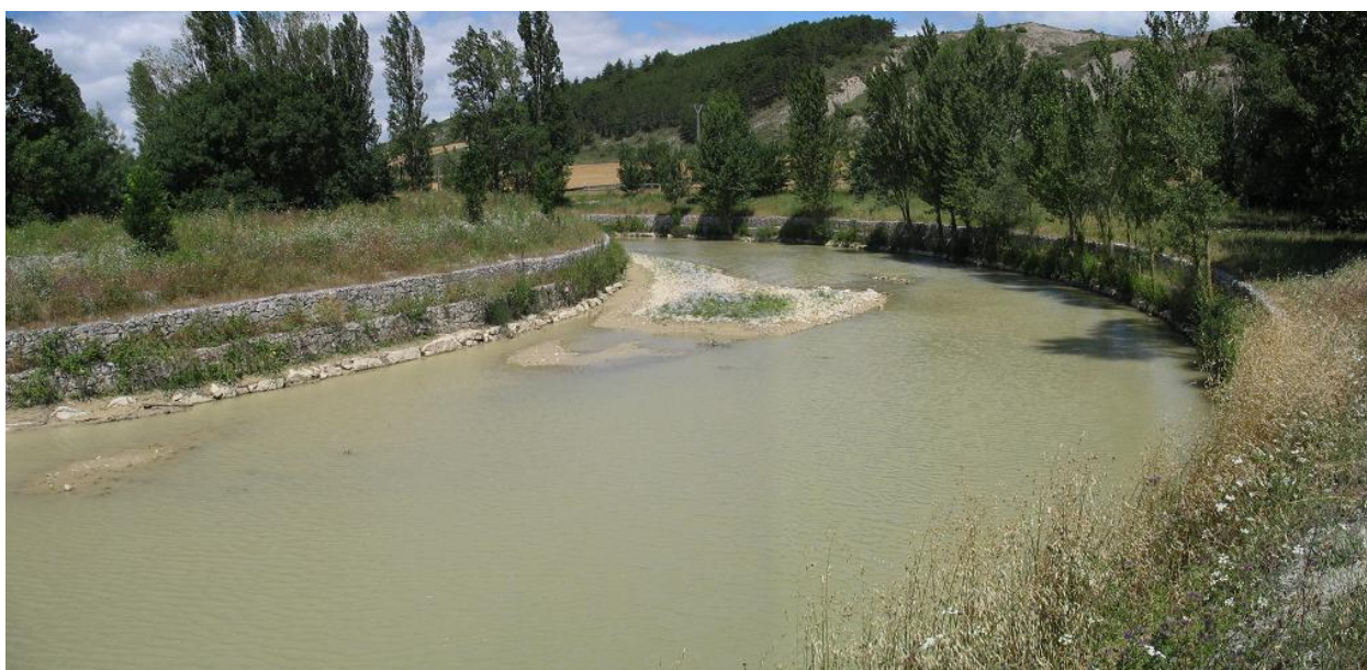
Figura 4-22. Canalización del río Erro en Urrozvilla.
