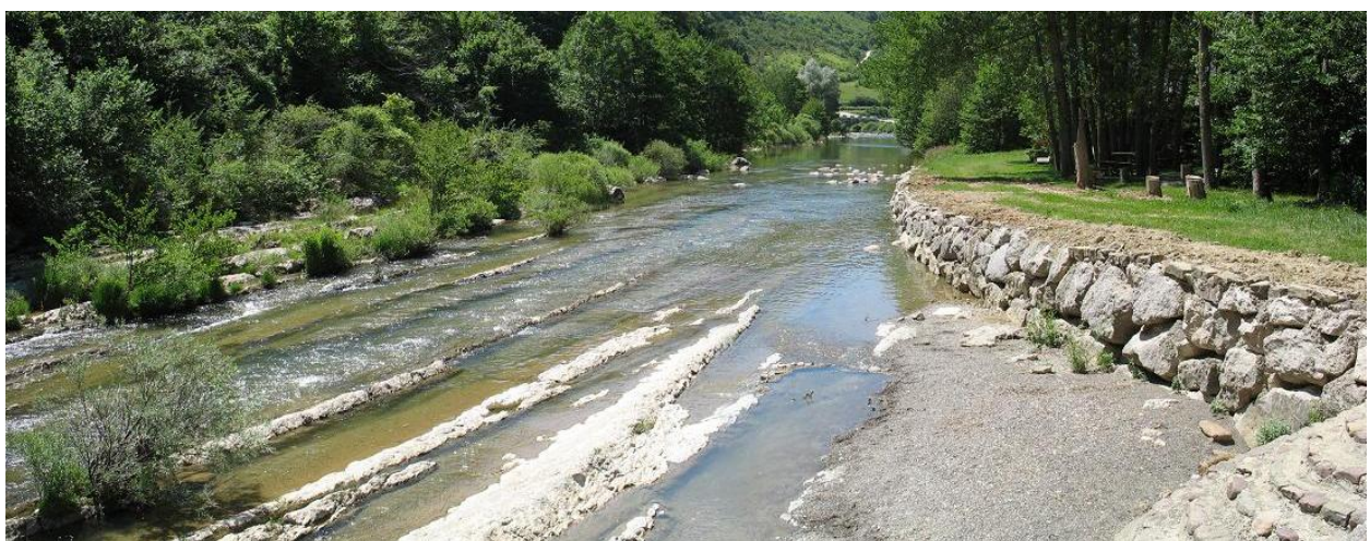
Figura 4-7. Defensas de margen en Oroz-Betelu.
