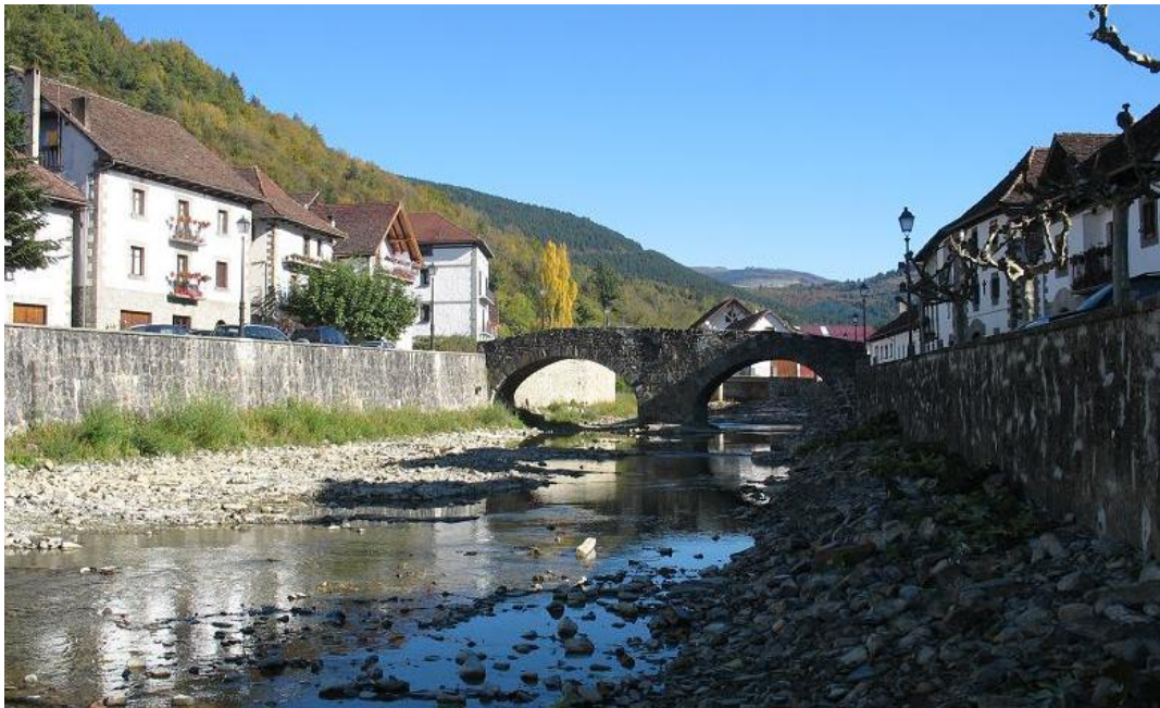
Figura 4-31. Canalización del río Anduña en Ochagavía.
