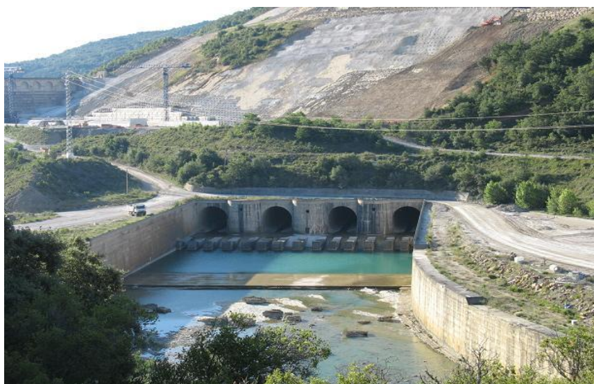
Figura 4-38. Canal de desagüe del embalse de Yesa.
