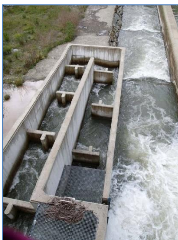
Figura 98-Figura 116. Escala de peces en el río Irati, en Oroz-Betelu (Navarra).
