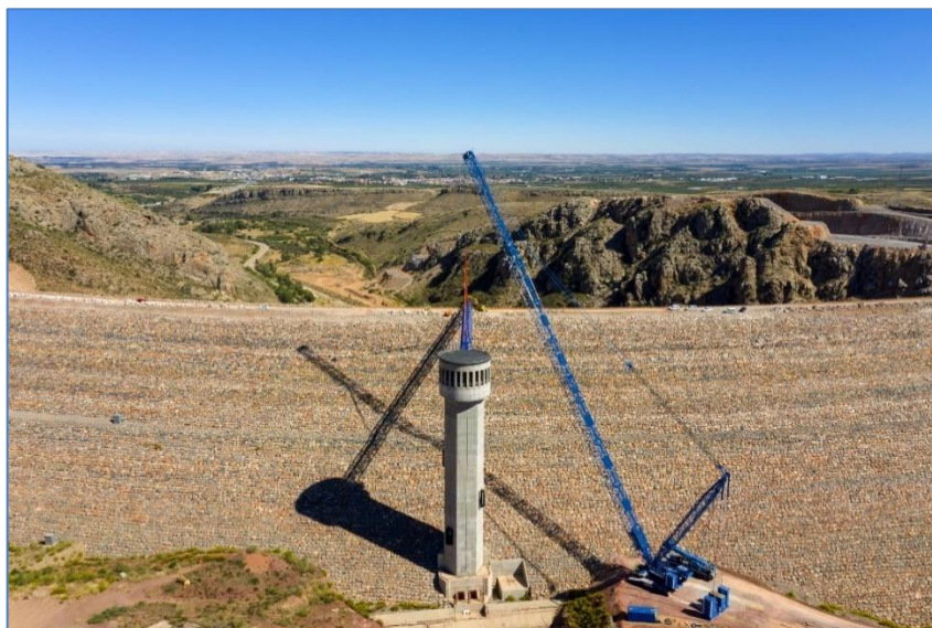
Figura 47 Figura 52 . Vista general de la presa de Mularroya.
