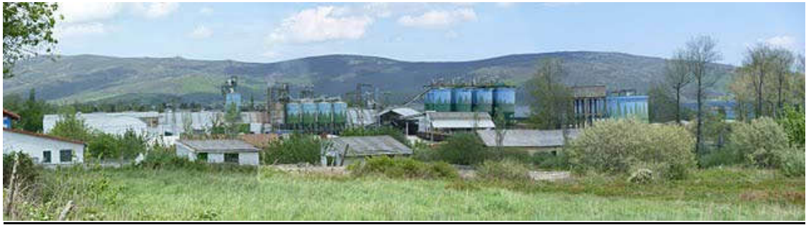
Ilustración 28: Vista general de una planta de tratamiento
