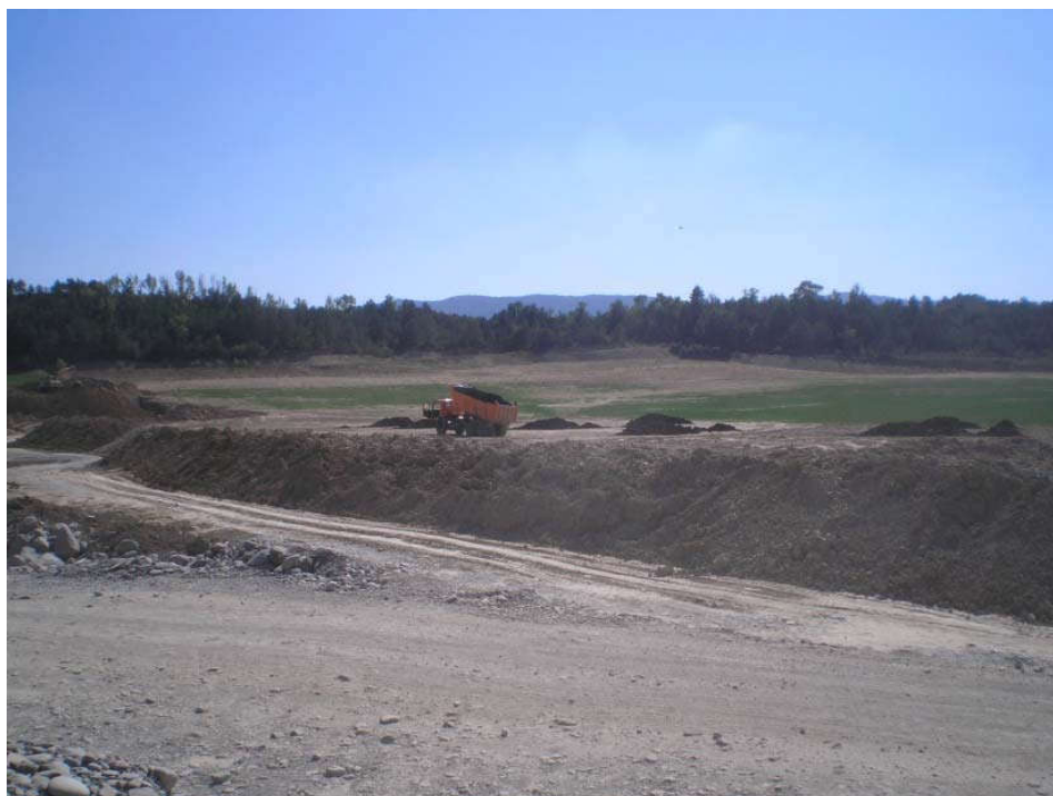
Ilustración 22: Movimiento de tierras
