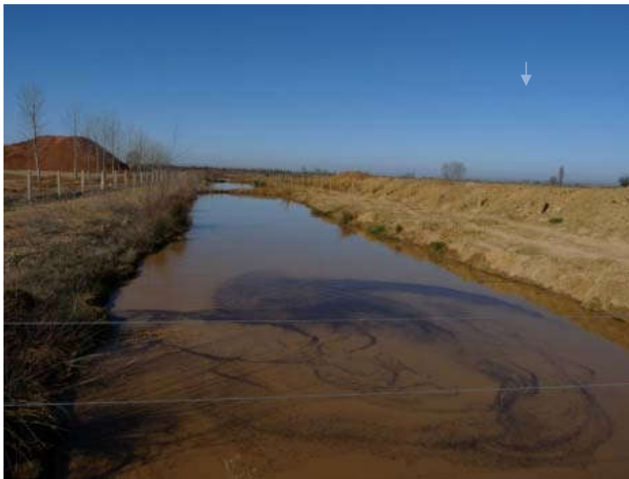
Ilustración 40: Balsa decantación de lodos
