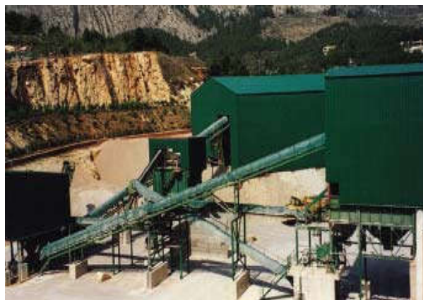
Ilustración 68: Carenado de las instalaciones
