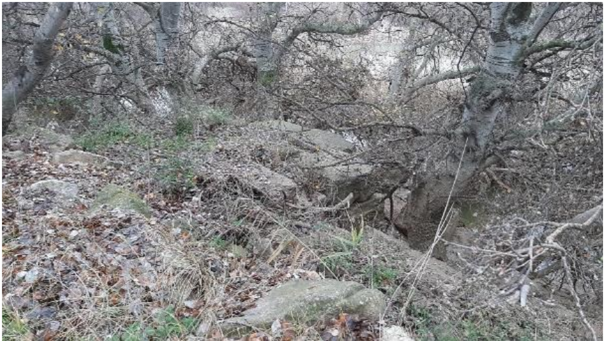
Fotografía 4 Detalle de la defensa transversal al río en la mota actual
