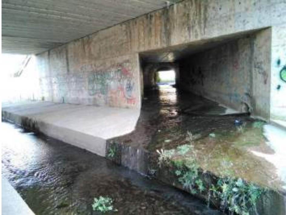
Fotografía nº 9. Tramo A-Sección II. Confluencia del Barranco del Diablo, bajo el puente de la Ronda Misericordia
