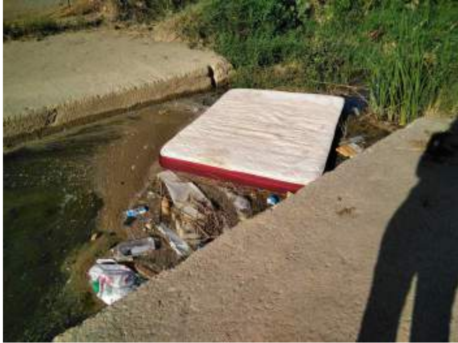
Fotografía nº 13. Tramo A-Sección II. Final del tramo canalizado de tipo Sección II. Acumulación de residuos.
