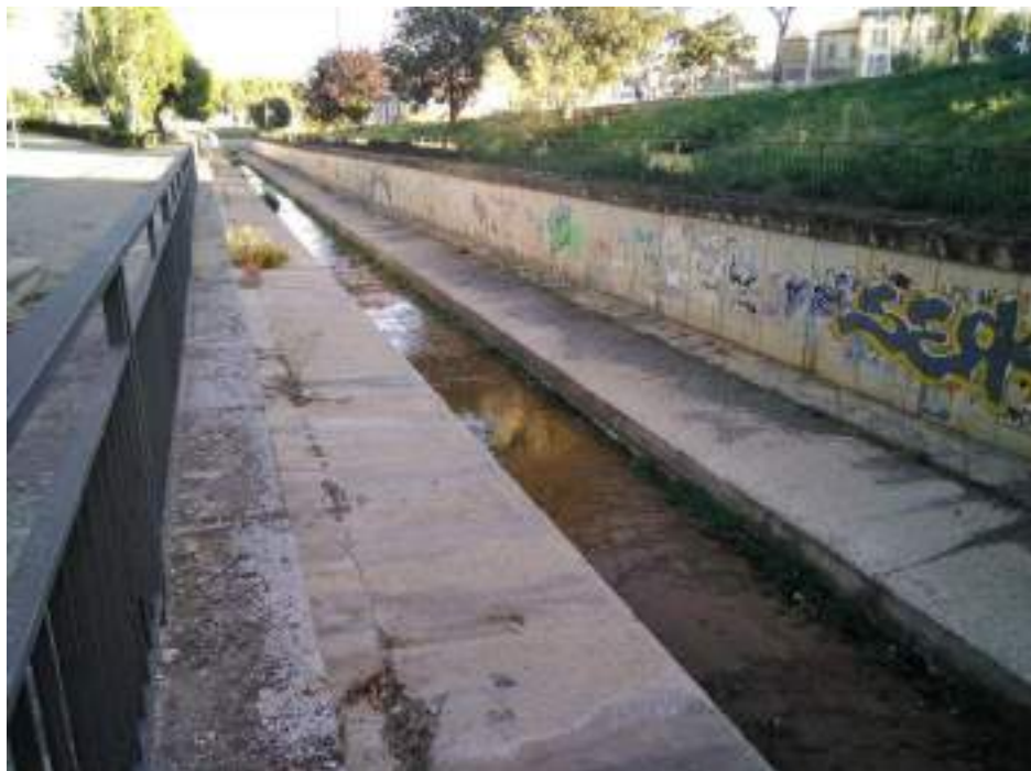
Fotografía nº 6. Tramo A-Sección II. Tramo canalizado de tipo Sección II.
