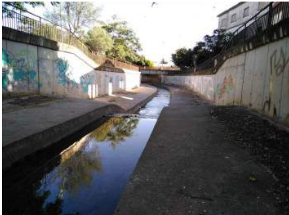
Fotografía nº 12. Tramo A-Sección II. Tramo canalizado de tipo Sección II. Escalón.
