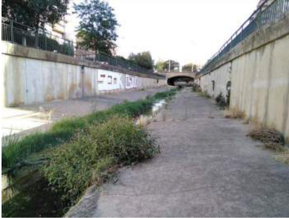
Fotografía nº 11. Tramo A-Sección II. Tramo canalizado de tipo Sección II. Puente sobre el Paseo Ramón y Cajal al fondo.
