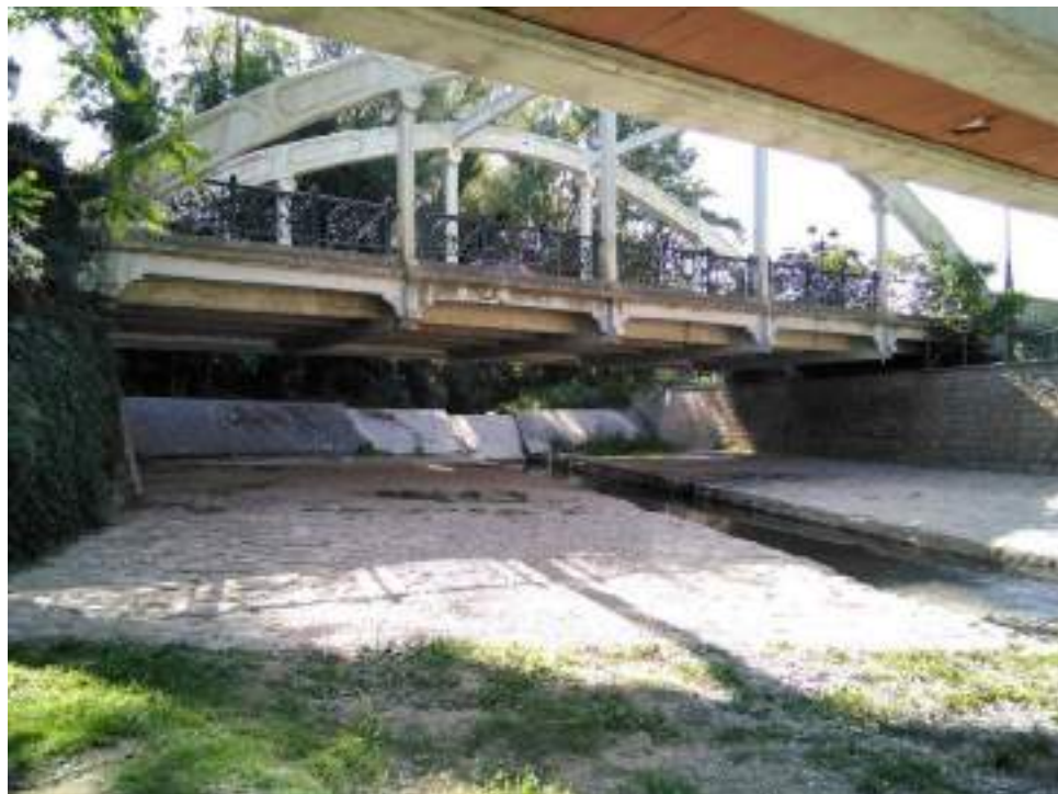
Fotografía nº 2. Tramo A-Sección I. Puente San Miguel y azud al fondo.
