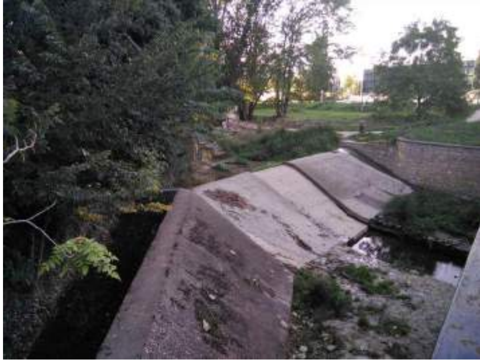
Fotografía nº 1. Tramo A-Sección I. Azud del Puente San Miguel y acequia de Almería.
