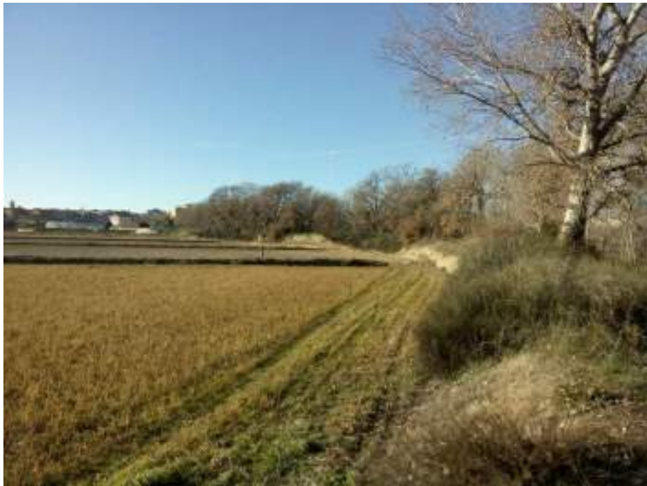
Fotografía nº 21. Tramo B. Mota de tierra artificial sobre la margen derecha.
