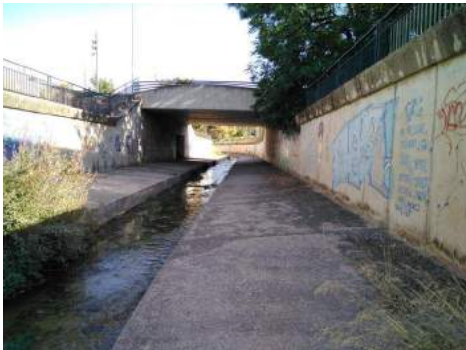
Fotografía nº 8. Tramo A-Sección II. Puente de la Ronda Misericordia, bajo el que confluye el Barranco del Diablo, por la margen izquierda.
