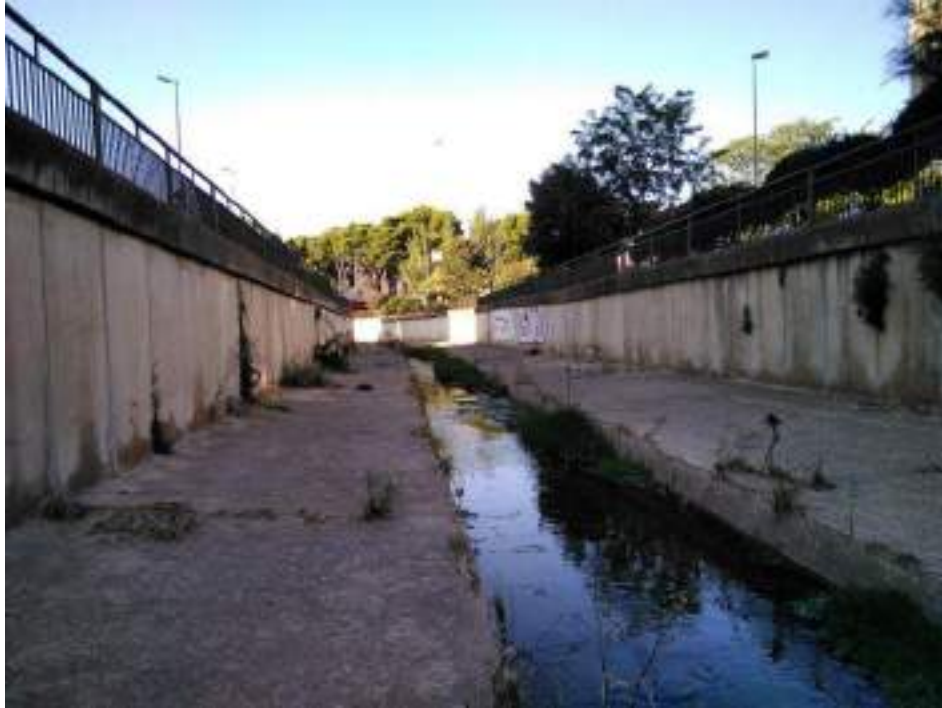
Fotografía nº 7. Tramo A-Sección II. Tramo canalizado de tipo Sección II.
