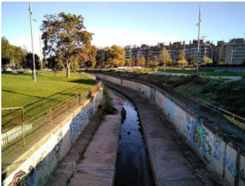
Fotografía nº 10. Tramo A-Sección II. Tramo canalizado de tipo Sección II en el Parque Universidad. Tramo propuesto para la renaturalización de ribera.
