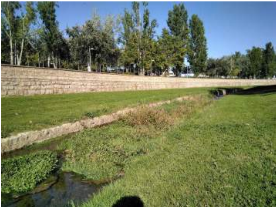
Fotografía nº 4. Tramo A-Sección I. Tramo canalizado de tipo Sección I, desarrollo espontáneo de vegetación.
