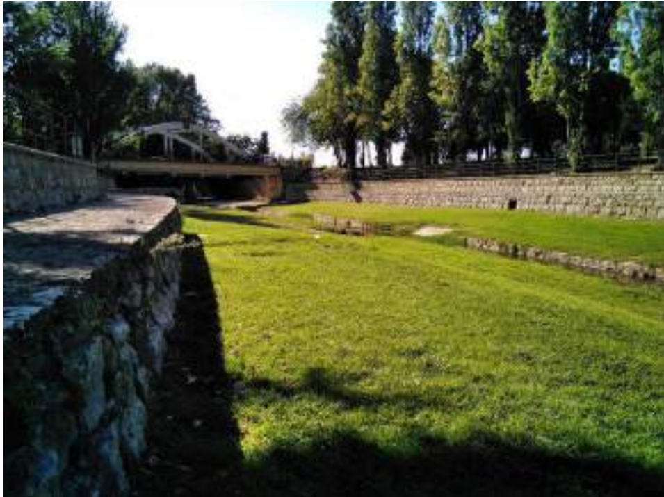
Fotografía nº 3. Tramo A-Sección I. Puente San Miguel y tramo canalizado de tipo Sección I.
