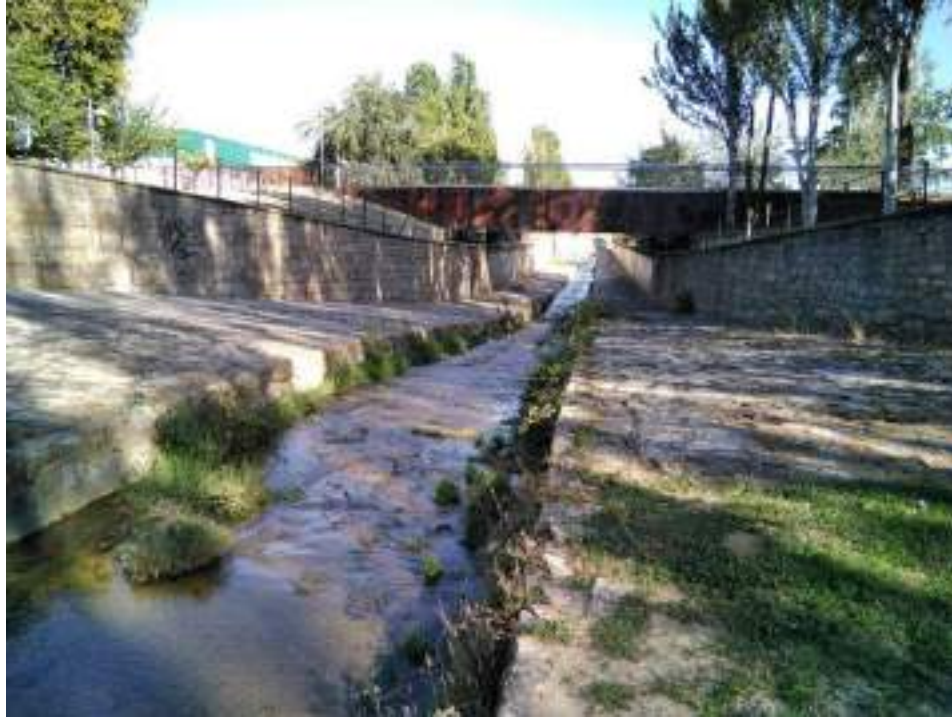
Fotografía nº 5. Tramo A-Sección I-II. Enlace entre tramo canalizado de tipo Sección I y tramo canalizado tipo Sección II. Pasarela peatonal y abastecimiento agua a la ciudad de Huesca.
