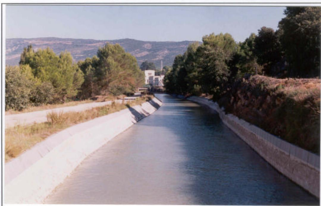
Canal que conduce los turbinados de la central hidroeléctrica situada a pie de presa a la central de Gabet.
