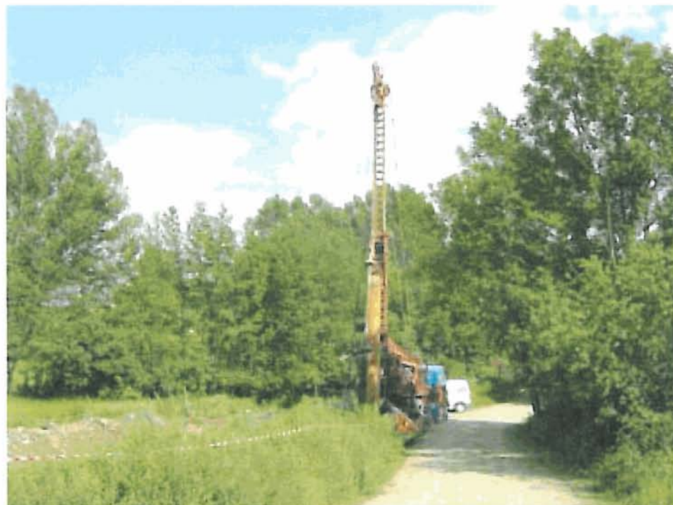
Perforación Sanavastre (7m)
