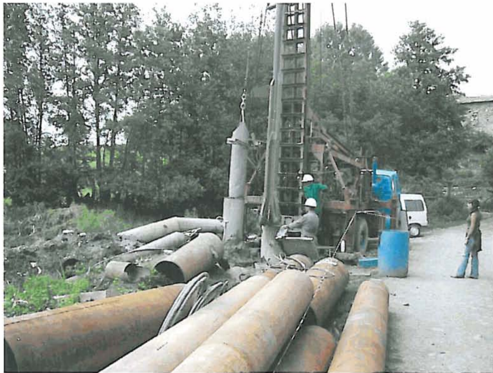
Perforación y evacuación de los detritus y soldadura de las aberturas laterales para colocar la tubería auxiliar.
