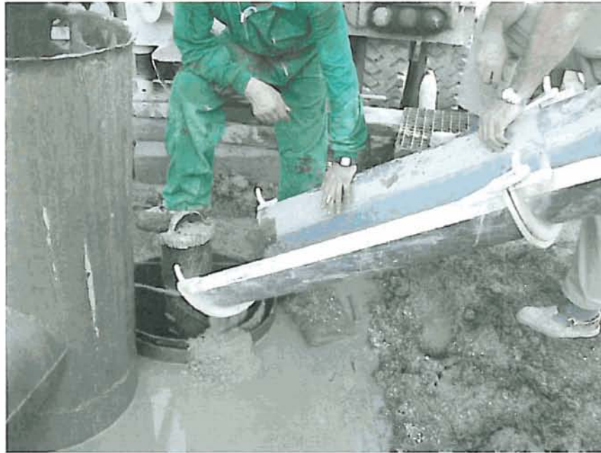
Hormigonado del anular. Abajo: Expulsión del agua empujada por el hormigón.
