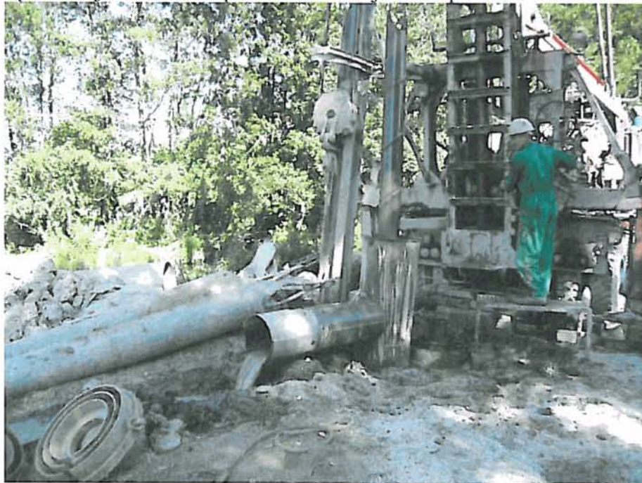
Valvuleo para rebajar el nivel del pozo. Véase la sujeción superior de la tubería de 180 mm.
