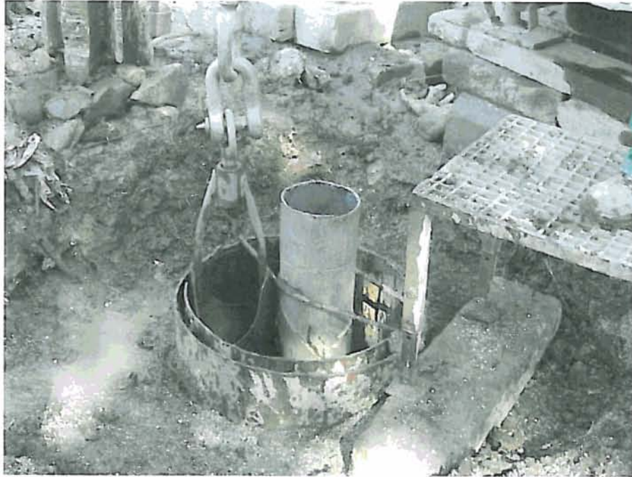
Valvuleo para rebajar el nivel del pozo. Véase la sujeción superior de la tubería de 180 mm.
