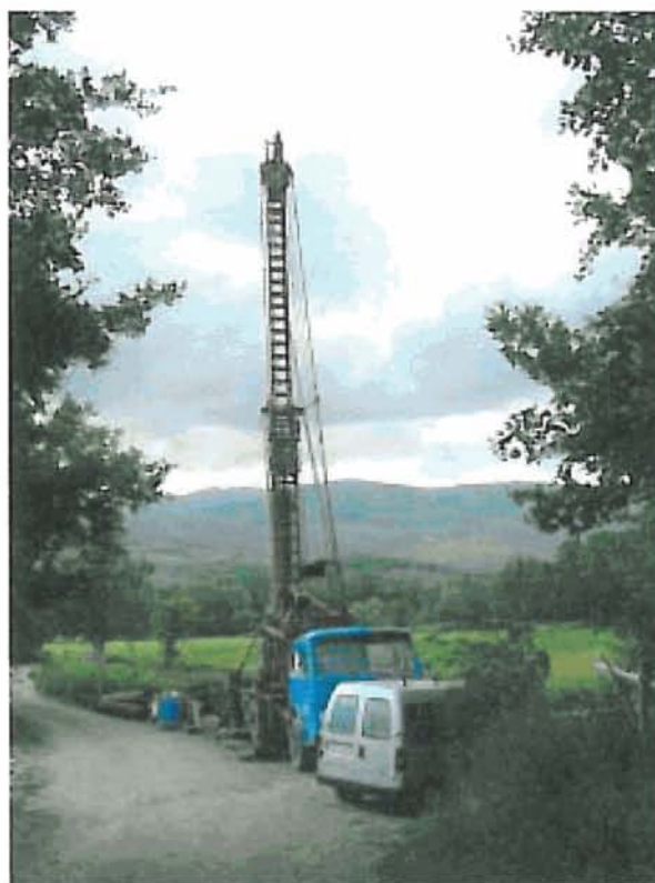
Perforación Sanavastre (7m)
