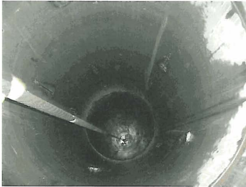
Detalle de la perforación con la tubería auxiliar rajada
