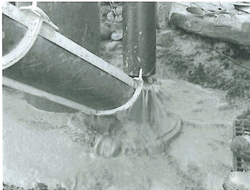
Hormigonado del anular. Abajo: Expulsión del agua empujada por el hormigón.
