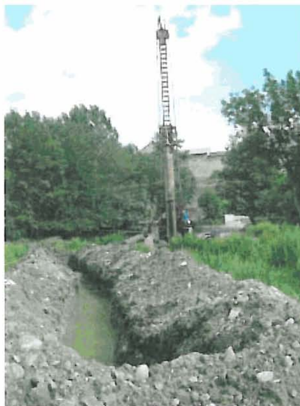
Perforación Sanavastre. Balsa para el detritus. (7m)
