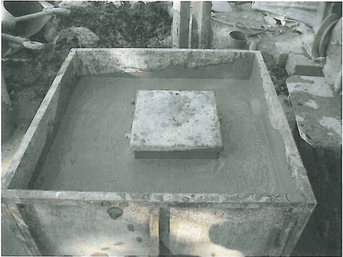
Arqueta recién hormigonada.
