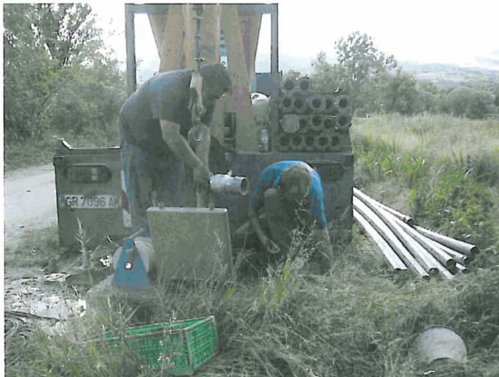
Montaje para el ensayo de bombeo en Sanavastre
