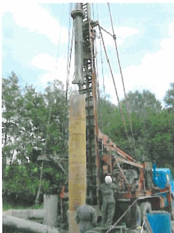
Hincando tubería auxiliar de 600 mm
