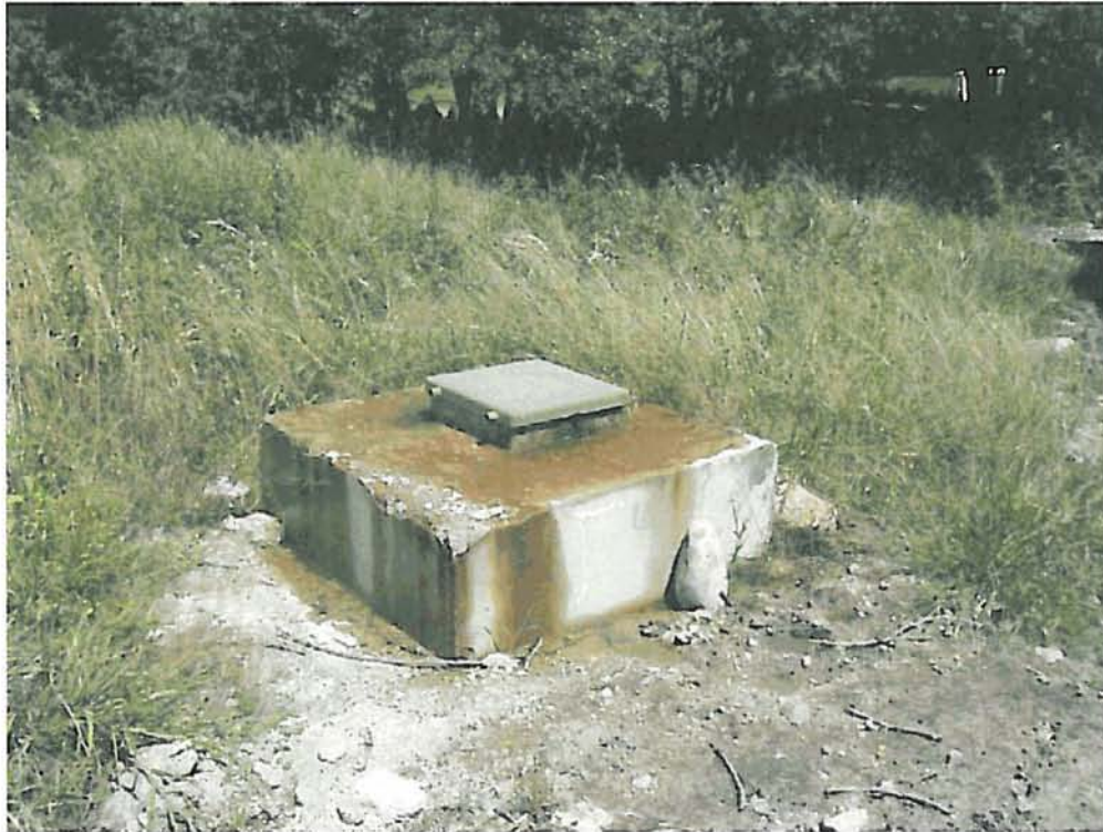
Detalle del piezómetro antes de iniciar la colocación de la tubería. Véase como la surgencia no está controlada.
