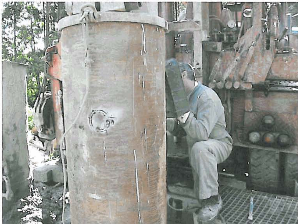
Perforación y evacuación de los detritus y soldadura de las aberturas laterales para colocar la tubería auxiliar.
