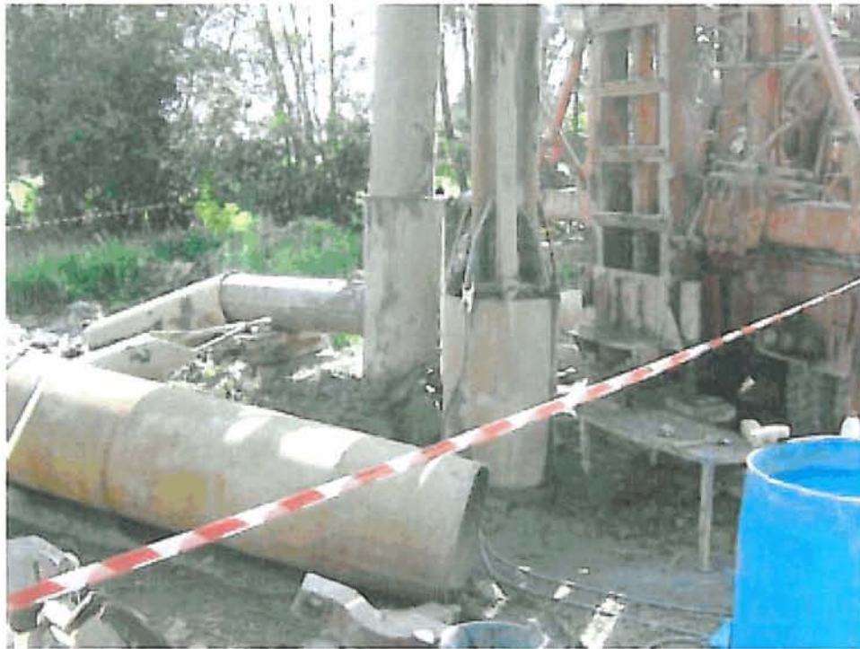
Detalle acondicionamiento del trepano
