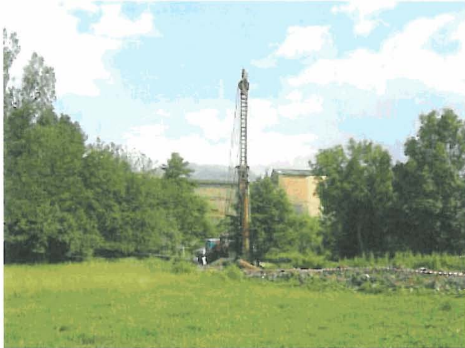
Perforación Sanavastre (7m)
