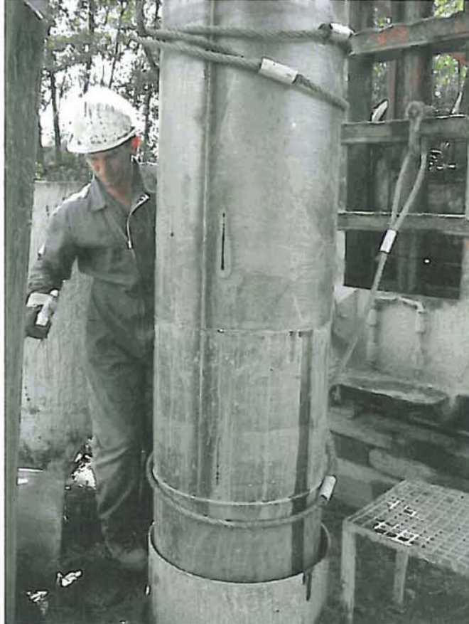
Detalle de la perforación con la tubería auxiliar rajada
