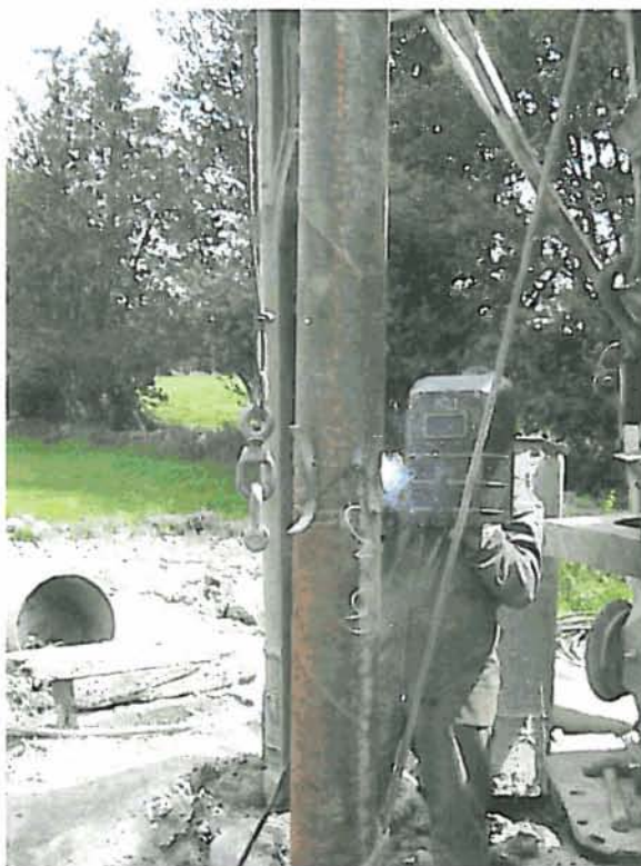
Soldadura de tramos ciegos y colocación de tramo filtrante. Véanse los centradores utilizados para mejorar el posicionamiento de la tubería. Se retiran una vez soldados los tramos.
