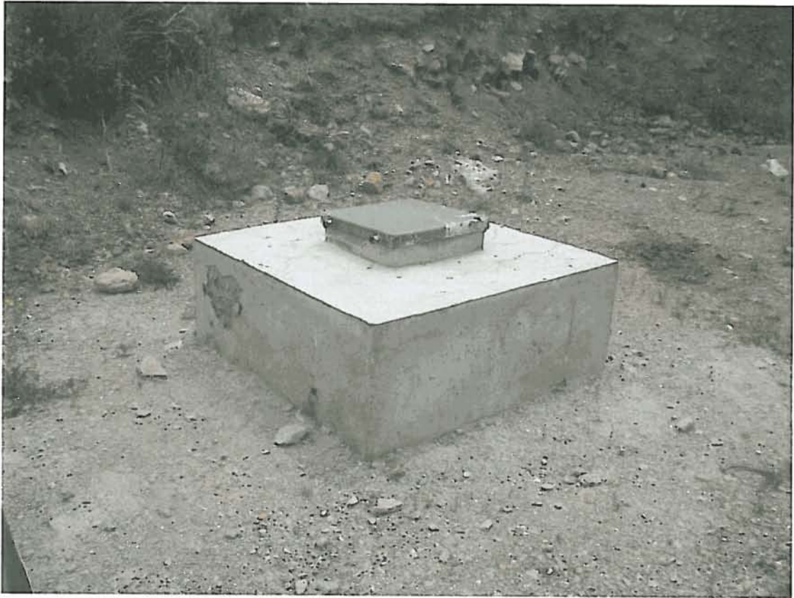
Detalles de la zona agrietada en superficie y de los desperfectos en los laterales.
