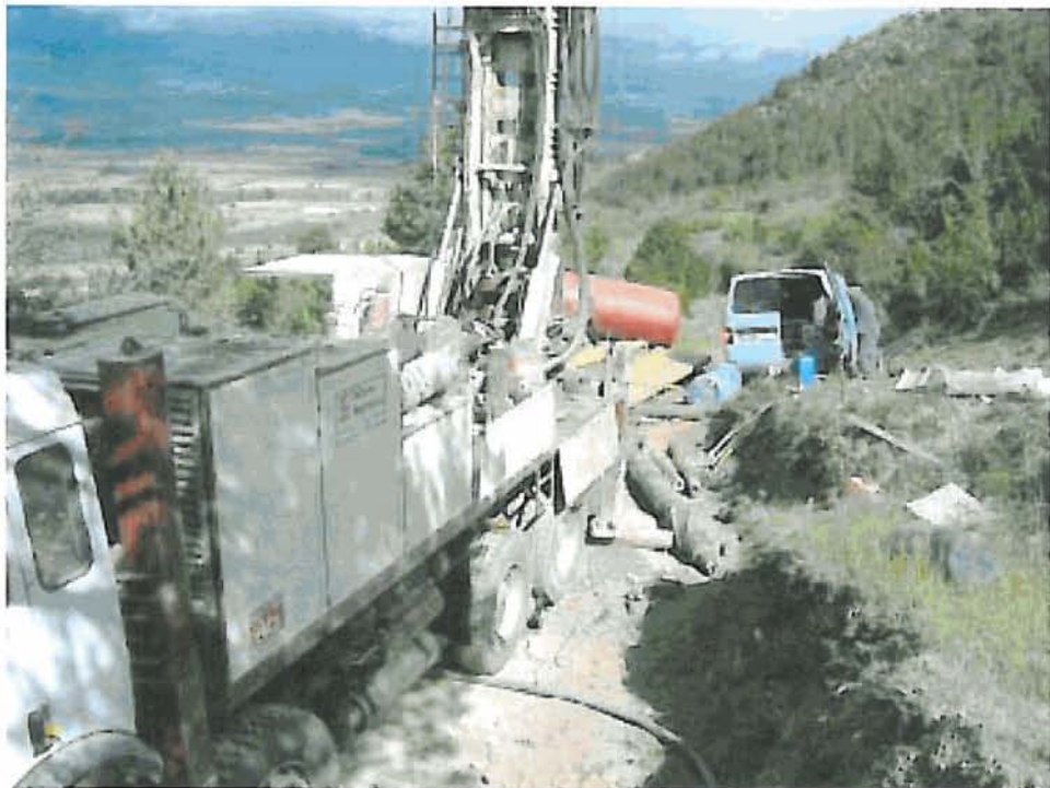
Testificación sondeo de Das 6-10-05 14:00
