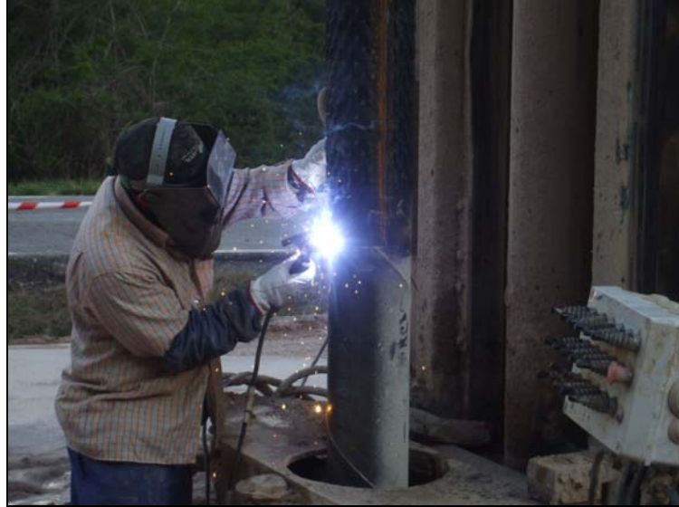
Foto 7. Trabajos de soldadura durante la entubación.
