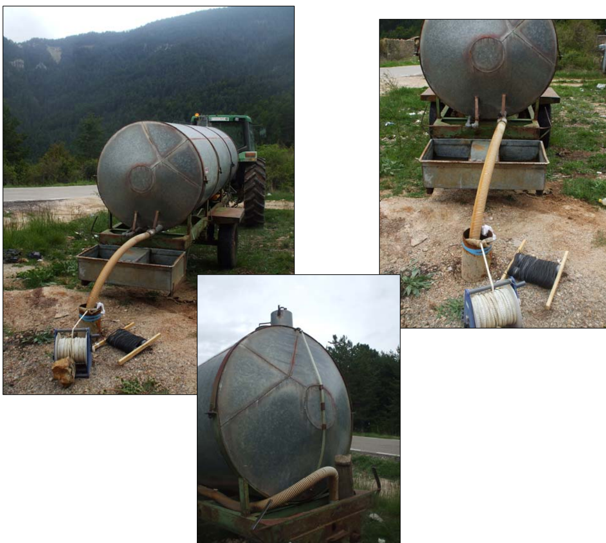
Imágenes 2, 3 y 4. Inyección de agua en el sondeo.
