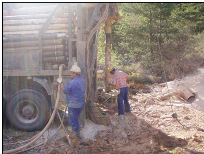
Foto 3. Trabajos de cambio de tallante.
