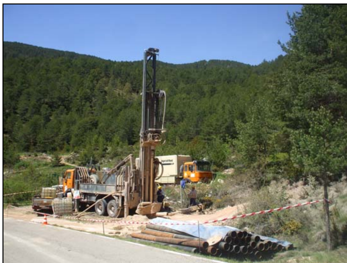
Foto 1. Emplazamiento del sondeo de Josa i Tuixent..
