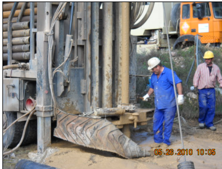
Foto 2. Perforación en el sondeo de Josa i Tuixent.
