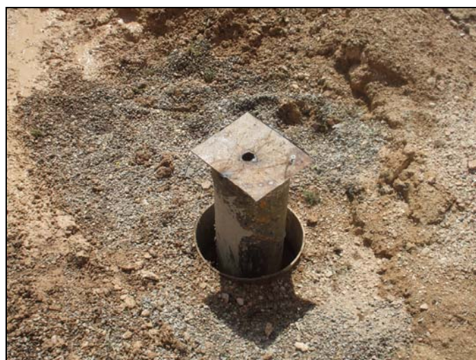
Foto 9. Cierre provisional del sondeo.
