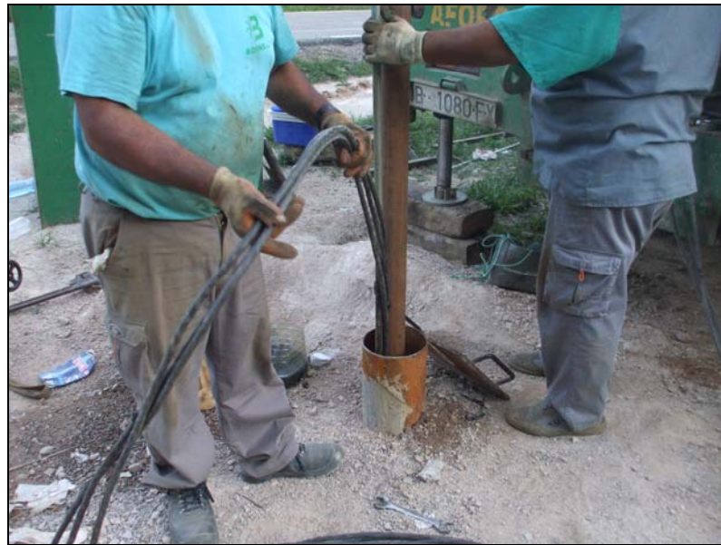
Imagen 2. Instalación del equipo de bombeo.
