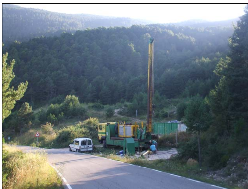
Imagen 1. Situación del equipo de aforo en el sondeo.
