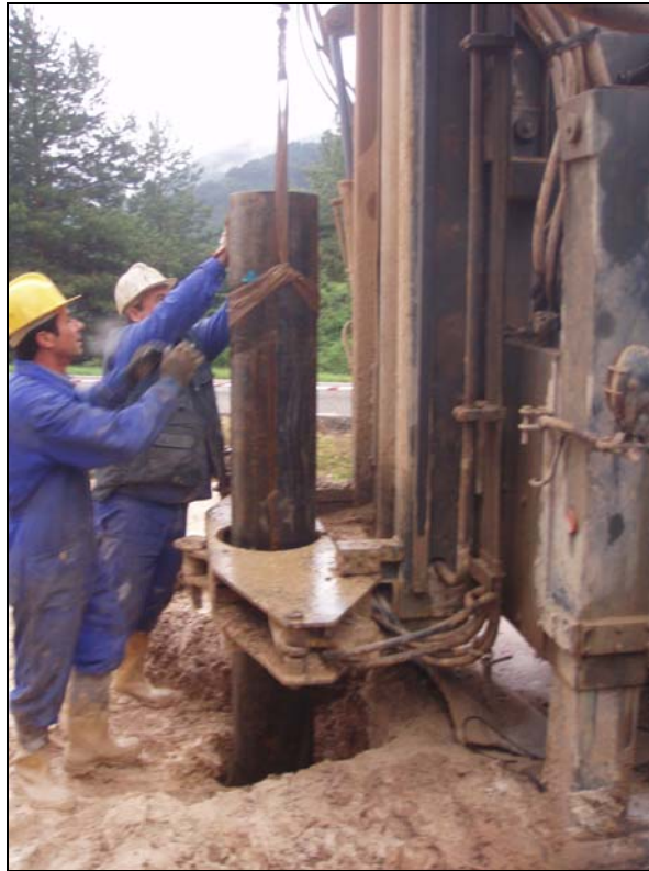
Foto 4. Labores de instalación del otro tramo de tubería auxiliar.
