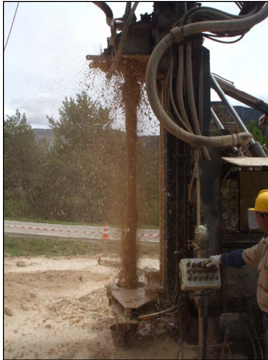
Foto 8. Limpieza del sondeo.
