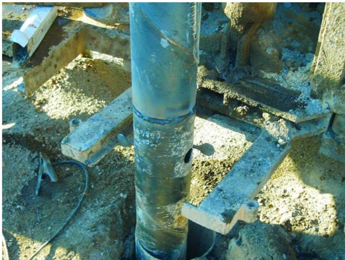
Tubería ciega con orejetas abiertas y soldadura
