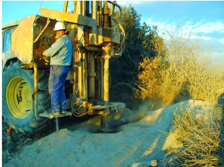
**Perforando con el martillo de 220 mm**
