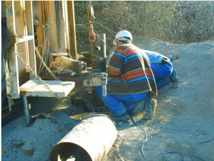
**Introduciendo un tramo de tubería ciega**
