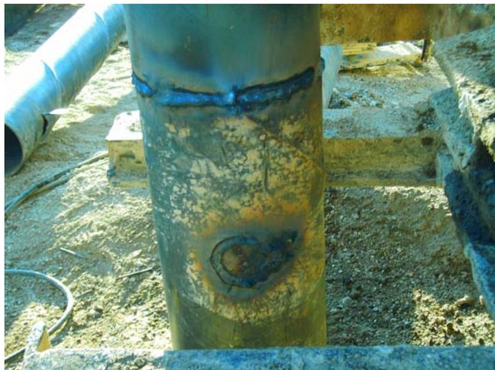
**Soldadura en orejeta y entre tuberías**
