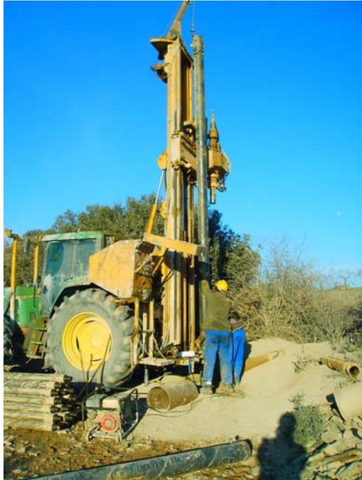
**Colocando un tramo de tubería ciega de 6 m para ser soldado**
