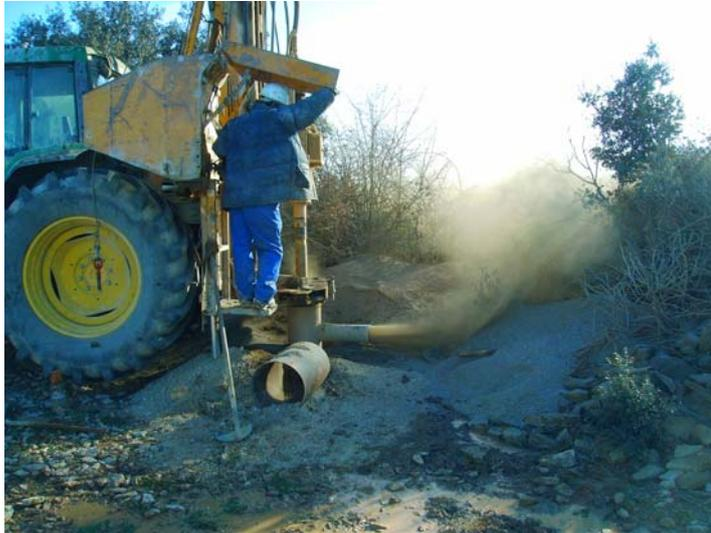
**Perforando con el martillo de 220 mm, a unos 110 m de profundidad**
