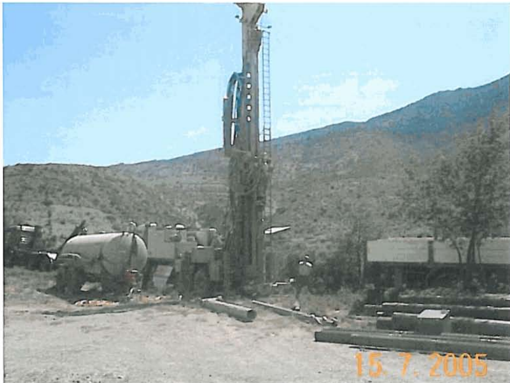
DETALLES DE LA PERFORACIÓN Y DEL EMPLAZAMIENTO.
