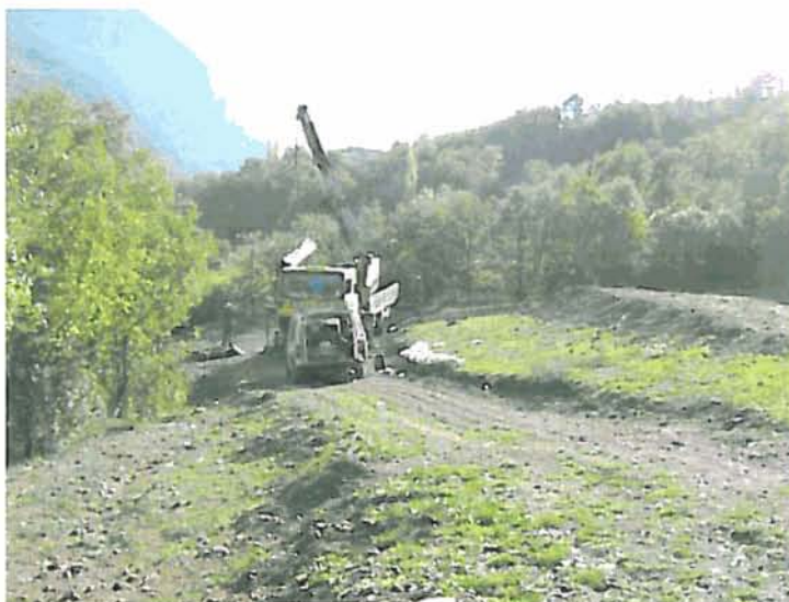
Vista del emplazamiento y la maquinaria
