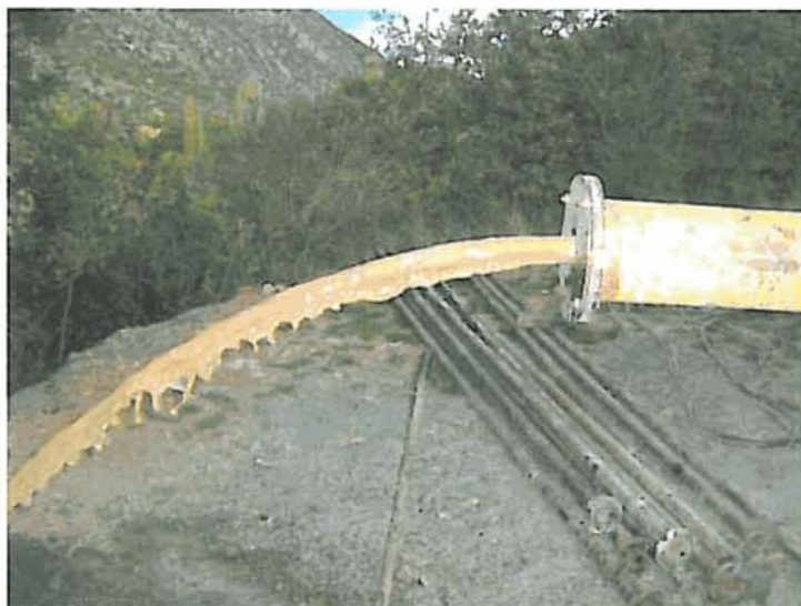
Comienzo tercer escalón (agua muy turbia, 4 l/s)
