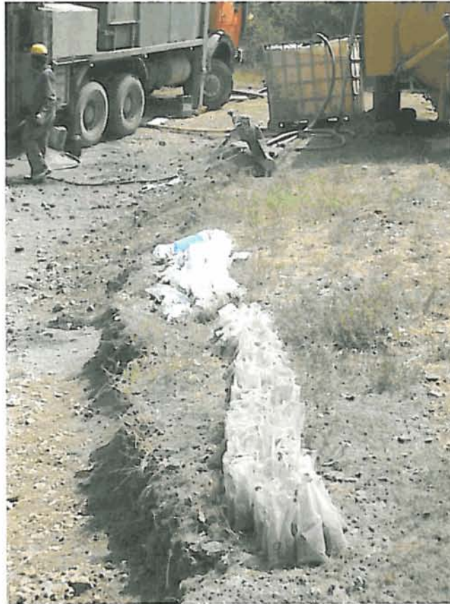
Muestra obtenidas durante la perforación
