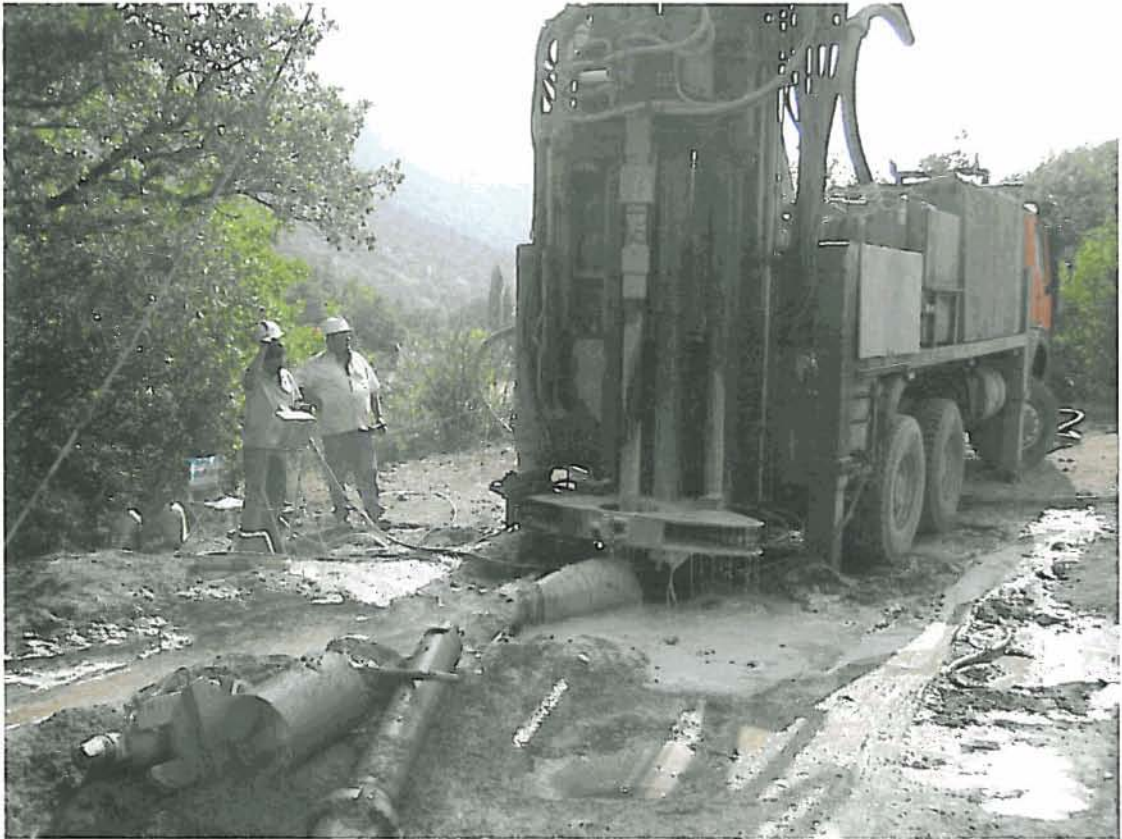
Detalle de la perforación en los últimos metros.
