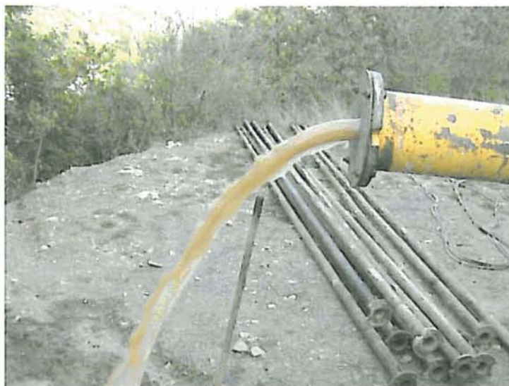
Segundo escalón (agua muy turbia, 2 l/s)
