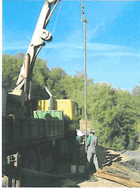
Introduciendo la tubería
