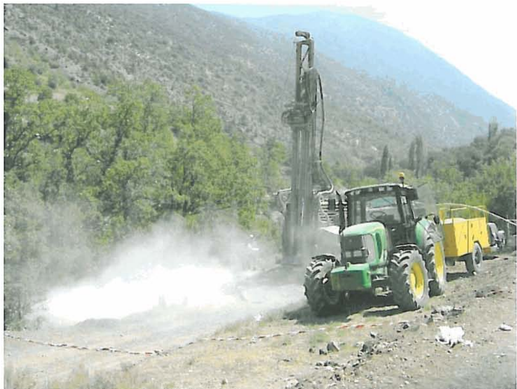
Cabó perforación en 25 m
