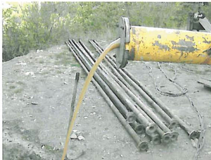
Agua muy turbia durante el primer escalón (1 l/s)
