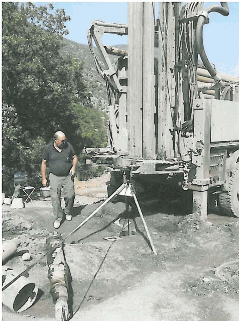
Montaje de la testificación geofísica.
