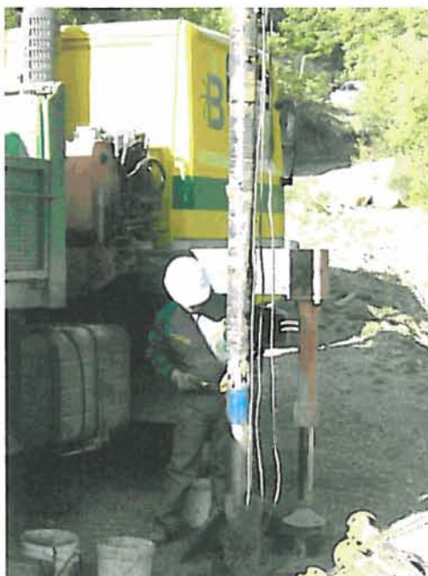
Introduciendo la bomba
