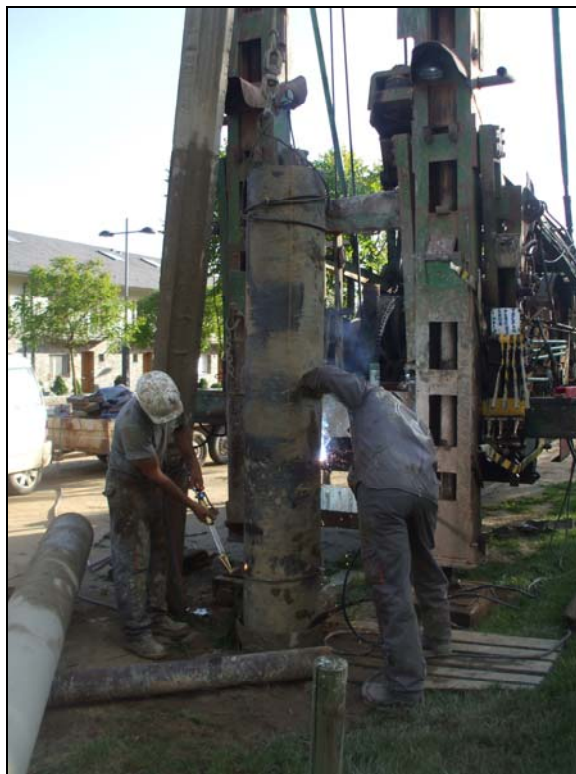
Imagen 3. Colocación de la tubería auxiliar.
