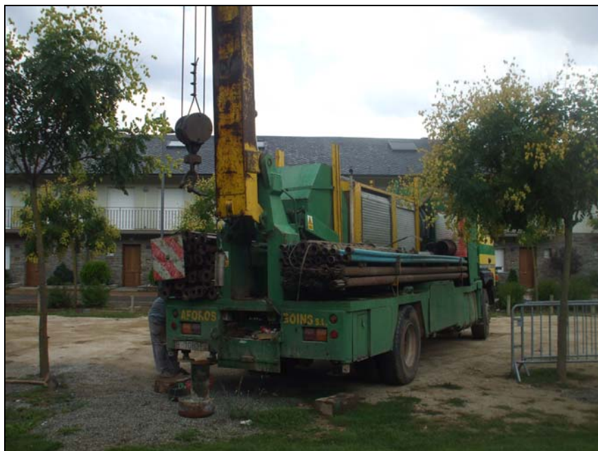
Imagen 1. Situación del equipo de aforo en el sondeo.
