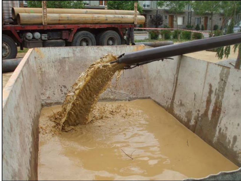
Imagen 11. Realización de limpieza mediante valvuleo.
