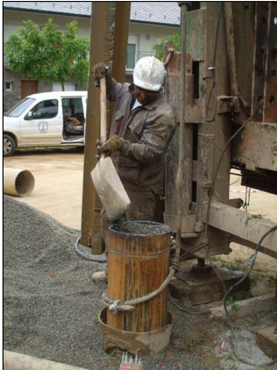
Imagen 10. Engravillado del sondeo.
