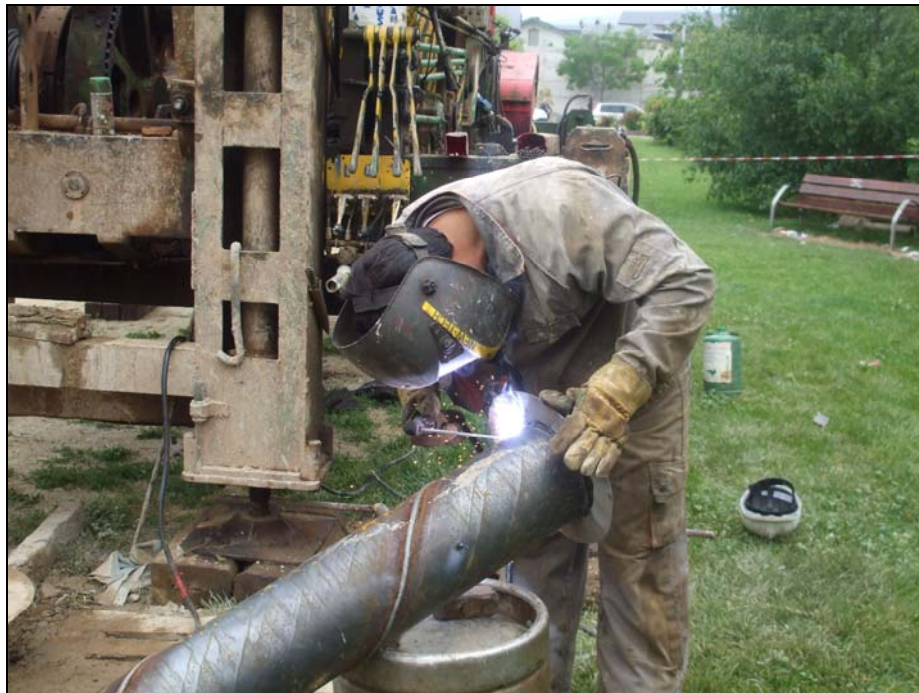
Imagen 8. Colocación de la tapa de fondo en la tubería.
