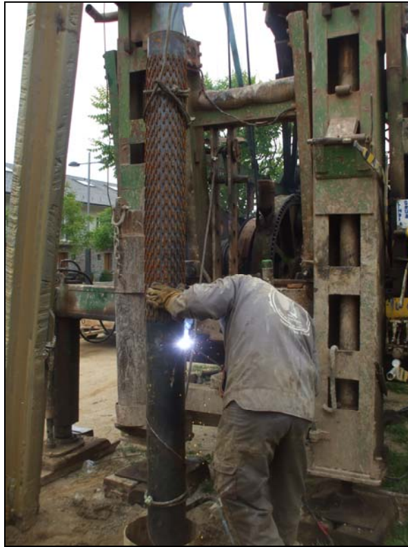
Imagen 9. Trabajos de soldadura durante la entubación.
