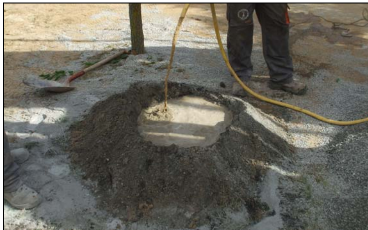
Imagen 12. Reparación de la masa para el cementado del sondeo.
