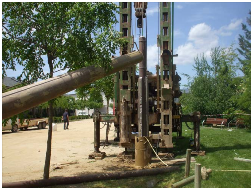
Imagen 2. Trabajos de perforación en el sondeo.
