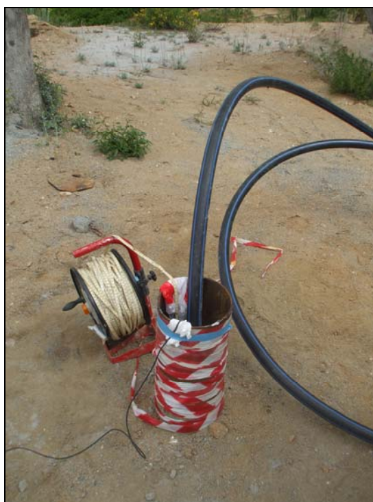
Imagen 1. Inyección de agua en el sondeo.
