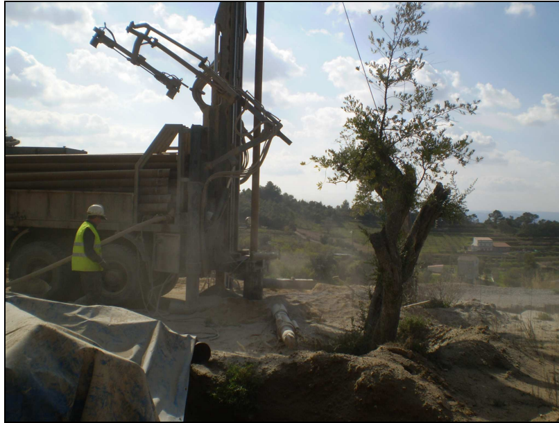
Imagen 3. Perforación del sondeo con un diámetro de 220 mm.
