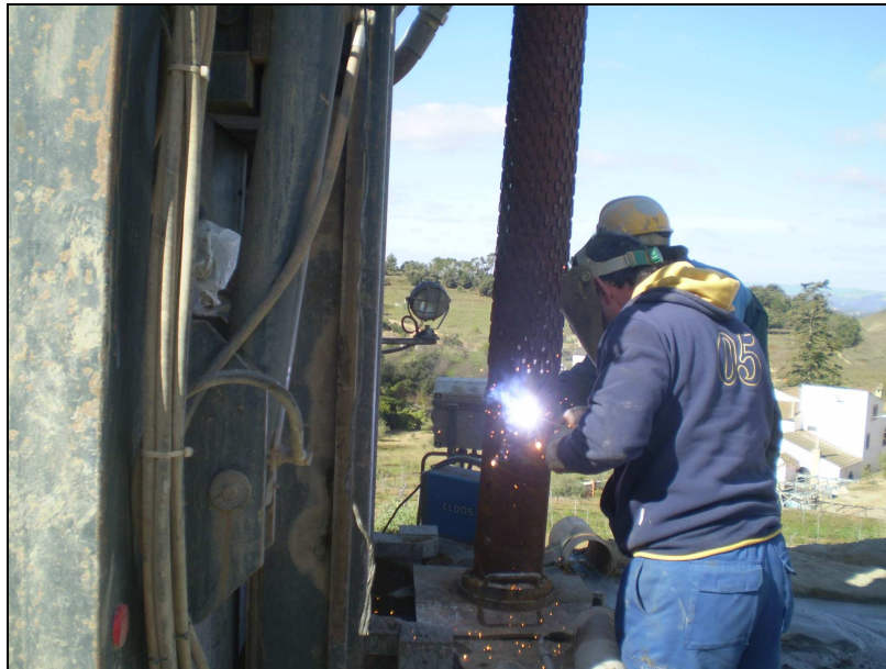
Imágenes 5 y 6 . Trabajos de entubación del sondeo (colocación y soldadura).
