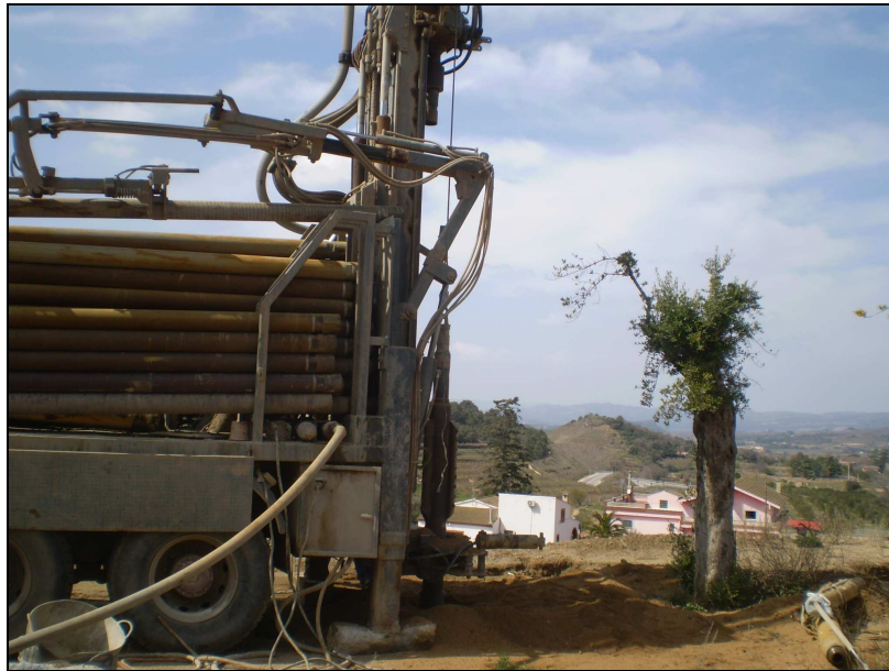
Imagen 2. Perforación de emboquille.
