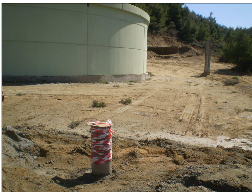
Imagen 7. Aspecto del cierre provisional del sondeo de Falset.
