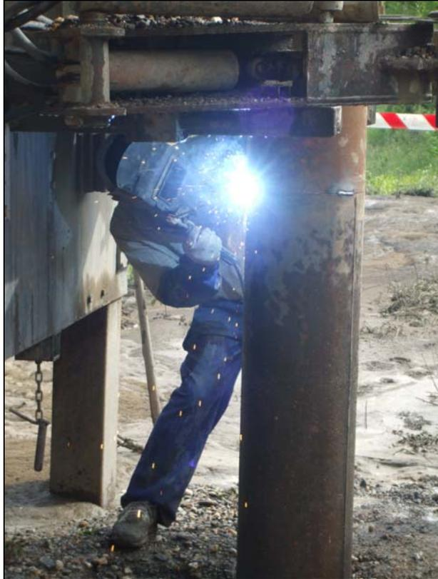
**Imagen 4.** Soldadura de la tubería de emboquille.
