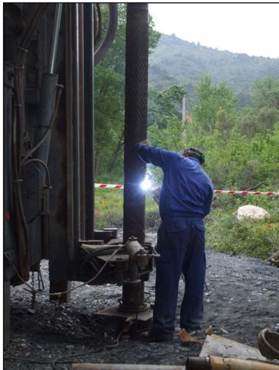
**Imagen 9.** Trabajos de soldadura durante la entubación.
