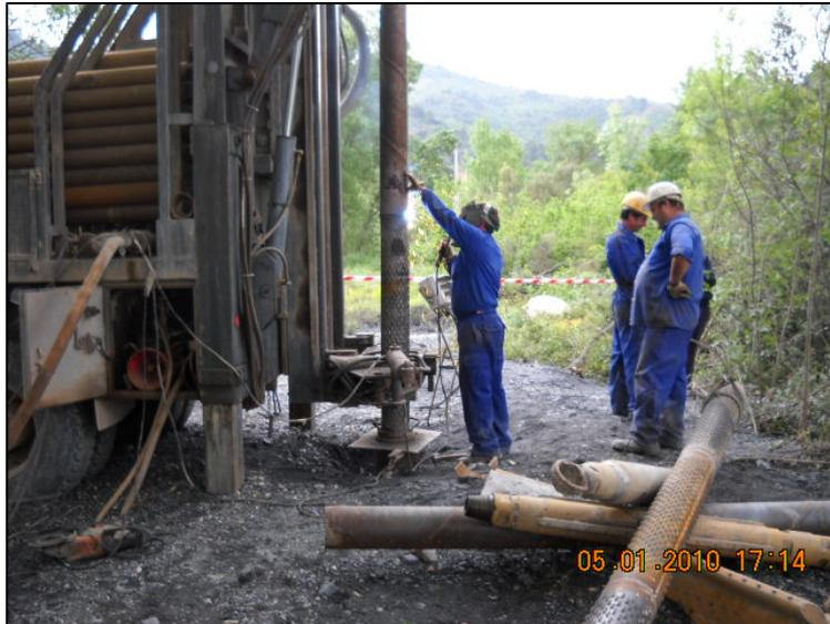
Fig.8. Soldadura de los tubos durante la entubación
