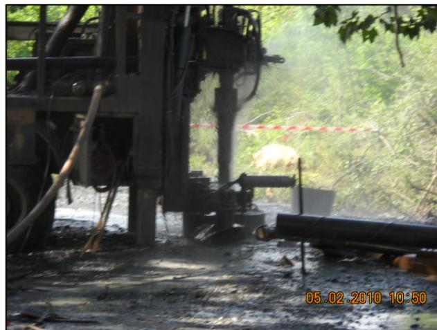
Fig.9. Limpieza del Sondeo de Poboleda.
