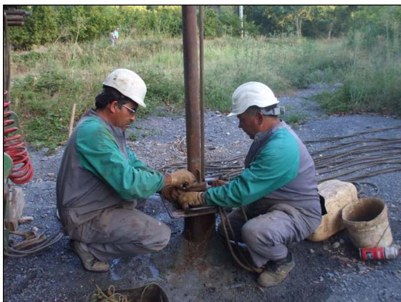
**Imagen 3.** Instalación de la tubería de impulsión.
