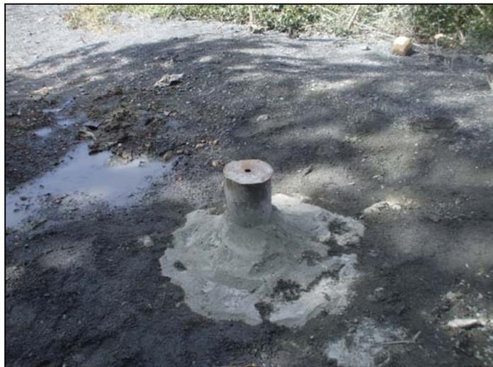
*Imagen 12. Cementación del sondeo.*
