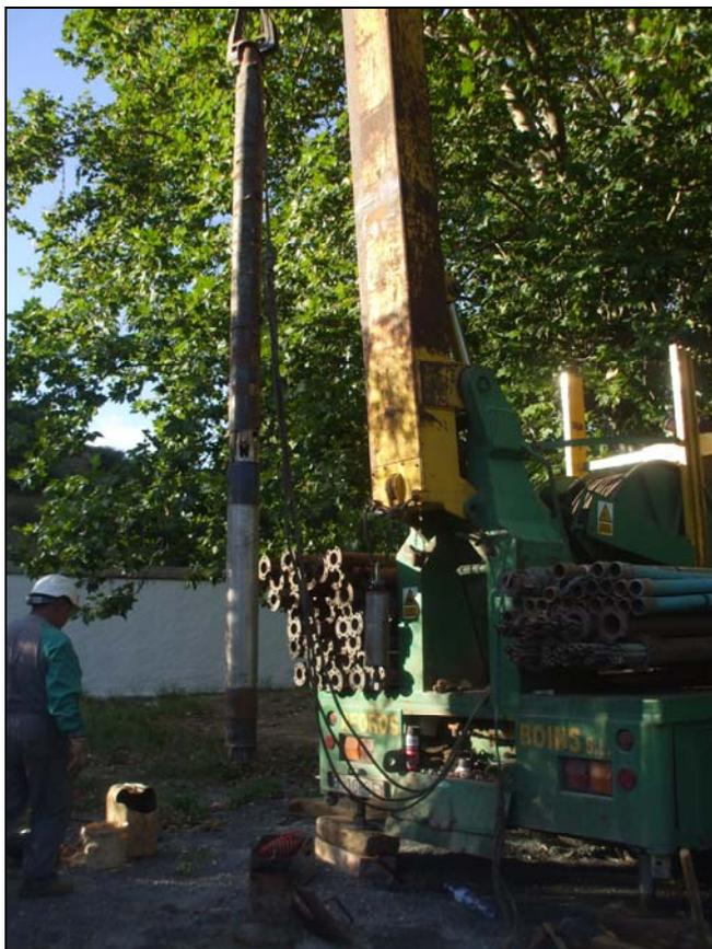
**Imagen 2.** Bomba introducida en el sondeo.
