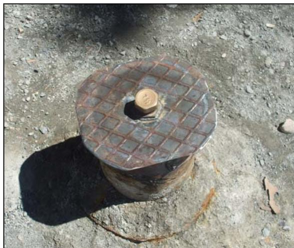
**Imagen 8.** Colocación de una tapa con tapón.
