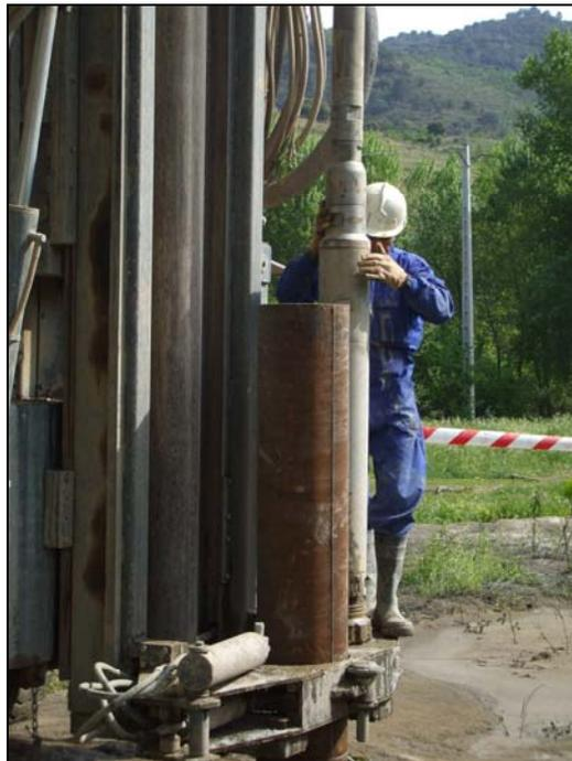
**Imagen 5.** Colocación de martillo de 280 mm para introducirlo por el interior de la tubería de emboquille.
