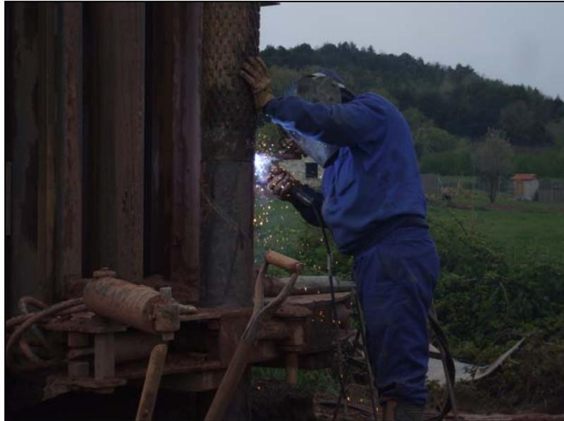
*Imagen 7. Trabajos de soldadura durante la entubación.*
