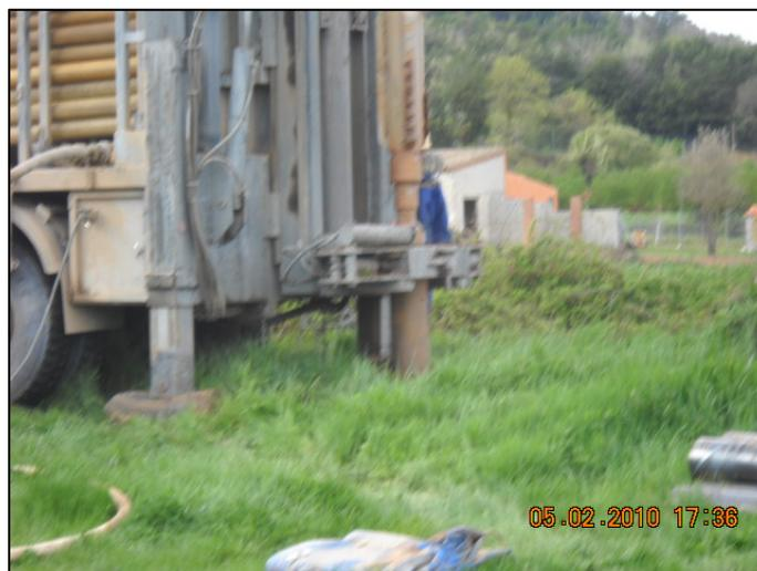
Durante las mismas se observa como se producen algunos aportes de agua a partir de los 2 a 3 metros y que se derrumban las paredes del sondeo entorno a los 6 metros, por lo que se decide seguir perforando con este diámetro hasta los 9 metros y procediendo a entubar después. Posteriormente se procede a reperforar por el interior del emboquille hasta alcanzar los 12 metros, terminando las labores hacia las 19 horas y 30 minutos.
