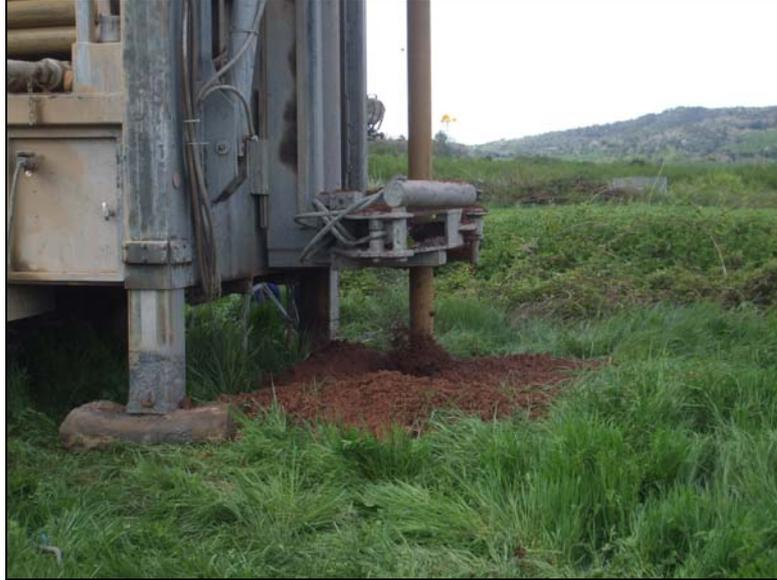
*Imagen 2. Perforación del emboquille.*
