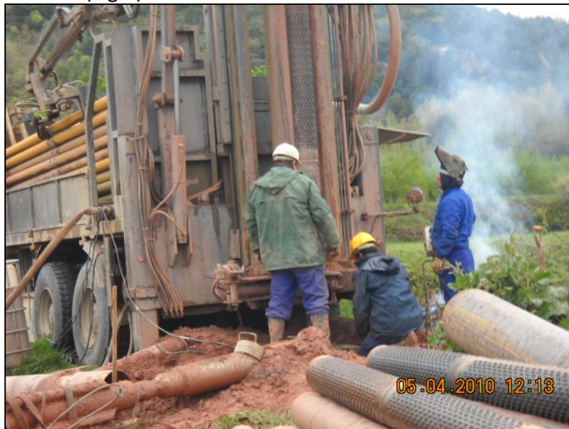
Fig.8. Labores de Soldadura de los tramos filtrantes y ciegos.
