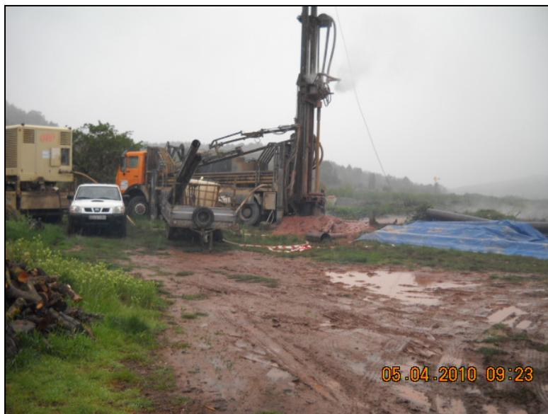
Fig.4. Labores de perforación del sondeo de Prades.
