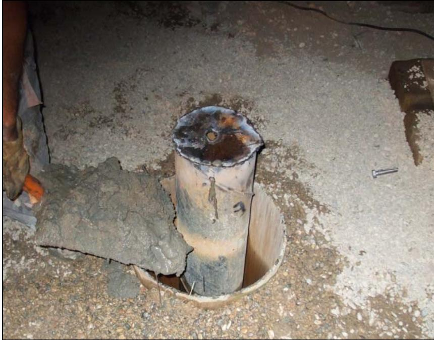
**Imagen 13.** Realización del cementado del sondeo.
