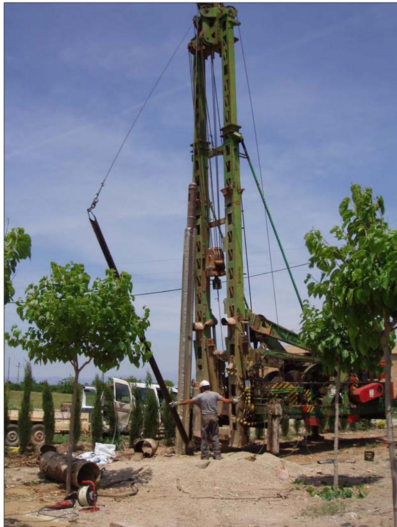
*Imagen 12. Realización de limpieza mediante valvuleo.*
