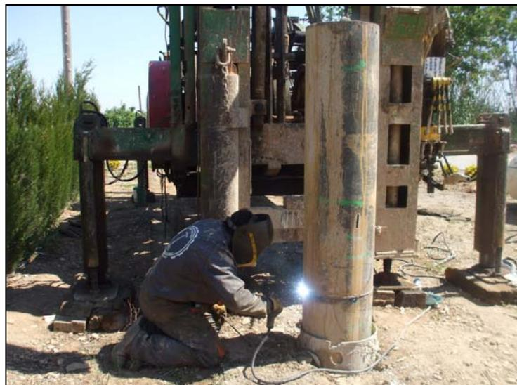
*Imagen 5. Detalle de la soldadura de la tubería auxiliar.*
