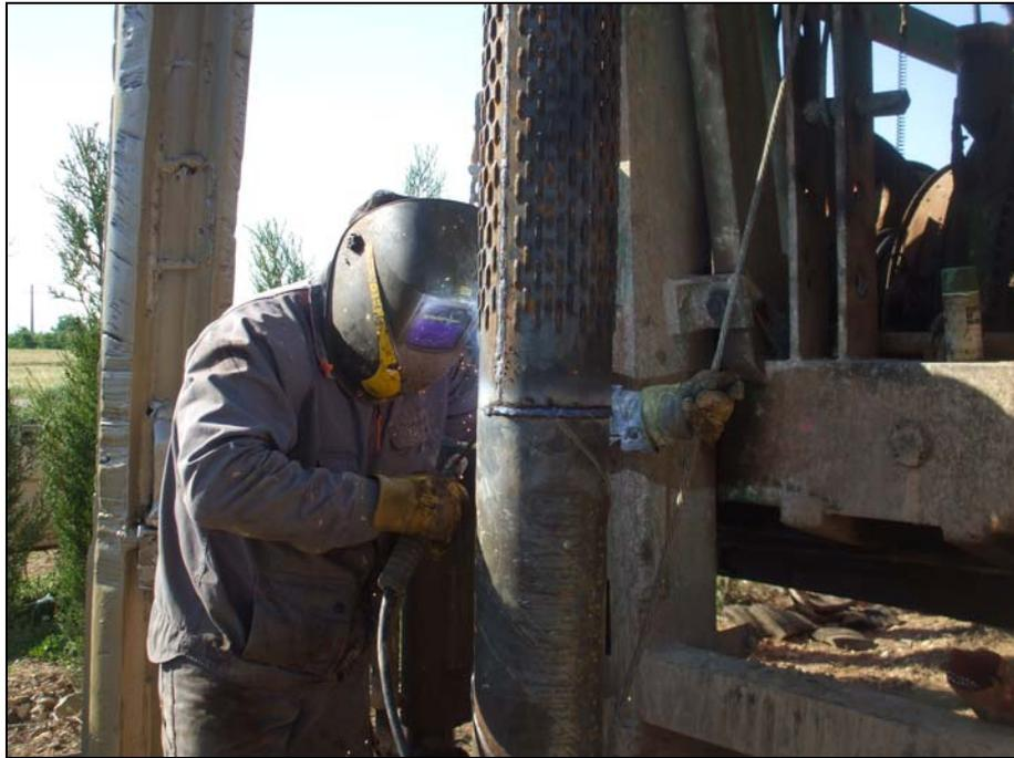
*Imagen 6. Trabajos de soldadura durante la entubación del sondeo.*
