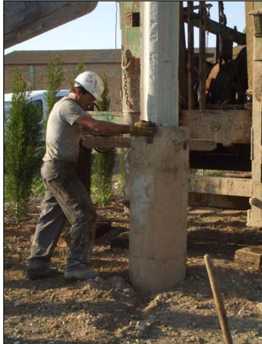
*Imagen 4. Perforación por el interior de la tubería auxiliar.*
