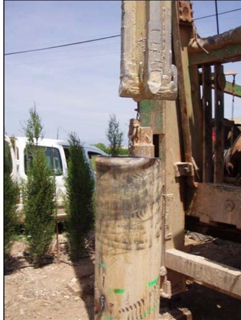
**Imagen 10.** Deformación de la tubería durante los trabajos de extracción de la misma.
