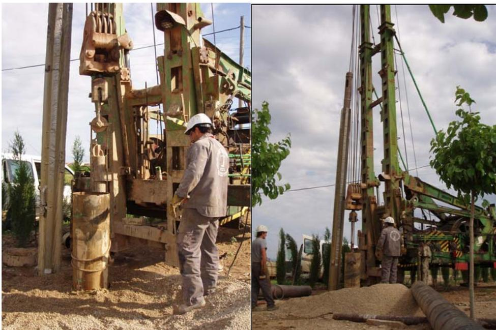
*Imágenes 8 y 9. Tareas de retirada de la tubería de auxiliar.*
