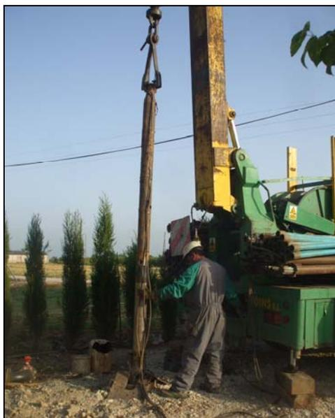
**Imagen 2.** Colocación de la bomba.
