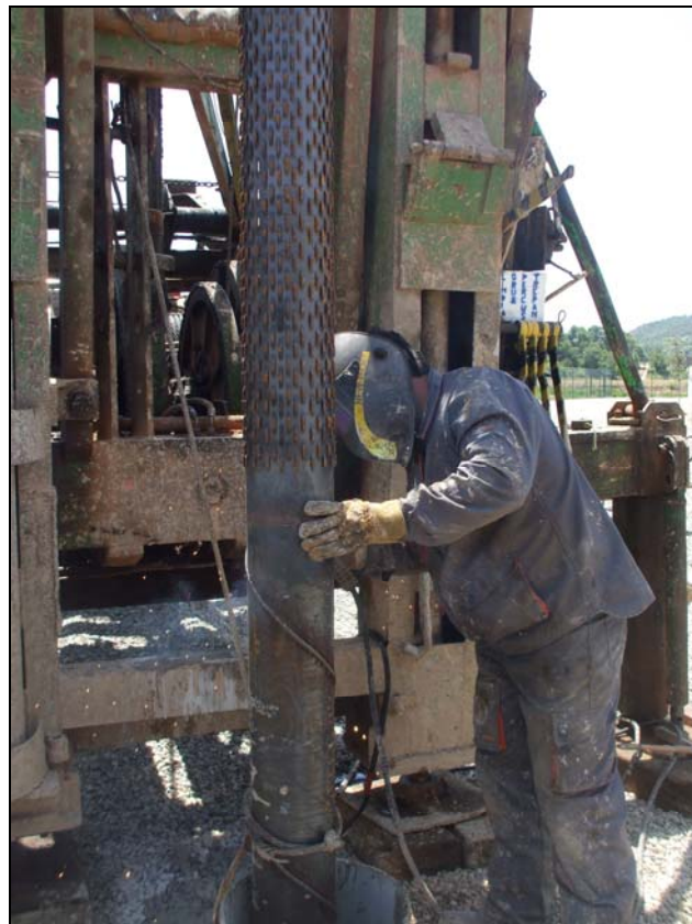
Imagen 7. Trabajos de soldadura durante la entubación.
