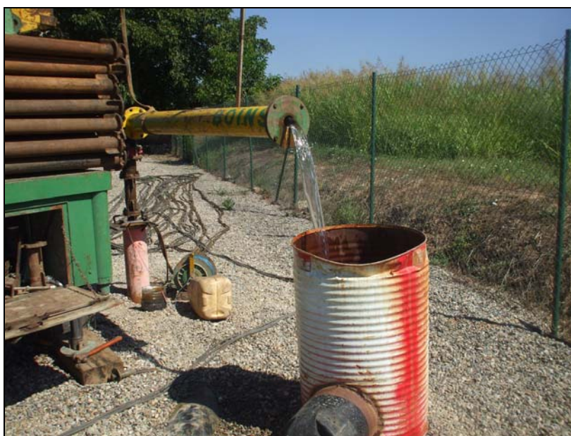
Imagen 9. Caudal extraído durante el cuarto escalón (escalón de larga duración), al final del mismo.
