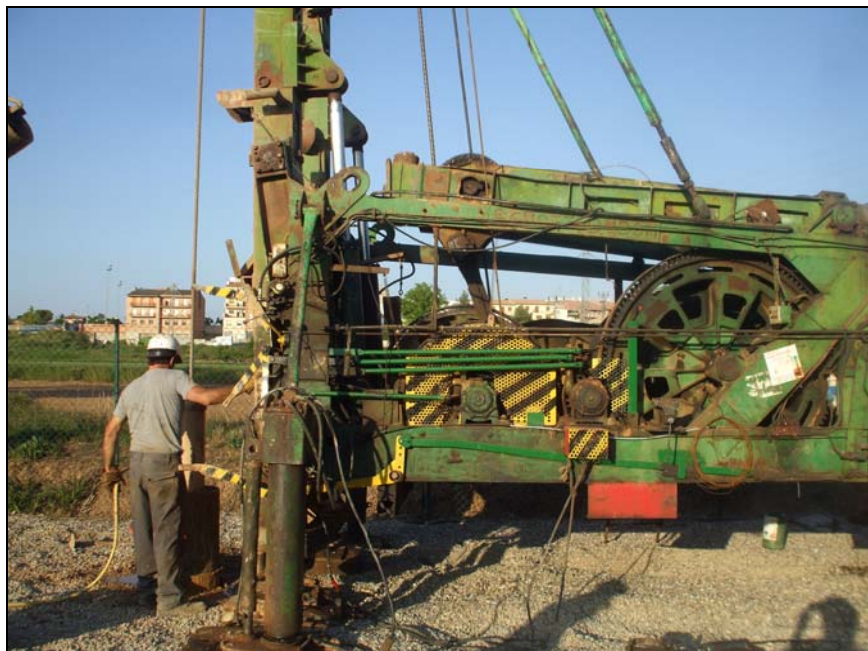
Imagen 2. Trabajos de perforación en el sondeo.
