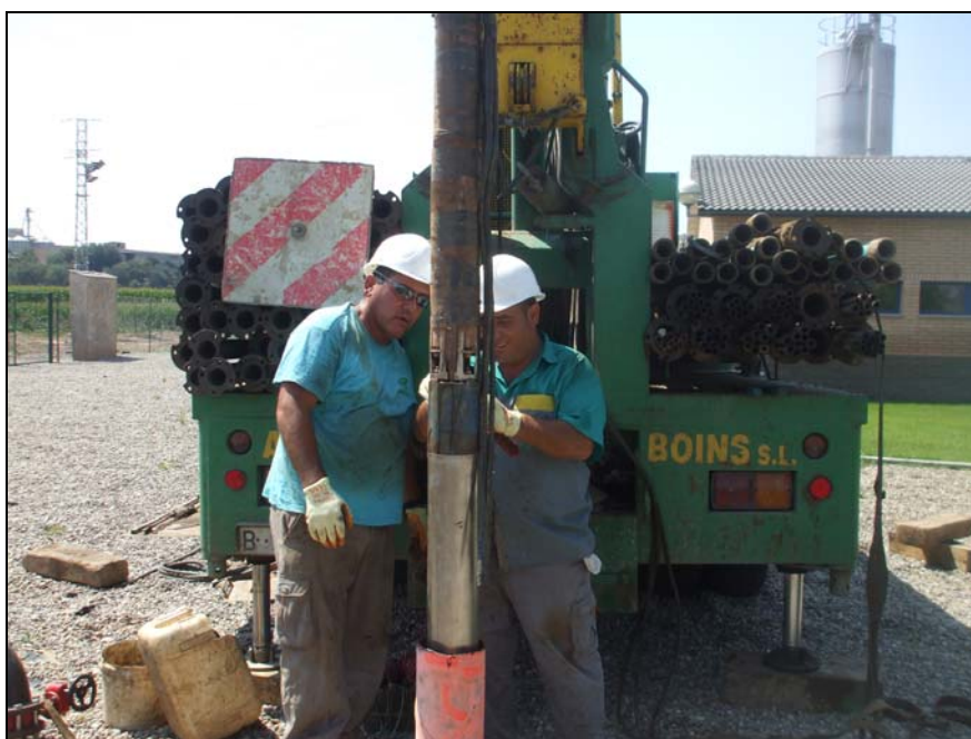
Imagen 2. Instalación del equipo de bombeo.
