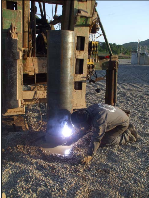
Imagen 3. Detalle de la soldadura de la tubería auxiliar.
