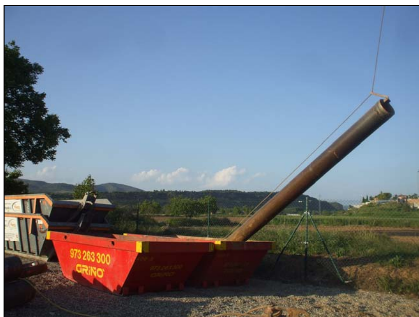
Imagen 4. Vaciado de la cuchara con el detritus obtenido durante la perforación.
