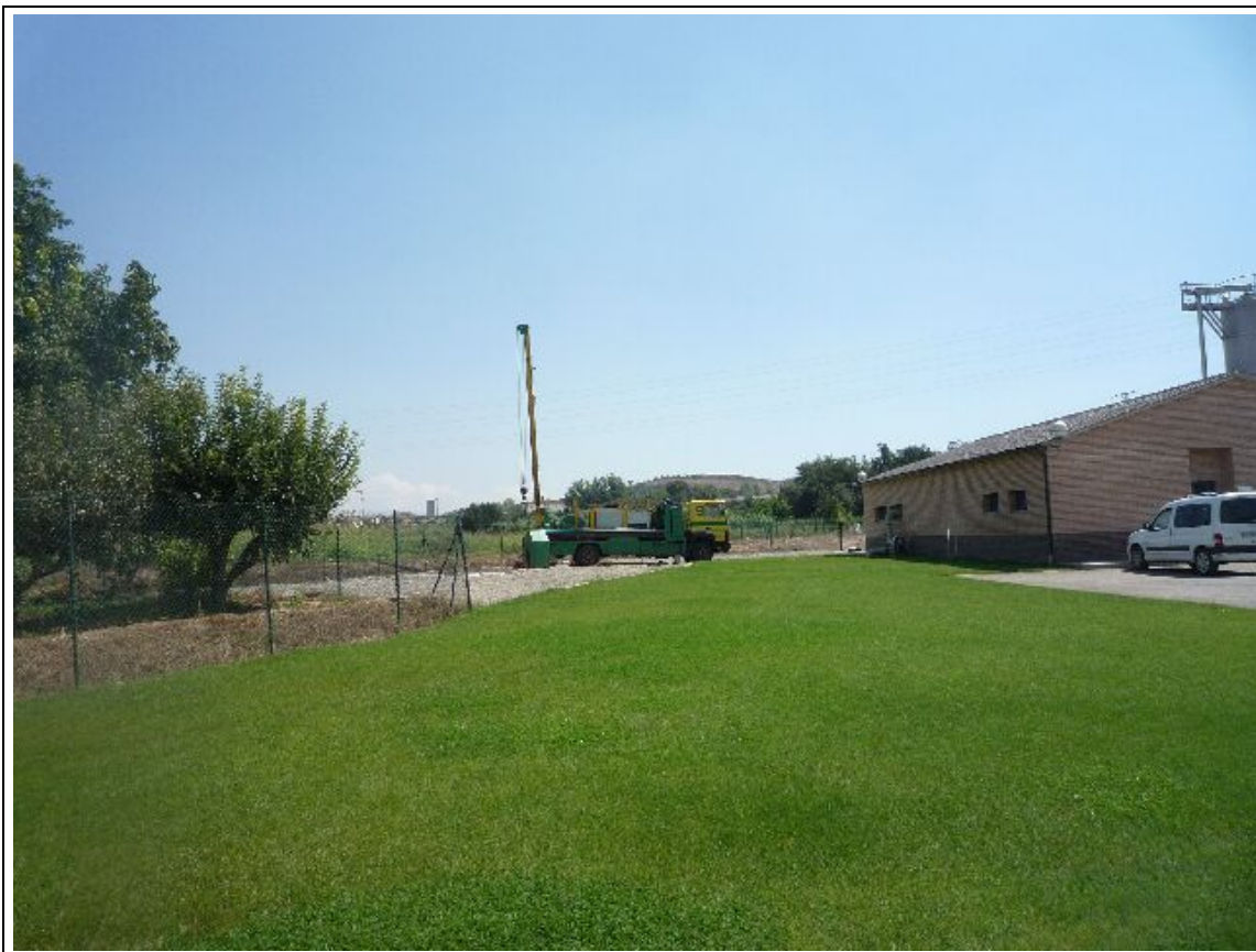
Vista general ensayo de bombeo (01/09/2010)
