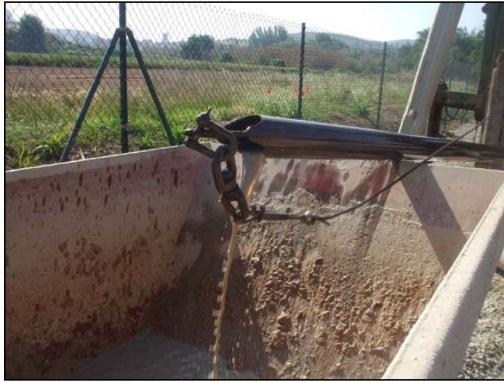
Imagen 9. Realización de limpieza mediante valvuleo.
