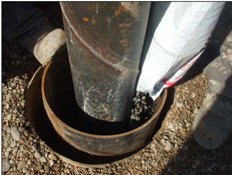
Imagen 8. Colocación del compactonit.
