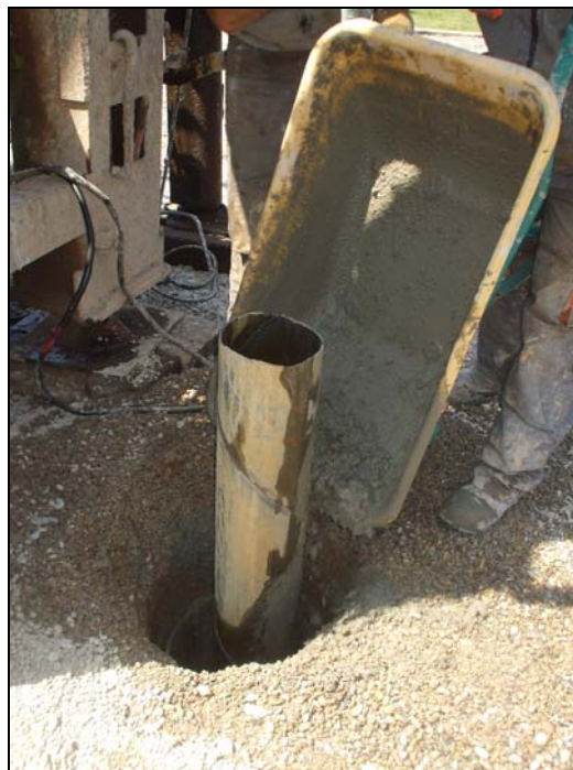
Imagen 10. Cementación del emboquille del sondeo.
