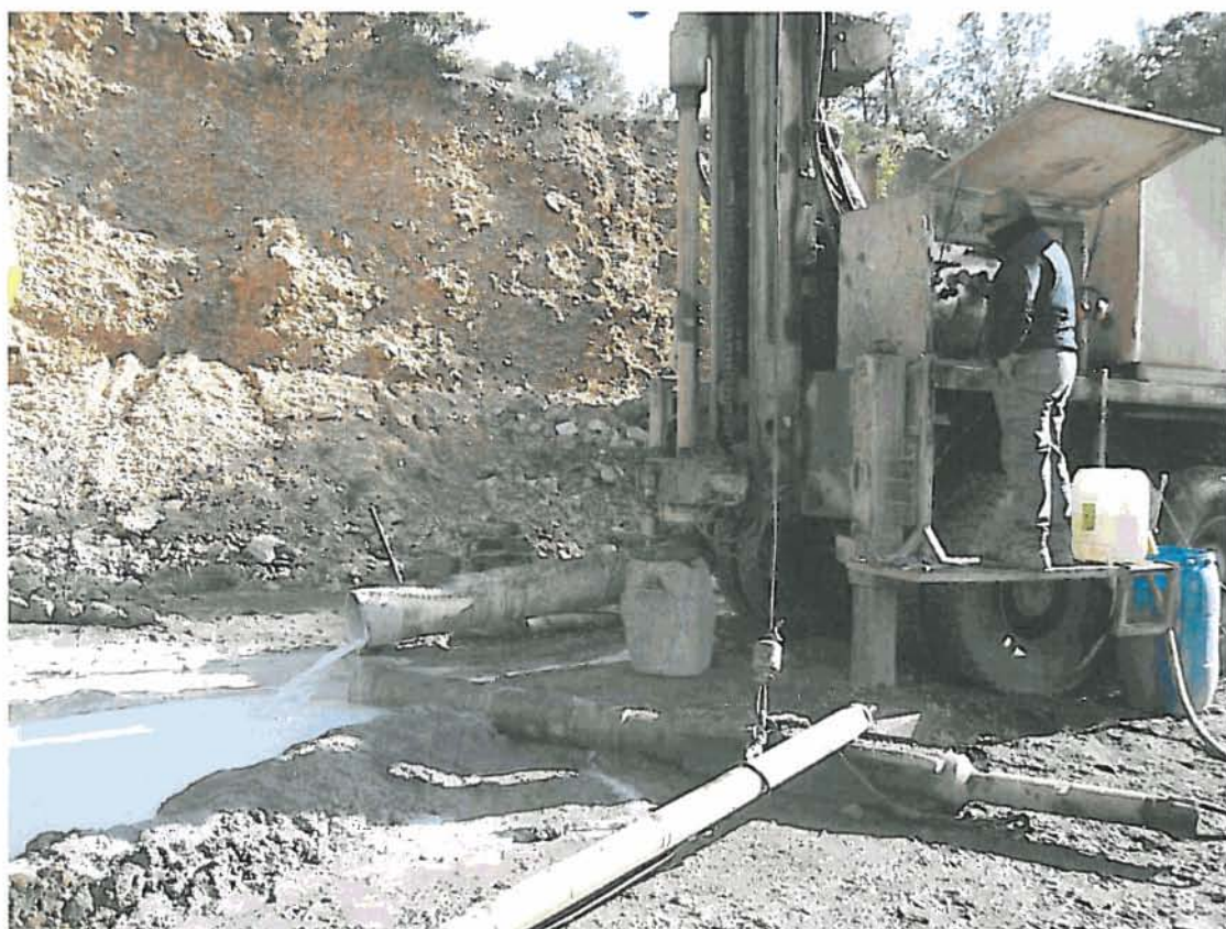
Perforación en 157 metros.
