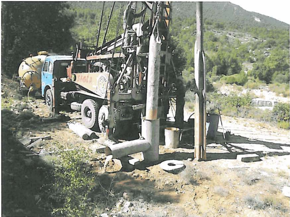
Perforación primer metro del emboquille.
