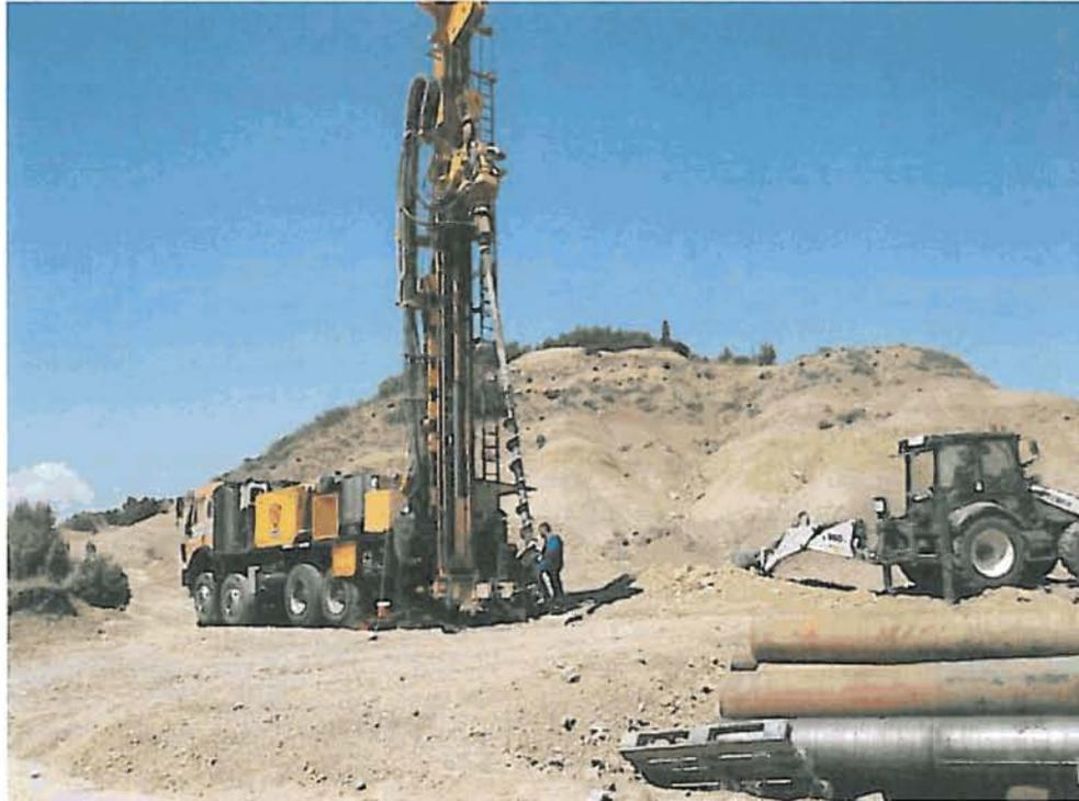
Emplazamiento de la máquina y pala mixta excavando la balsa.
