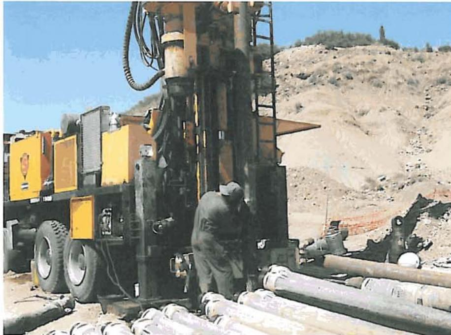
Soldadura de tramo ciego por encima del tramo filtrante.
