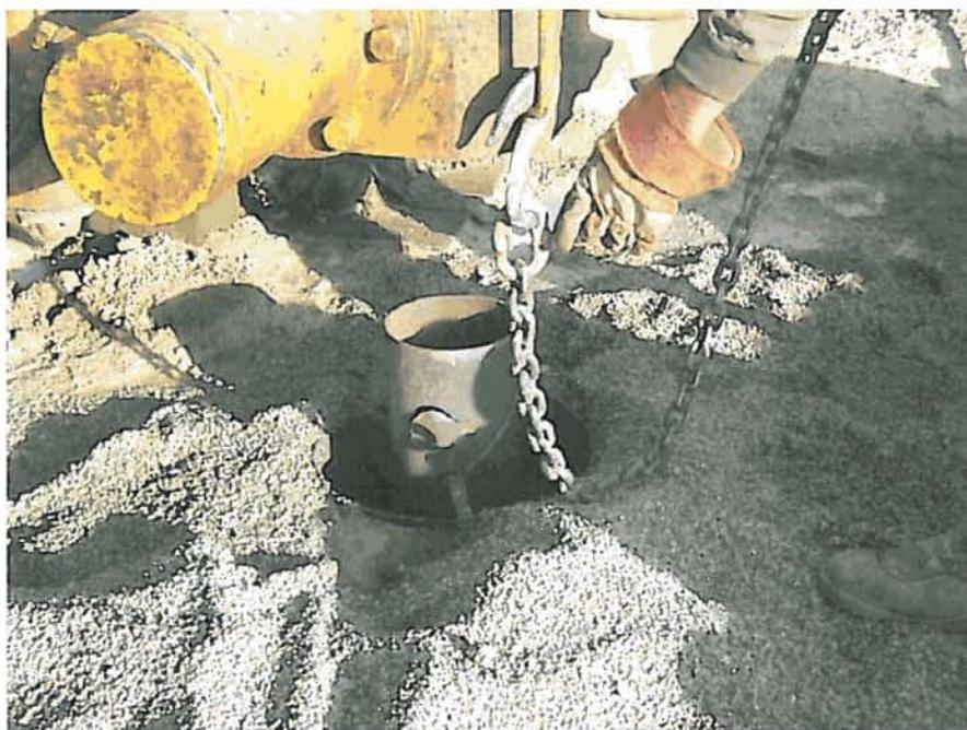
Detalle del solape realizado para colgar la tubería de 180 mm.
