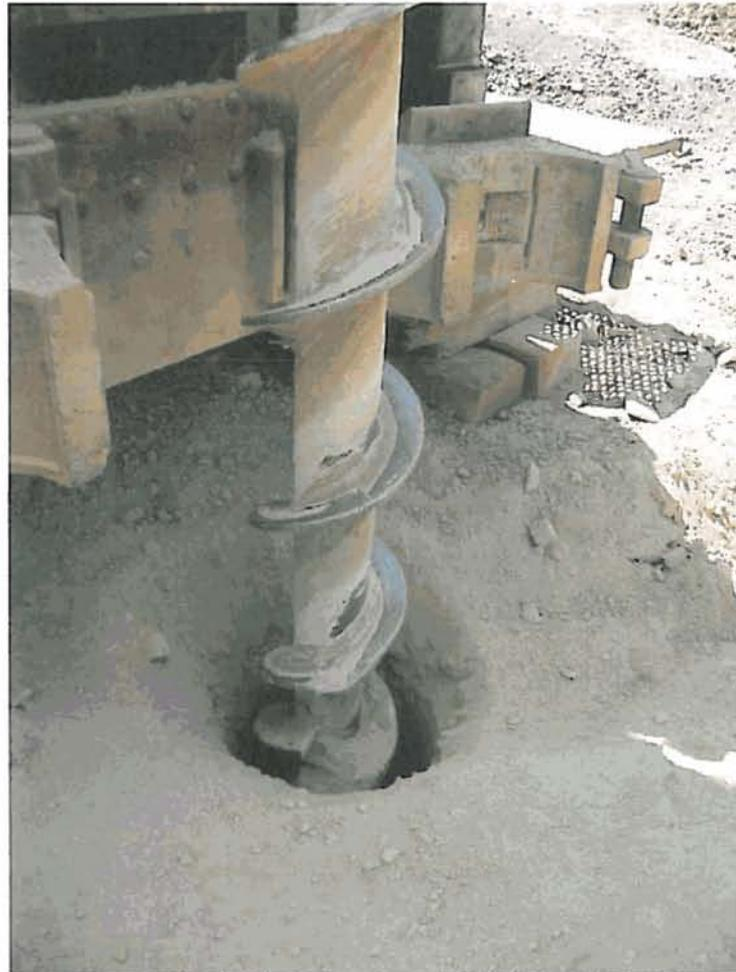
Detalle de taladro perforado por la sonda helicoidal.
