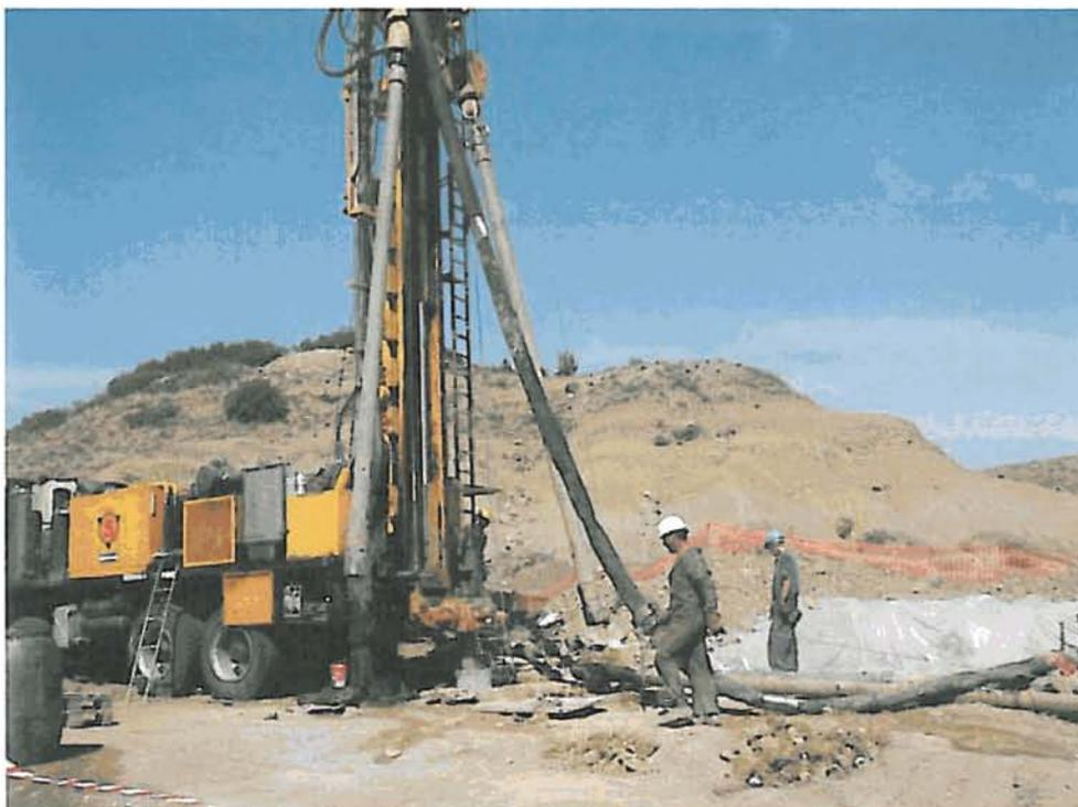
Colocación de varillaje y recogida de muestra durante la perforación
