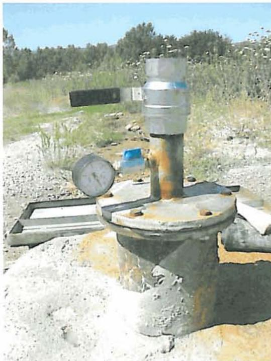
Detalle de la llave y del manómetro. El manómetro marca 1 bar.
