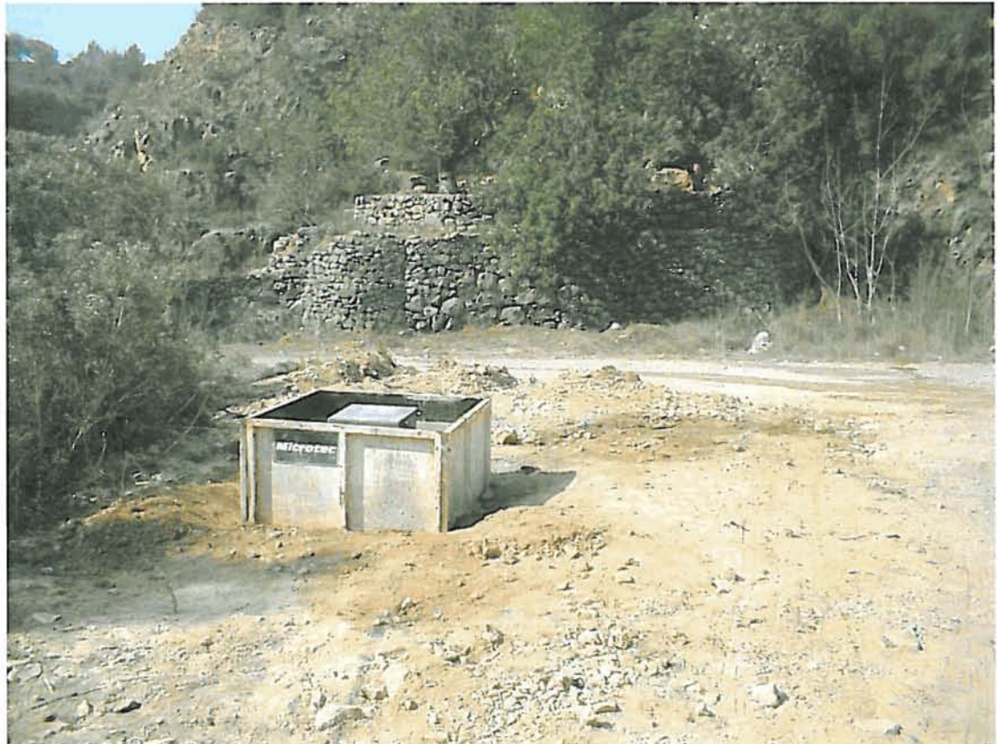
Arqueta hormigonada en el borde del camino y en la margen derecha del barranco.
