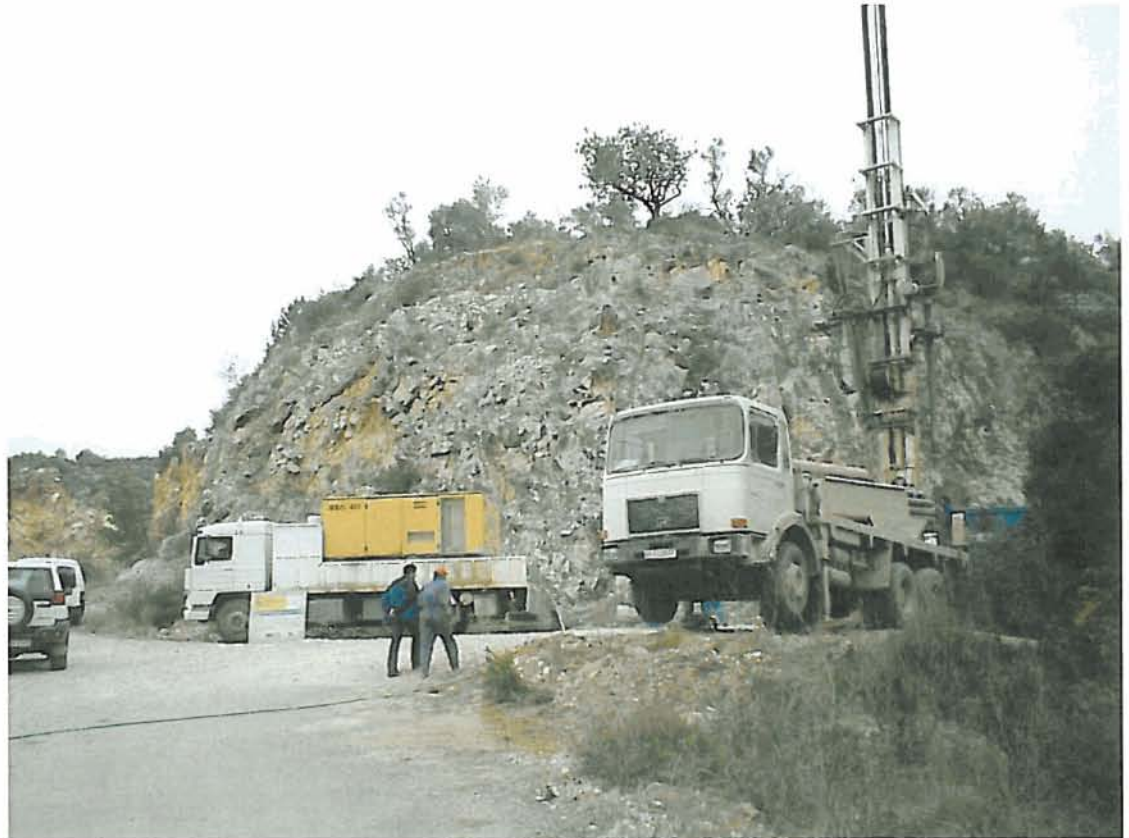
Detalle del emplazamiento en el margen del barranco de la Llet.
