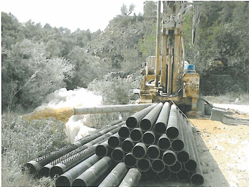
Detalle de la perforación de los últimos metros y de la colocación del último tramo de tubería filtrante.
