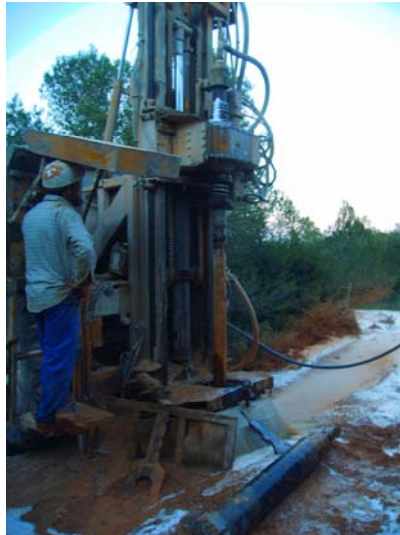
Perforando en 220 mm. Aporte de agua a los 168 m.
