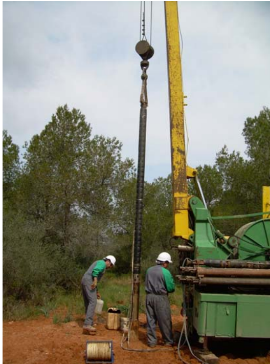
Introduciendo la bomba de aspiración
