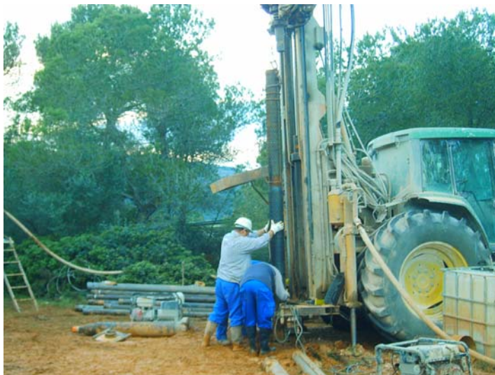
Maniobras de entubación en 180 mm
