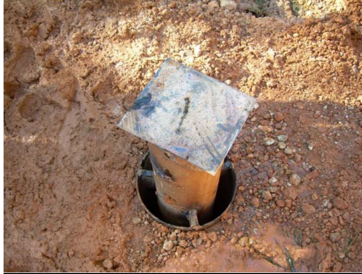
Chapa metálica cerrando el sondeo
