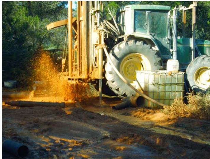
Limpieza durante la entubación
