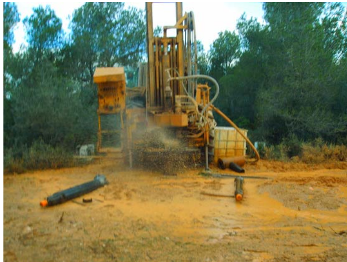
Limpieza del sondeo (10:15h)
