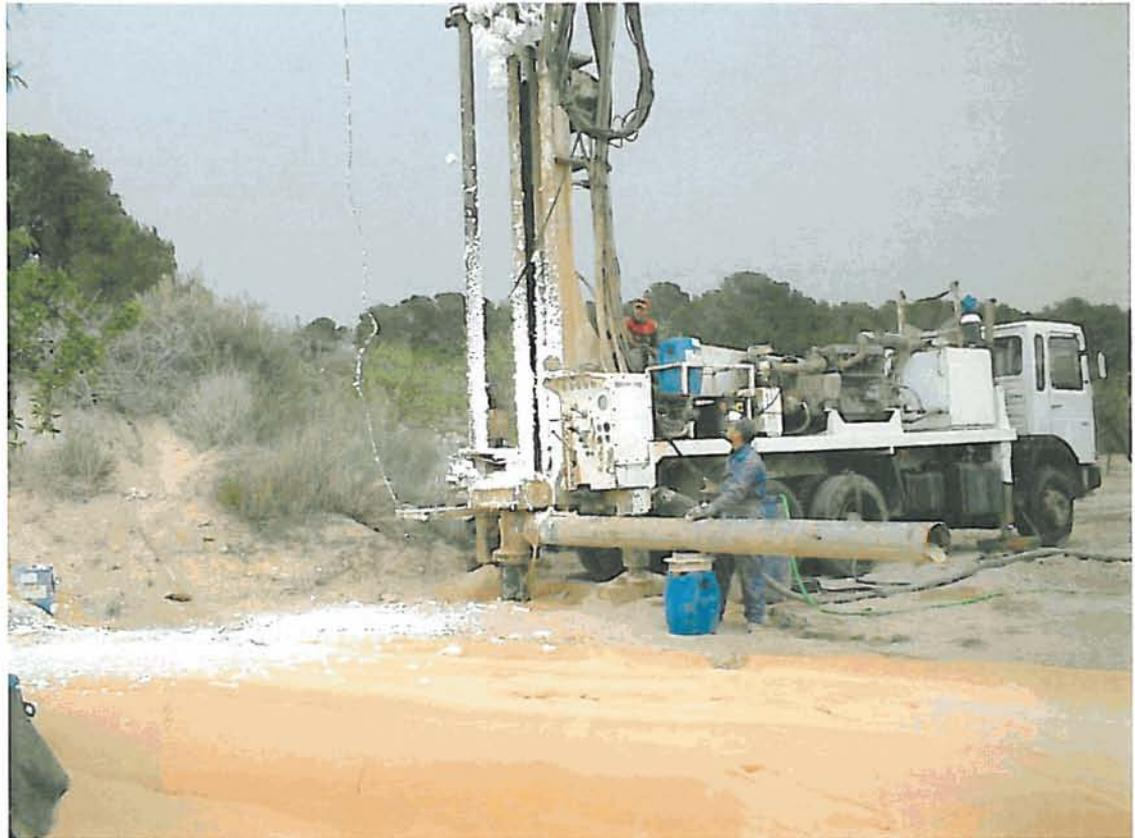
Perforación con 220 mm. Véase la gran cantidad de espumante utilizado.
