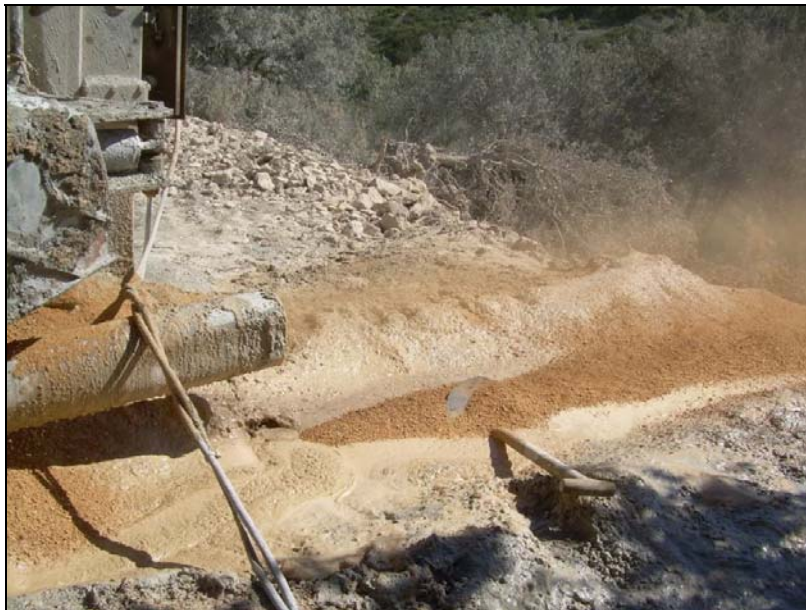
Imagen 9. Detalle de la salida del detritus.
