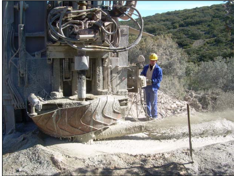
Imagen 8. Perforación del sondeo.
