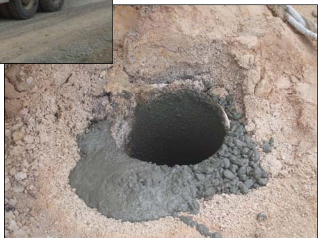
Imágenes 4 y 5. Detalles de la fase de hormigonado del sondeo (hormigonera y boca del sondeo tras su realización).
