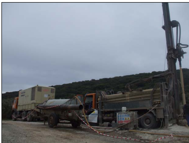
Imagen 2. Emplazamiento del sondeo, una vez acondicionada la parcela.
