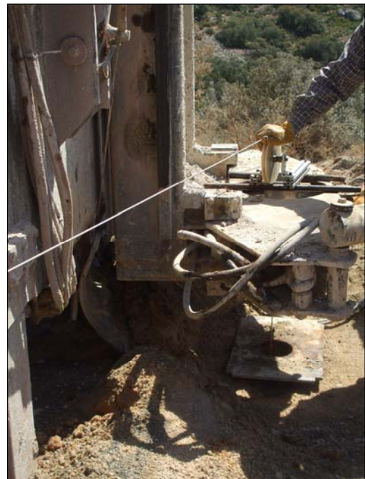
Imágenes 12 y 13. Realización de la testificación geofísica.
