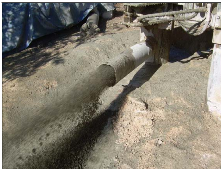
Imagen 7. Salida del hormigón por la pipa.
