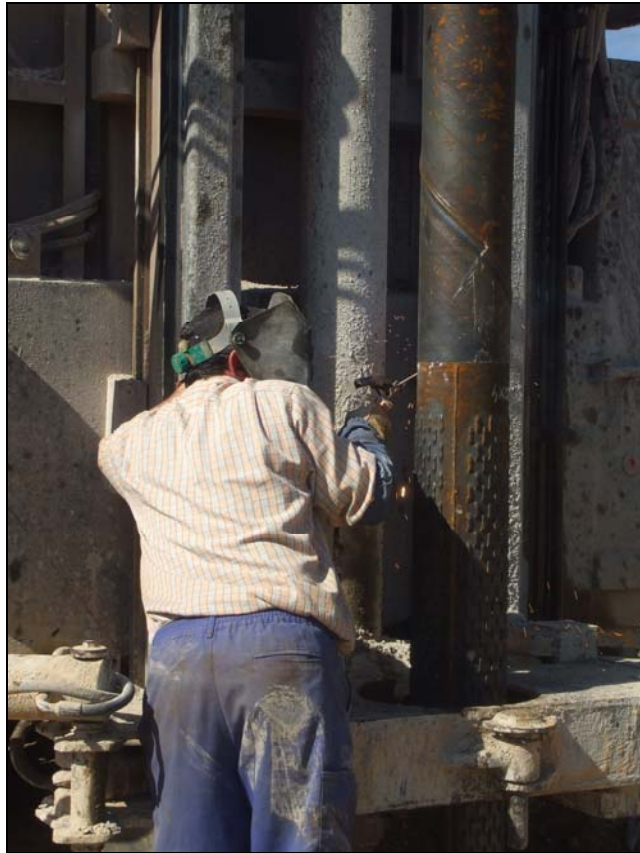
Imagen 14. Soldadura de las tuberías durante la entubación.
