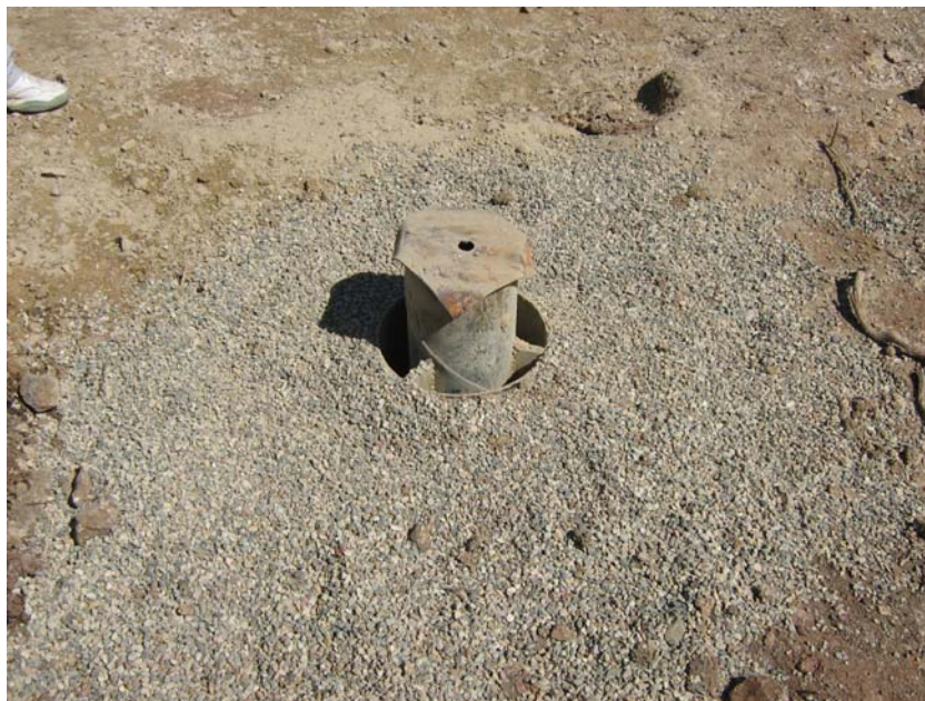
Sondeo tapado provisionalmente con chapa metálica
