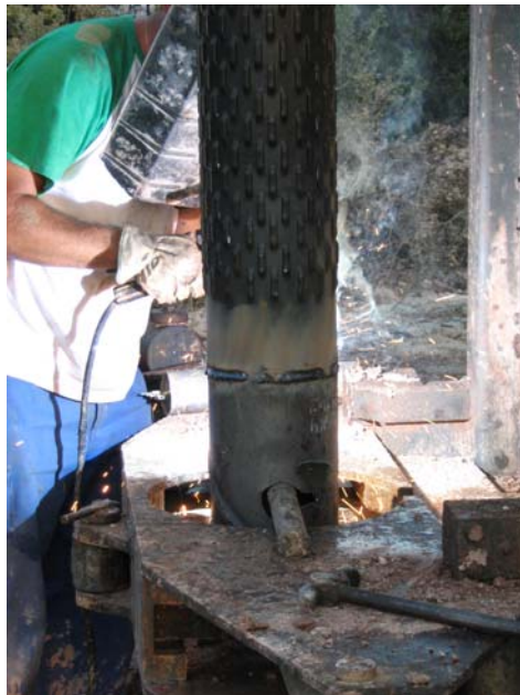
Soldando dos tramos de tubería
