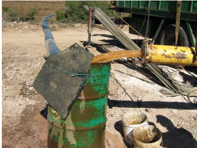
Primer escalón, 11 l/s, al fondo se ve la manguera flexible dirigiendo el agua a la parcela aledaña
