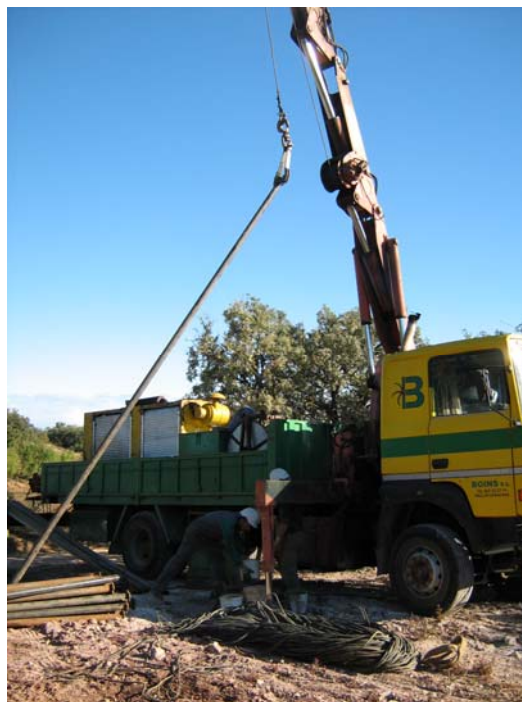
Elevando un tramo de tubería para ser introducida
