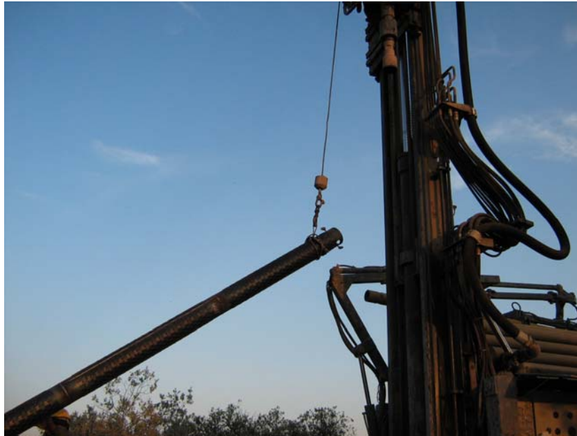
Elevando un tramo de 6 m de tubería de filtro
