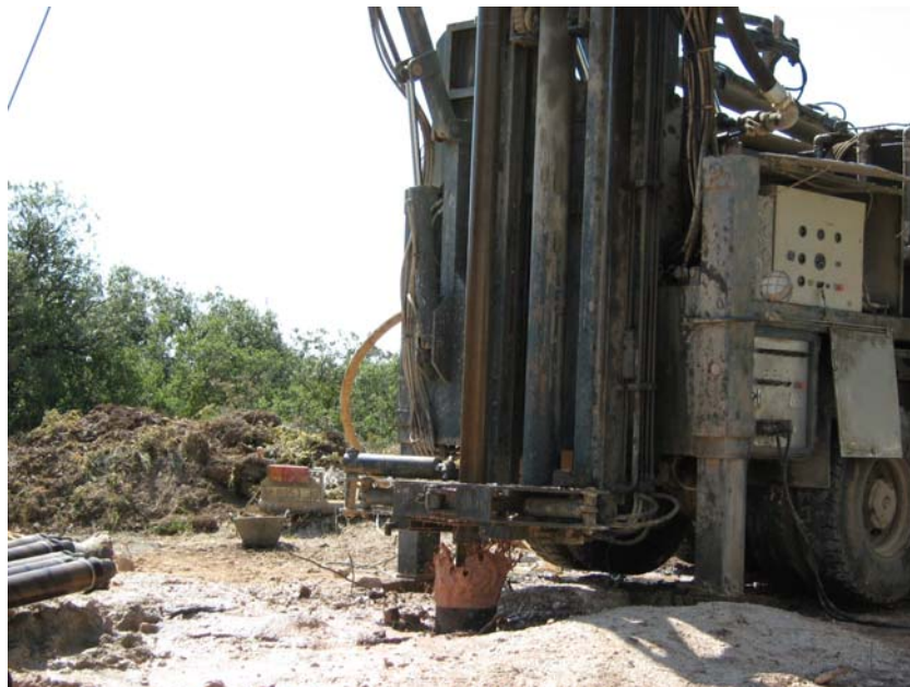
Limpiando la zona superior arcillosa (30-40 m)
