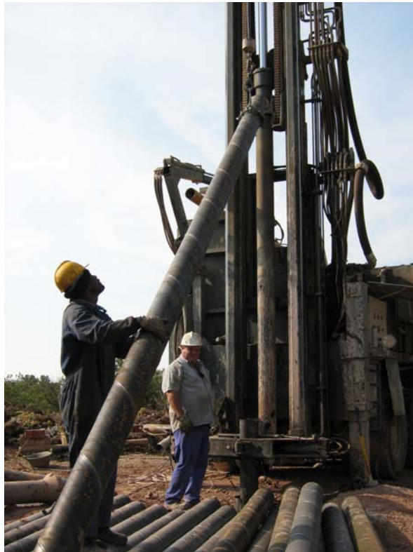
Elevando un tramo de 6 m de tubería ciega
