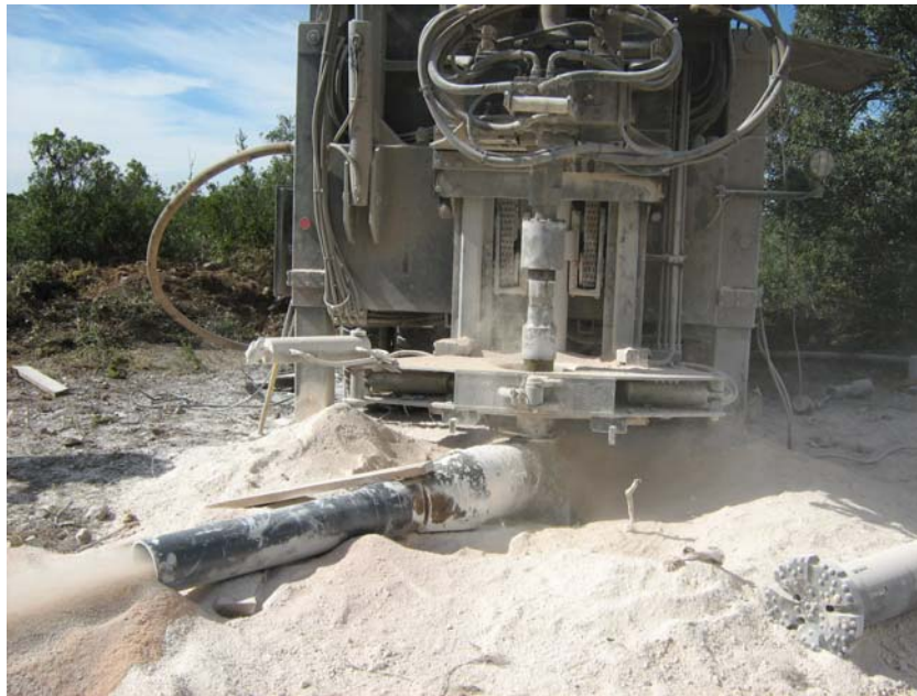
Perforando a unos 15 m de profundidad (aún en seco)
