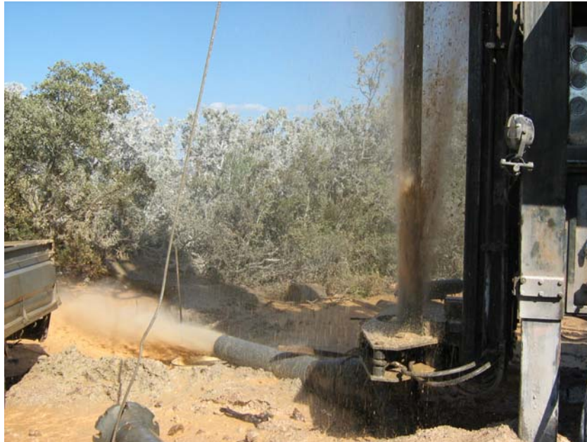
Perforando a 223 m de profundidad (caudal muy abundante, entorno a los 20 l/s)
