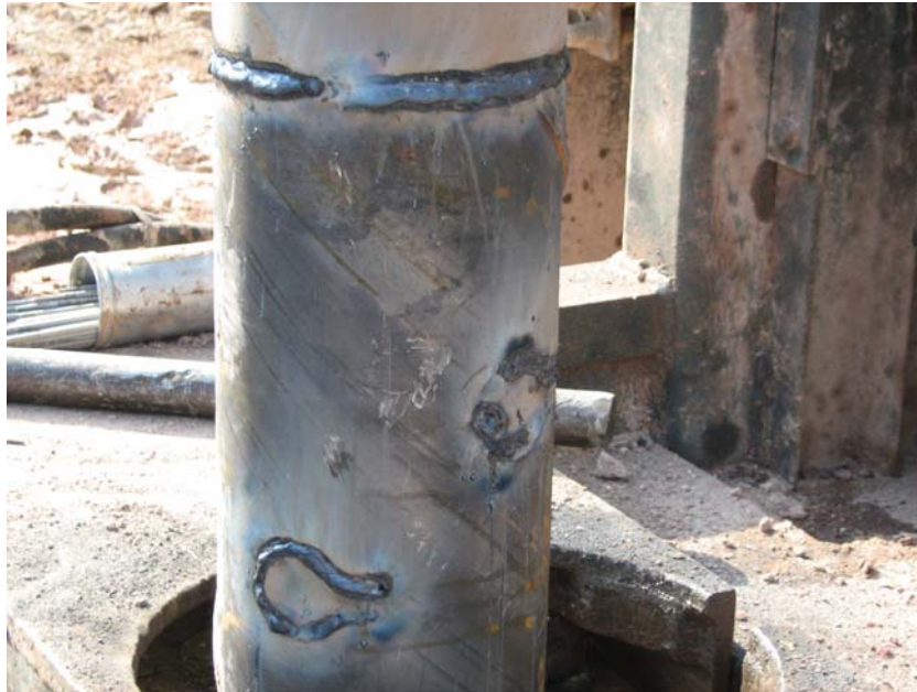
Detalle: soldadura entre tuberías y cerrando orejetas
