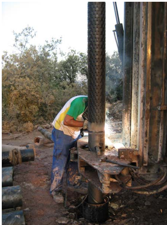
Soldando dos tramos de tubería
