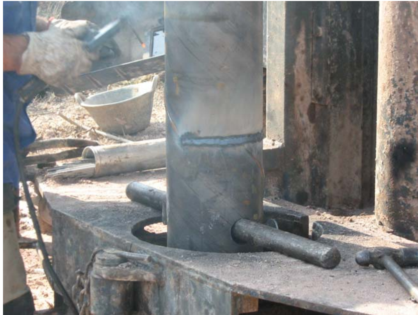
Soldadura entre tuberías ciegas
