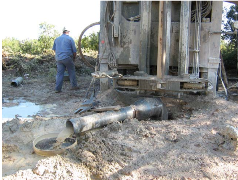
Perforando a unos 150 m de profundidad (caudal estimado entorno a los 10 l/s)
