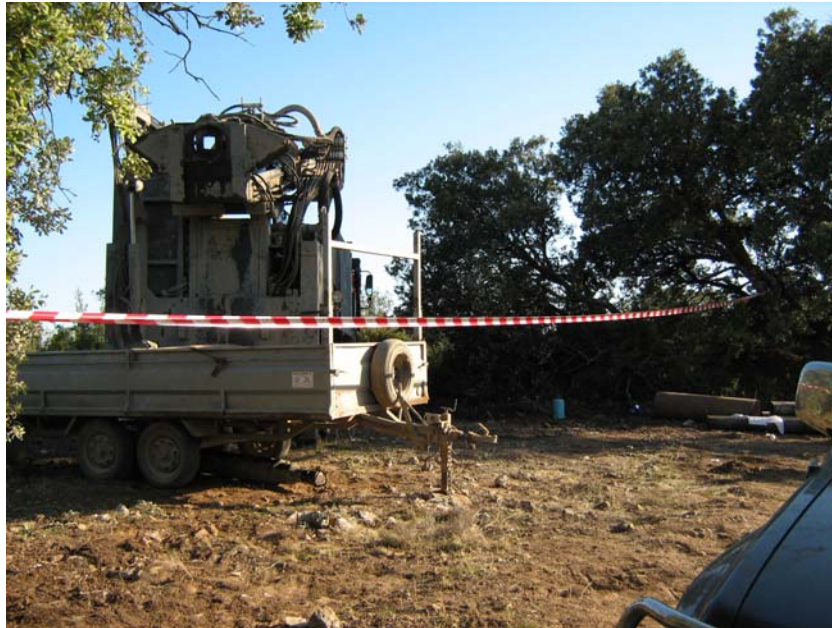
Emplazamiento tras ser limpiado con maquina excavadora
