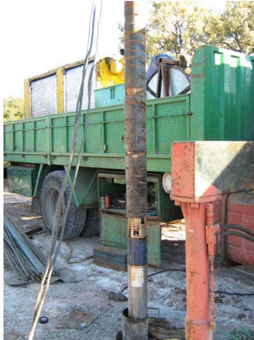
Introduciendo la bomba
