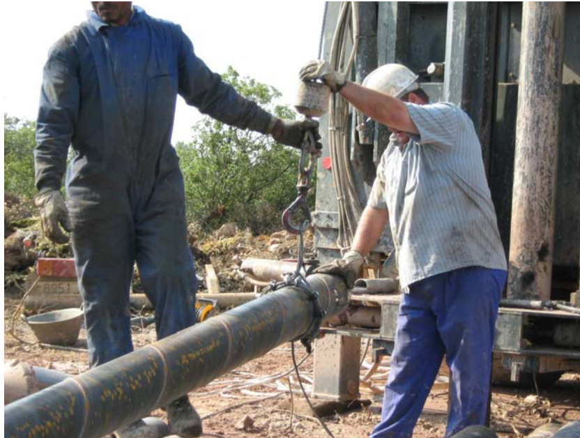
Cablestante elevando un tramo de tubería ciega
