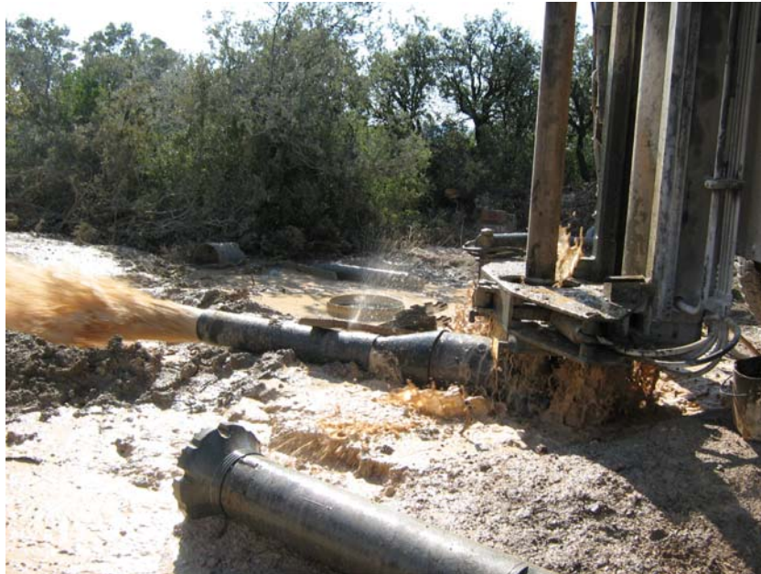
Perforando a 200 m de profundidad (caudal muy abundante)
