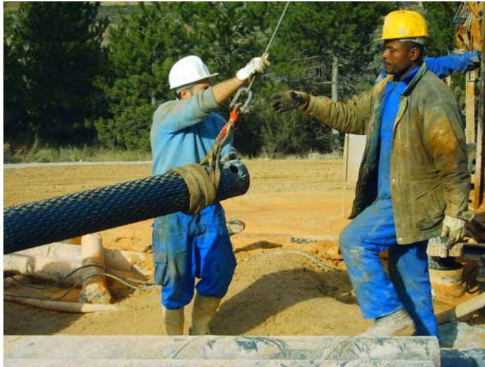
Elevando la tubería
