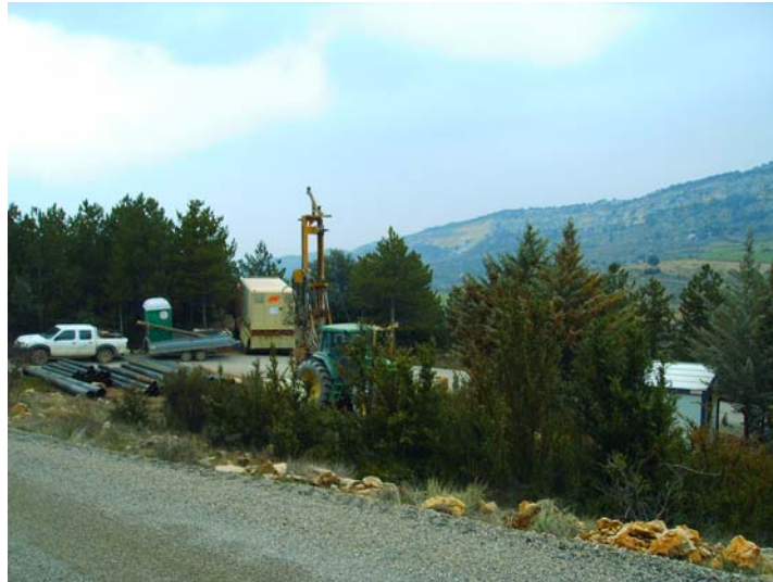
Maquinaria en el emplazamiento de Sant Esteve de la Sarga
