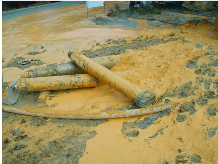
martillo sustituido de 220 mm
