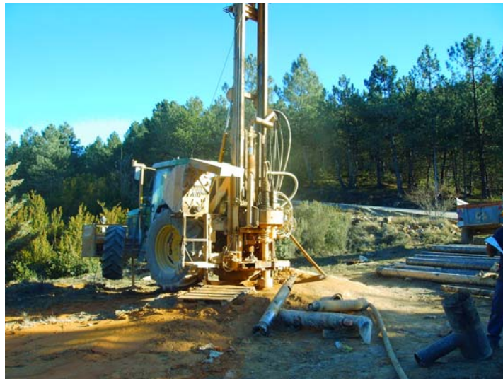
Limpieza (aire, algo de sedimento y algunas gotas llegan a superficie)
