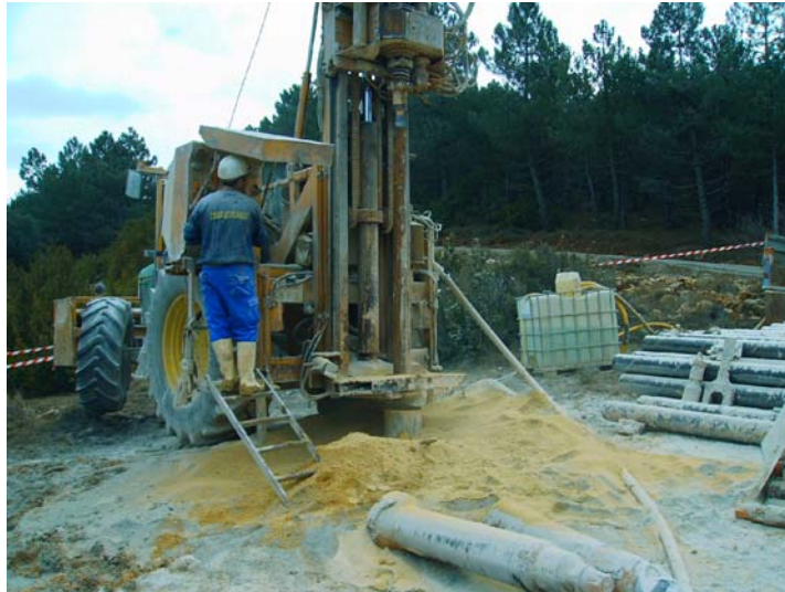
Perforando con el martillo de 220 mm (arenas finas amarillas, prof: 50 m)
