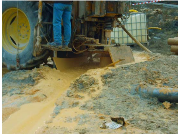
Perforando a 224 m de profundidad
