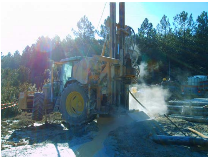
Perforando con el martillo de 220 mm en las areniscas de la formación Areny (prof: 136 m)
