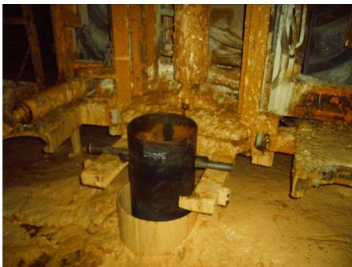
Introduciendo la tubería de emboquille
