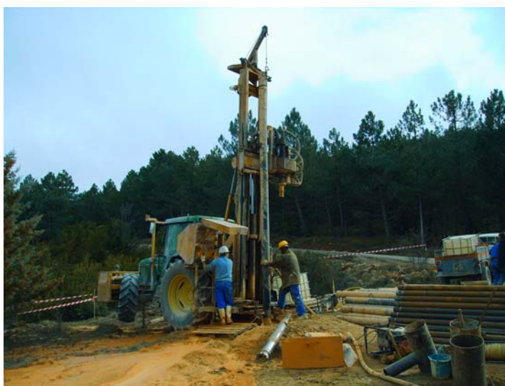
Colocando un tramo de tubería ciega de 6 m
