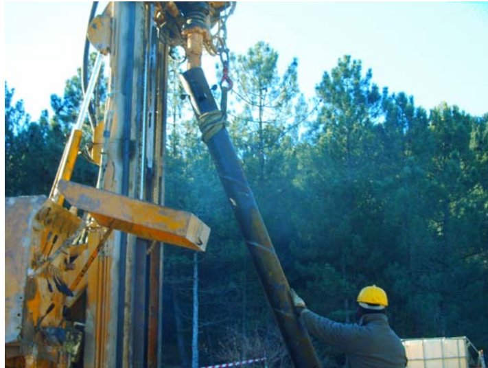
Elevando un tramo de tubería ciega
