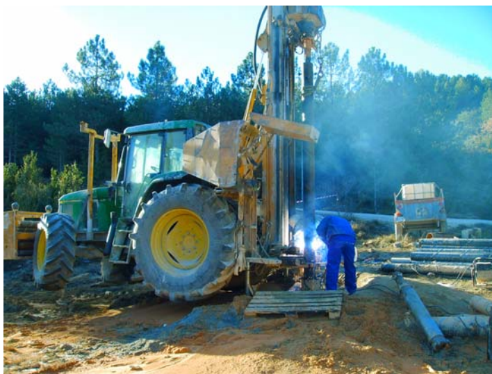
Soldando un tramo de tubería ciega
