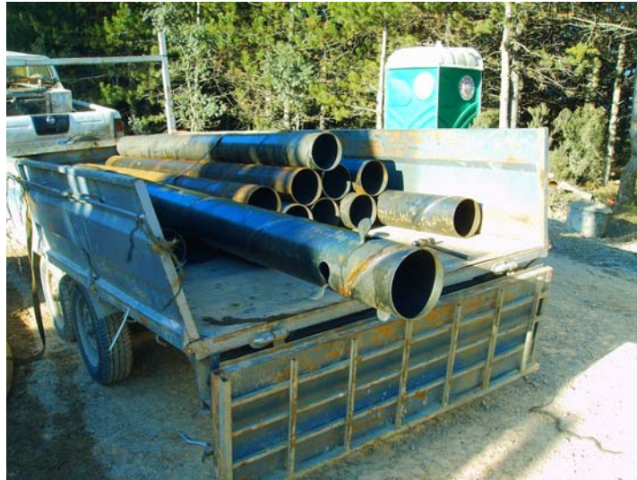
Tuberías ciegas en tramos de 3 m, soldadas en hélice
