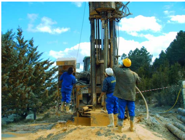
Extrayendo maniobra para sustituir el martillo
