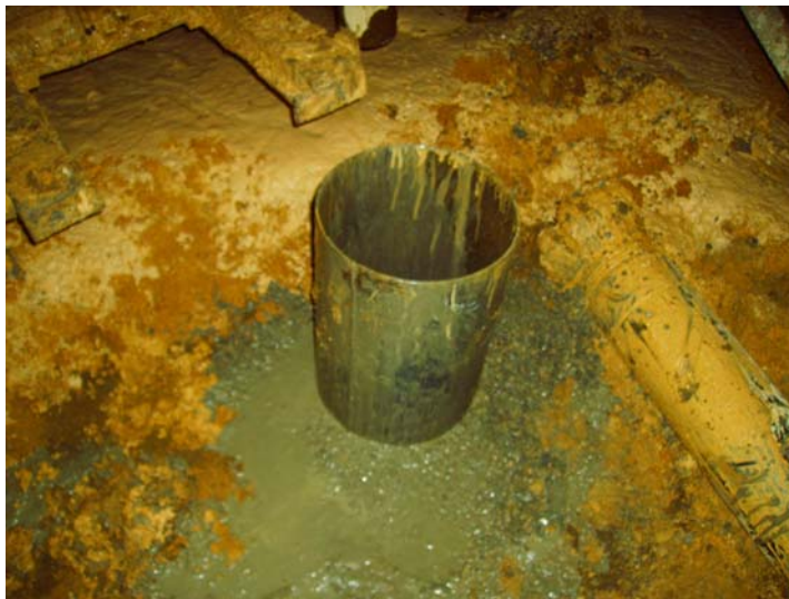
Tubería de "emboquille" una vez cementados los 12 m
