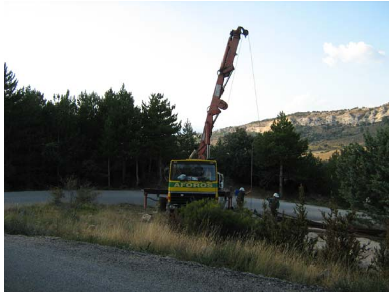
Vista del emplazamiento
