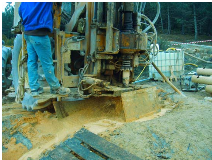
Perforando a 237 m de profundidad
