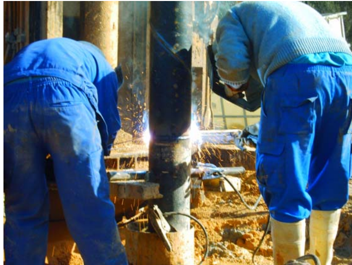
Soldando dos tuberías ciegas
