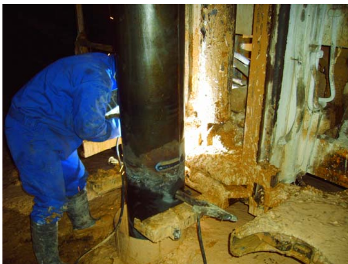
Soldando las tuberías de 300 mm de diámetro
