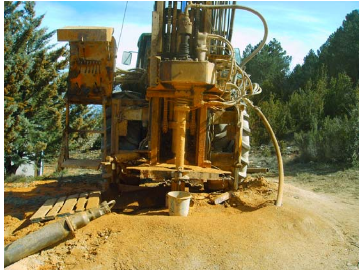
Limpieza (no llega a aflorar el agua)
