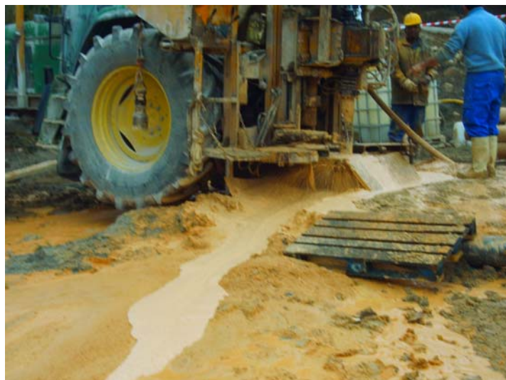
Perforando a 278 m de profundidad en la Fm Areny
