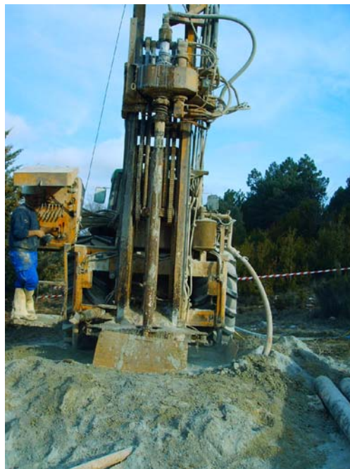
Perforando con el martillo de 220 mm (arenas finas grises, prof: 85 m)
