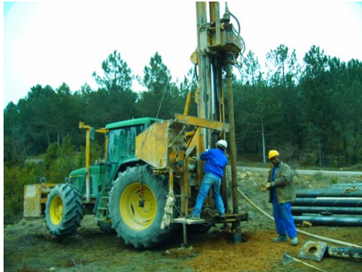
Comienzo de la perforación con el martillo de 324 mm de diámetro
