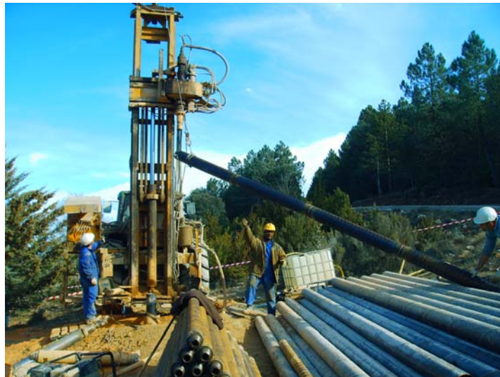
Elevando un tramo de tubería de filtro
