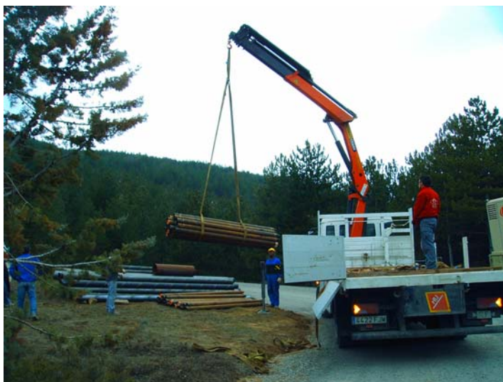
Descargando el varillaje
