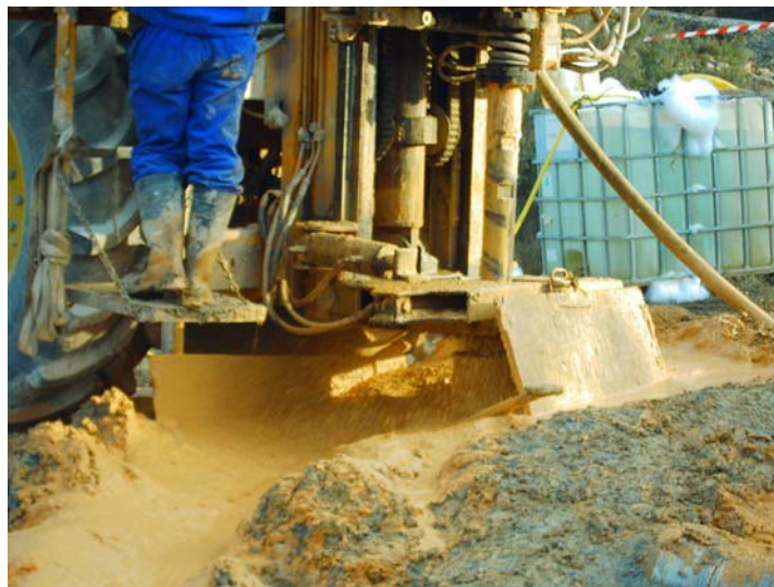
Perforando a 190 m de profundidad
