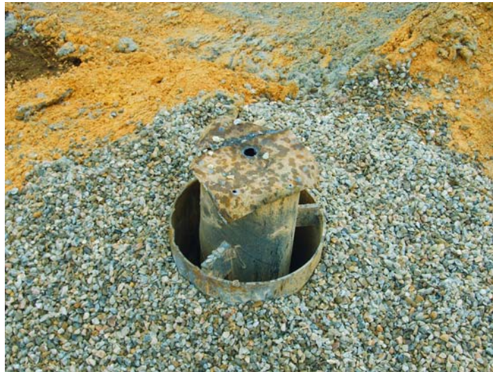
Detalle: agujero para introducir la sonda manual
