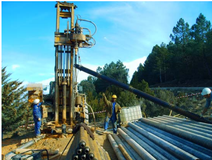
Elevando un tramo de 6 m de tubería filtrante
