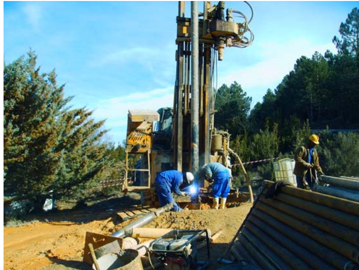
Soldando un tramo de tubería ciega
