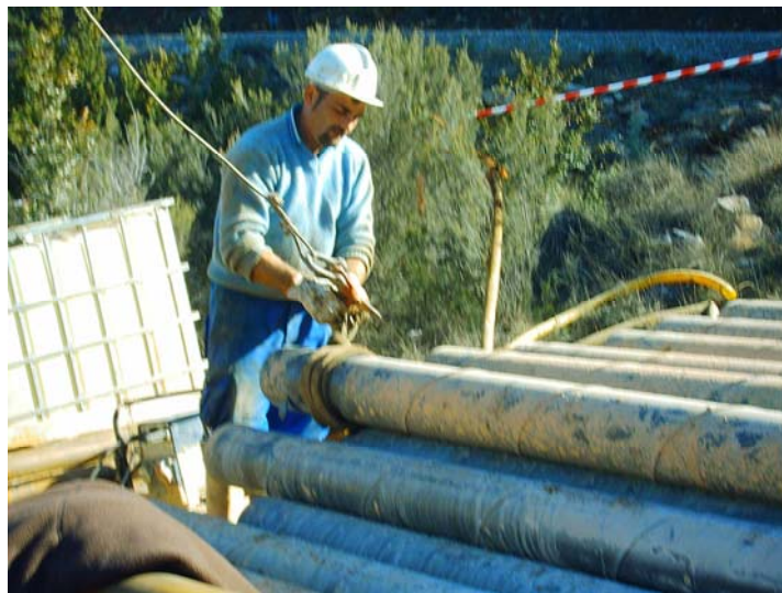
Enganchando la tubería para ser elevada
