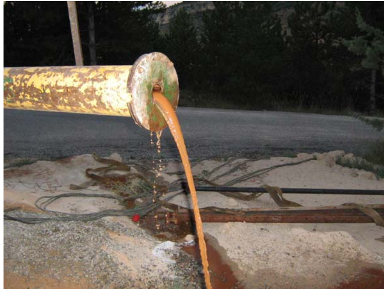
Primer bombeo a 0,3 l/s
