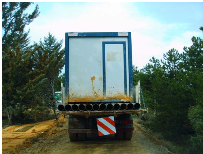
Caseta y tuberías preparadas en el camión para el traslado a Massoterets
