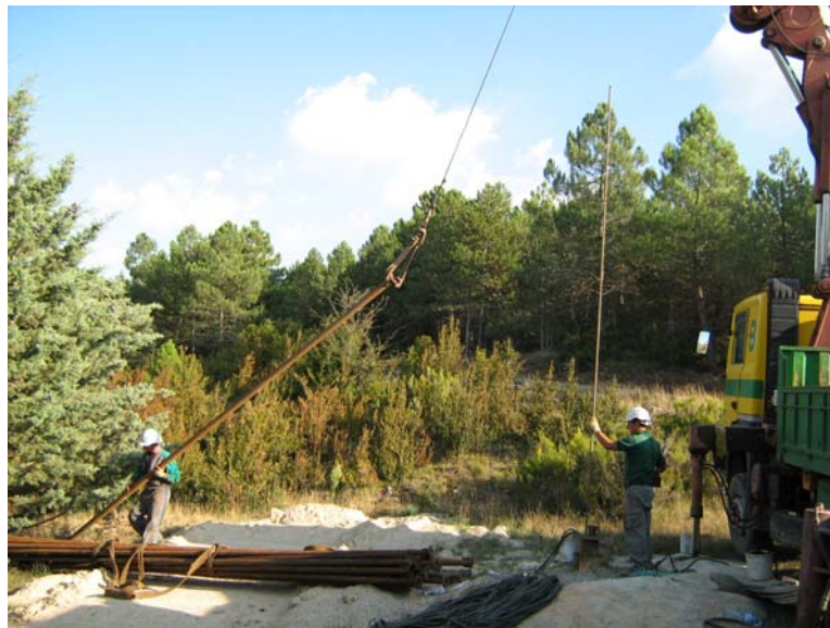
Elevando un tramo de tubería para ser introducida
