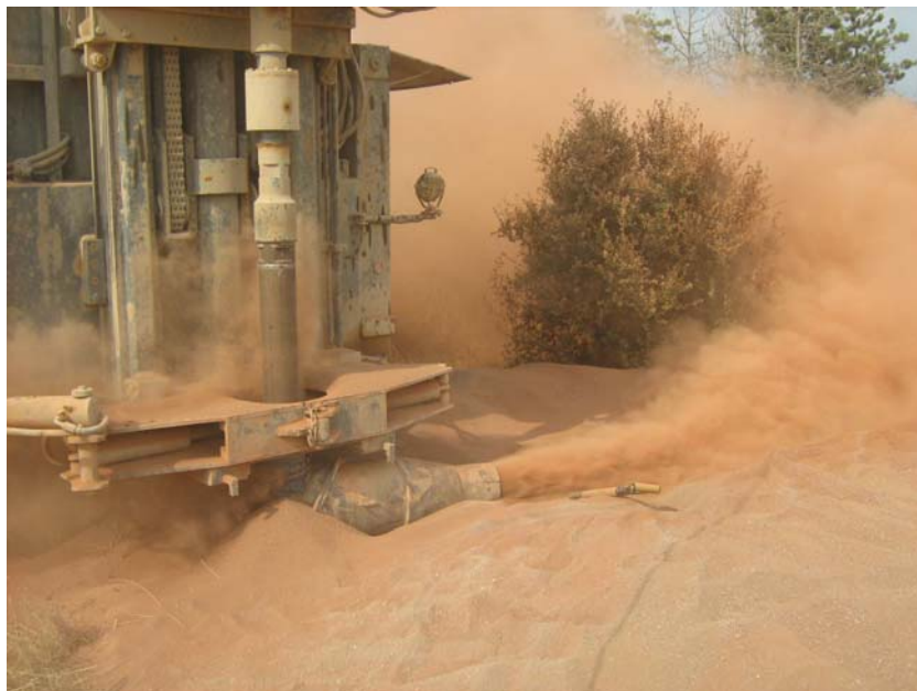
Perforando a 85 m de profundidad (arcillas marrones)
