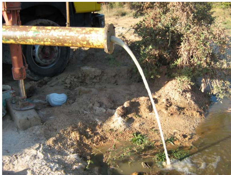
Agua turbia blanquecina al comenzar el aforo (primer escalón 1 l/s)
