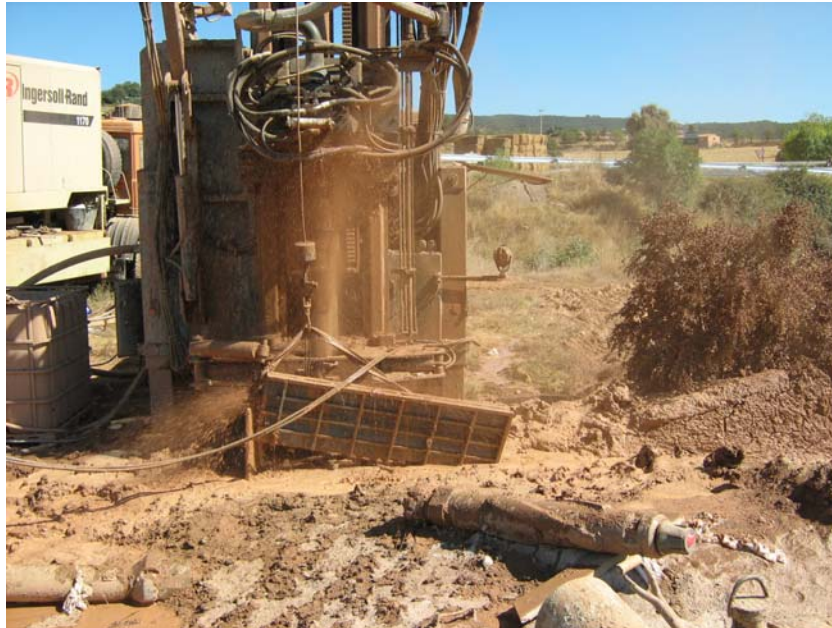
Limpiando con el martillo de 165 mm
