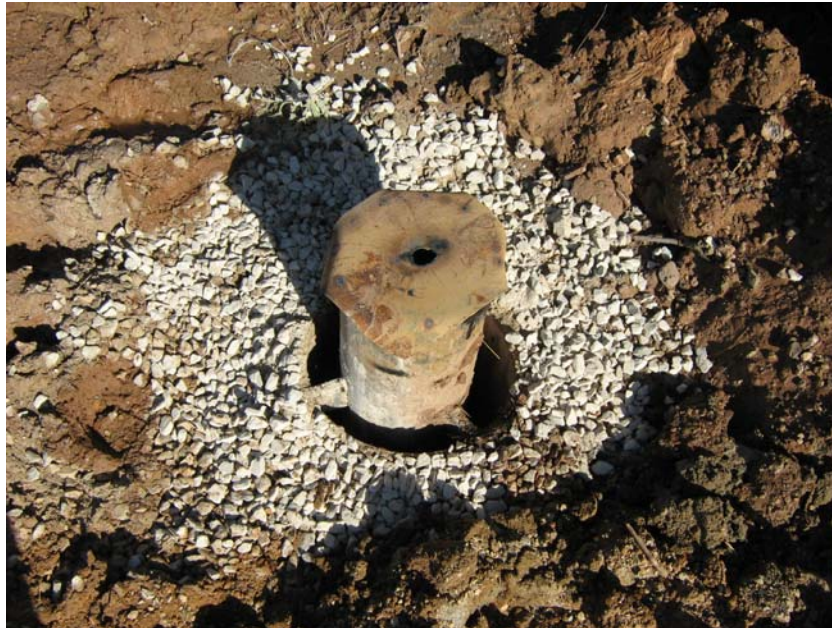
Sondeo tapado con chapa metálica provisionalmente
