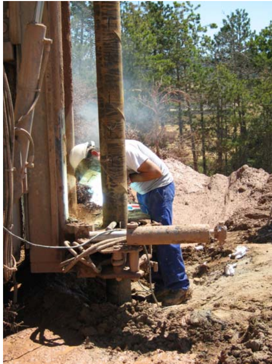
Soldando dos tramos de tubería
