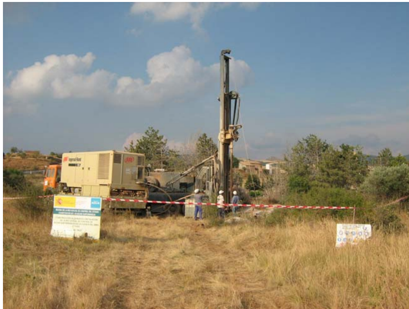
Emplazamiento en Tolva una vez comenzada la perforación
