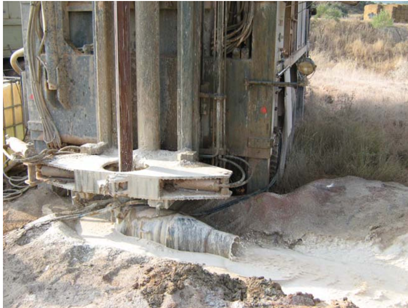
Perforando a 195 m de profundidad (inyectando agua al sondeo)
