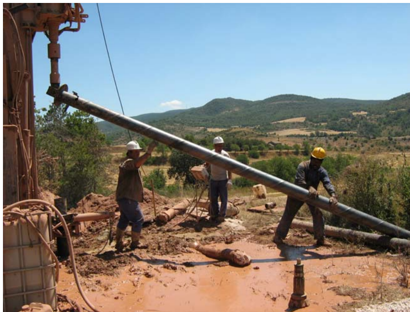
Elevando un tramo de tubería ciega de 6 m
