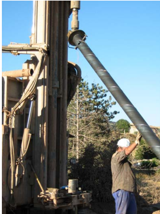
Elevando un tramo de tubería ciega
