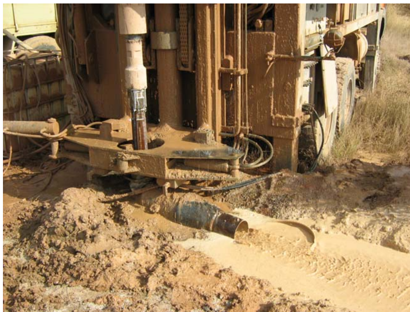
Perforando a 222 m de profundidad
