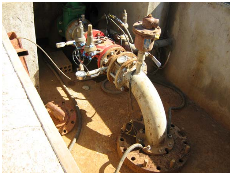
Equipo montado en el sondeo de abastecimiento a la localidad de Tolva
