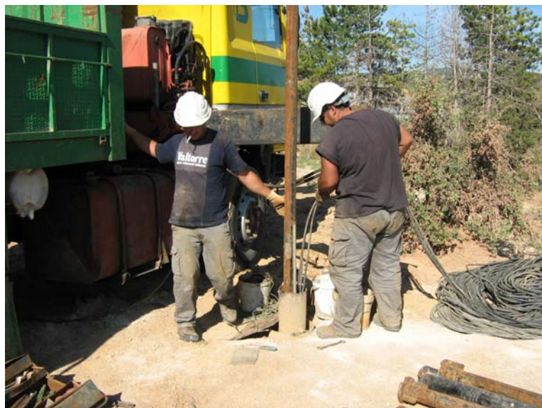
Introduciendo tuberías y cableado
