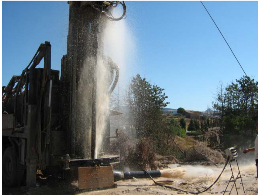
Caudal muy abundante a los 320 m de profundidad (unos 6-7 l/S)
