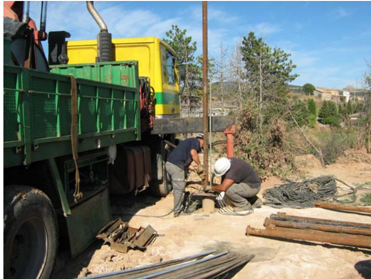
Uniendo tuberías con el taladro
