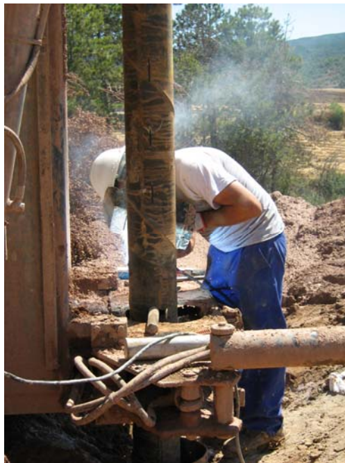
Soldando dos tramos de tubería
