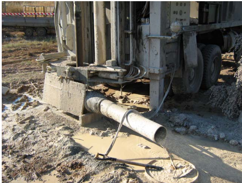
Perforando a 290 m de profundidad
