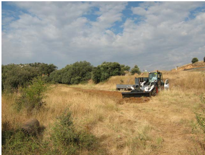
Máquina adecuando y limpiando el emplazamiento
