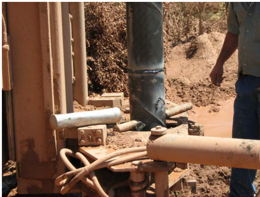
Detalle soldadura entre tuberías y cerrando orejetas
