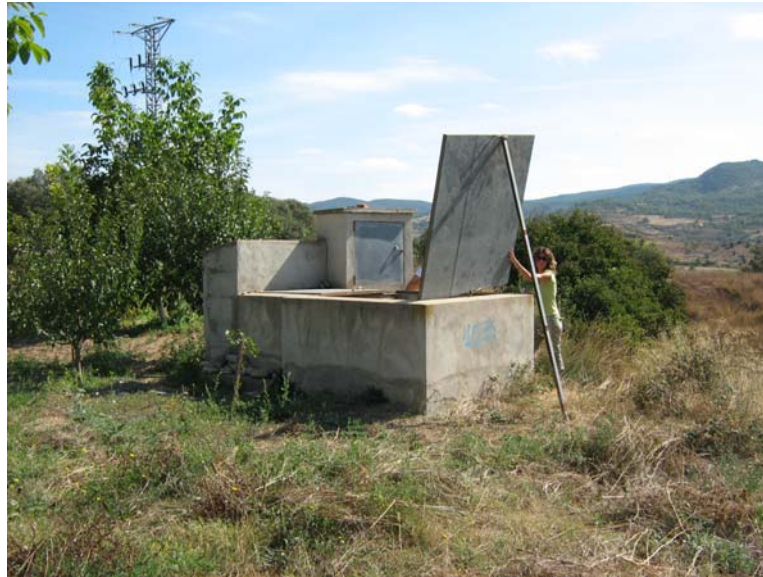
Sondeo abastecimiento Tolva
