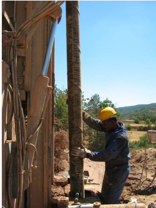
Colocando un tramo de tubería ciega ranurada para ser soldado al tramo anterior
