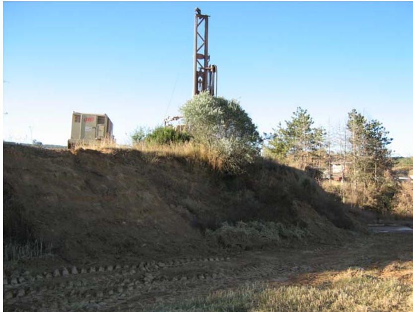
Talud que separa el emplazamiento de la parcela colindante (tras limpieza)
