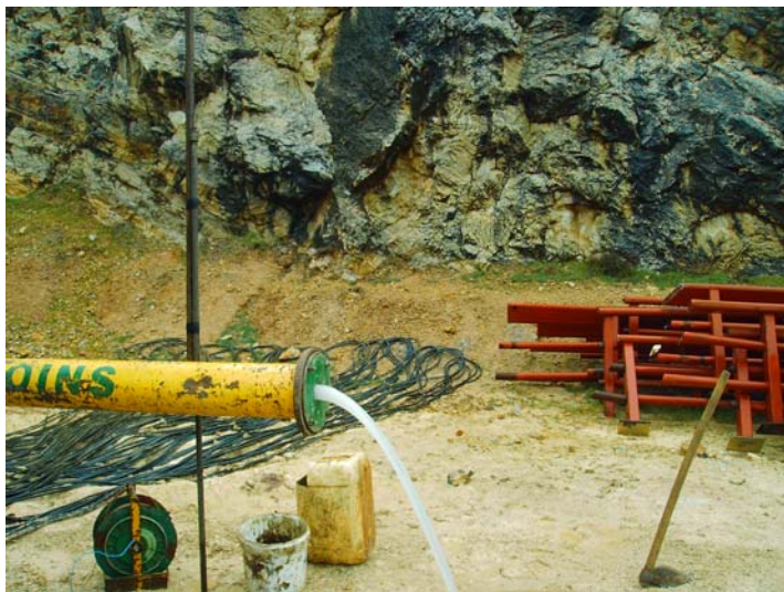
Segundo escalón, 2 l/s, (agua de color blanquecino)
