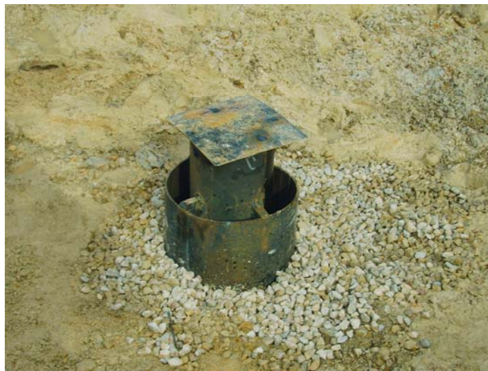
Final de la entubación, unión de la tubería de 180 mm a la de 300 mm y tapado con chapa metálica.
