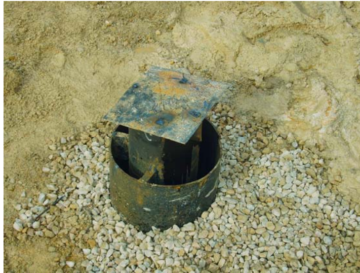
Chapa metálica cerrando provisionalmente el sondeo
