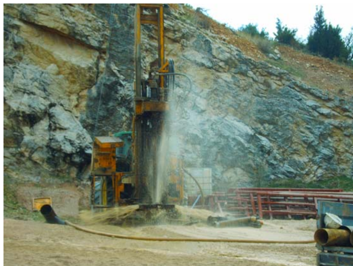
Limpieza del sondeo
