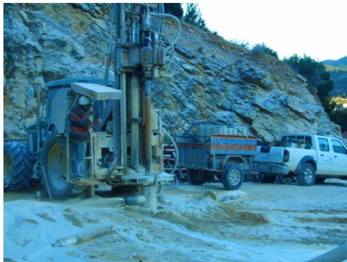
Perforando con el martillo de 220 mm de diámetro
