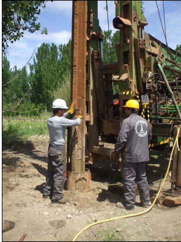
Imagen 3. Perforación del emboquille.
