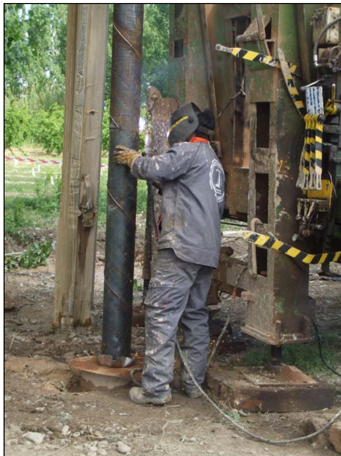
Imagen 5. Trabajos de soldadura durante la entubación.
