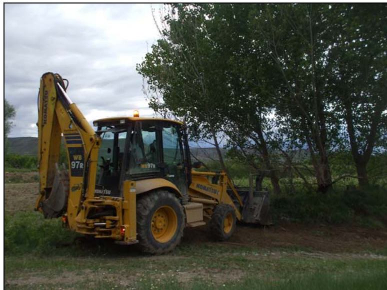
Imagen 1. Adecuación del emplazamiento del sondeo de Velilla de Cinca (Huesca).
