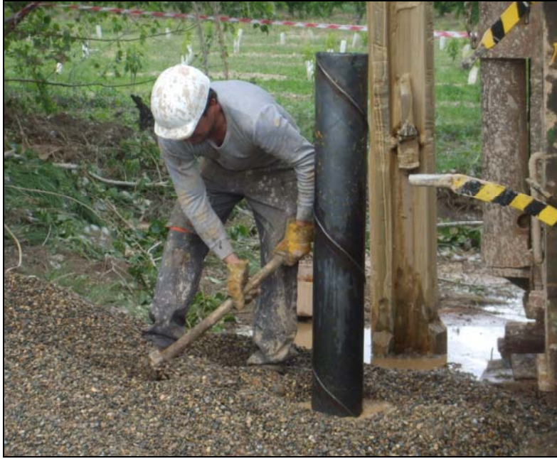
Imagen 6. Colocación del empaque de gravas.
