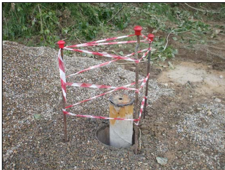
Imagen 9. Aspecto final del cierre provisional del sondeo.
