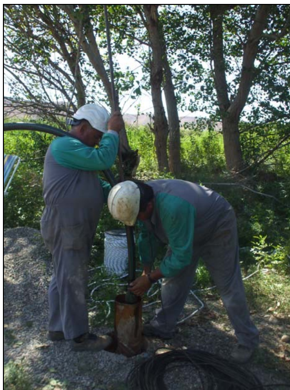
Imagen 2. Instalación del equipo de aforo.
