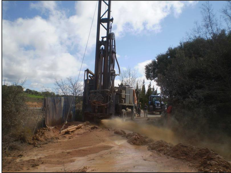
**Imagen 4.** Perforación del sondeo sobre los 160 m.
