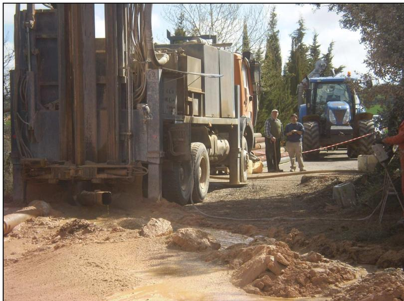
*Imagen 3. Perforación del sondeo a 110 m.*
