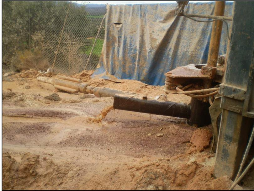
*Imagen 2. Perforación del sondeo con un diámetro de 220 mm.*
