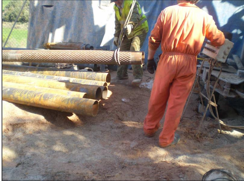
**Imagen 11.** Elevación de tubería filtro puentecillo.
