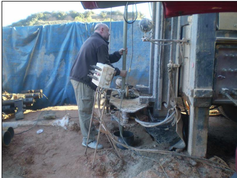
**Imagen 10.** Introducción de sonda geofísica.
