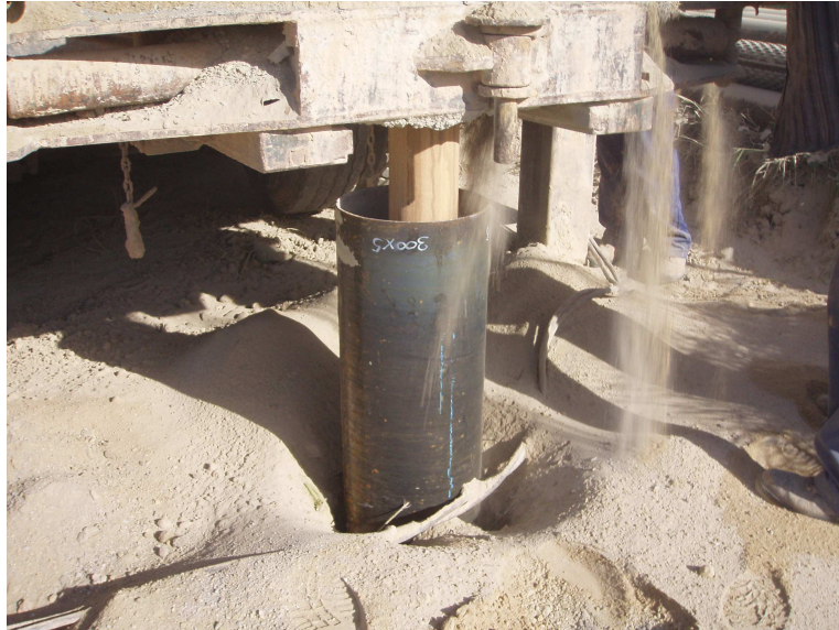
Foto 1. Detalle de la tubería de emboquille en el sondeo de Panillo.
