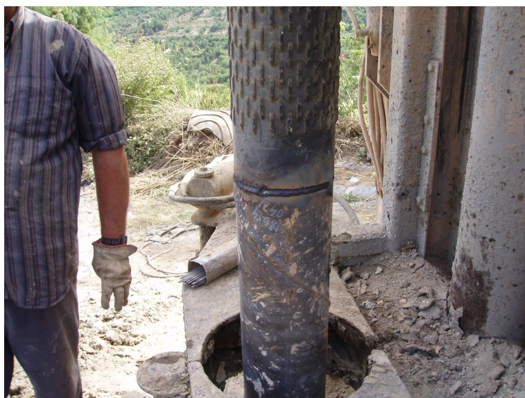
Foto 7. Detalle de tubería ciega y tubería de filtro de puentecillo durante la entubación del sondeo.
