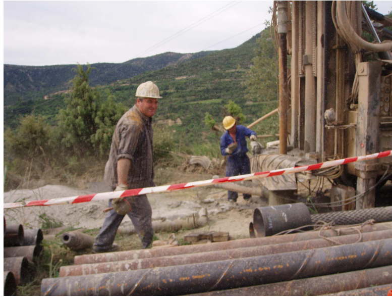
Foto 3. Trabajos de perforación.
