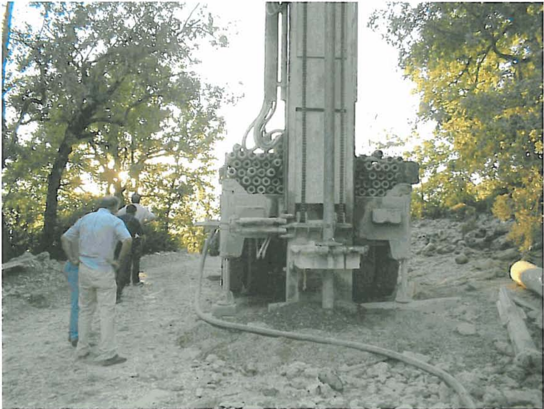
Primeros metros de perforación.
