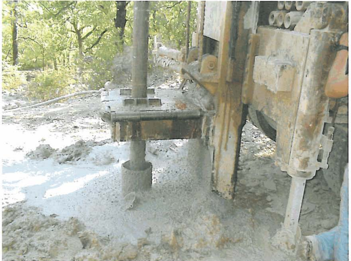
Perforación en los niveles margosos.
