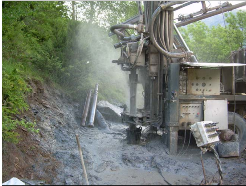
Imagen 9. Realización de limpieza.
