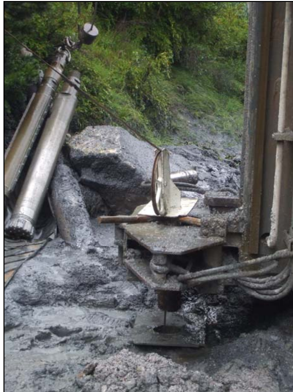
Imagen 7. Realización de testificación geofísica.
