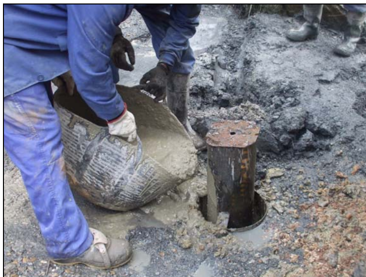
Imagen 10. Cementación del emboquille del sondeo.
