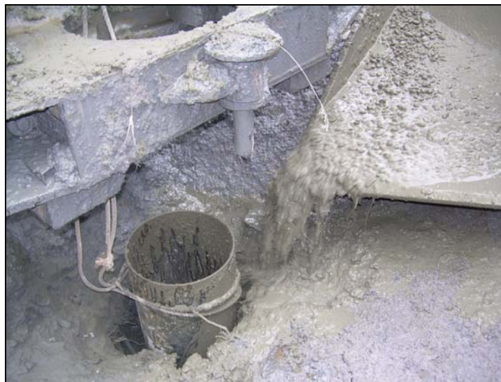
Imagen 3. Vertido de hormigón para el cementado del emboquille.
