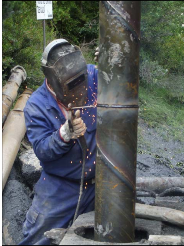
Imagen 8. Trabajos de soldadura durante la entubación.
