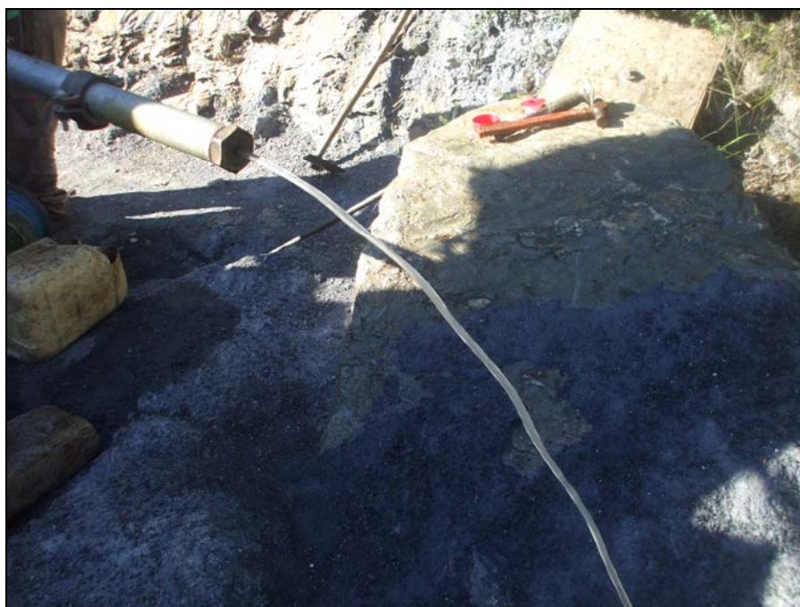
Imagen 2. Caudal extraído al inicio del primer escalón.
