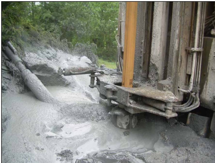
Imagen 4. Perforación del sondeo con un diámetro de 220 mm.
