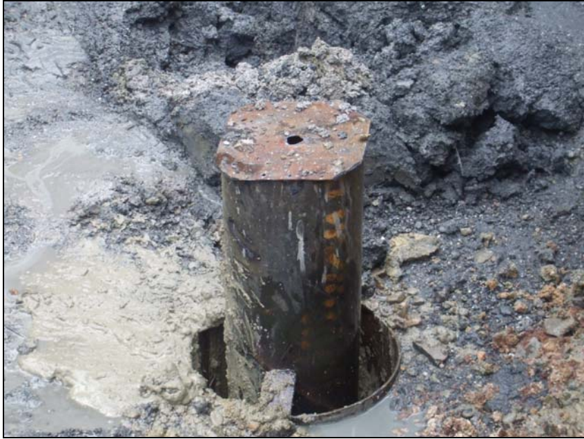
Imagen 11. Aspecto del cierre provisional del sondeo de Sesué.
