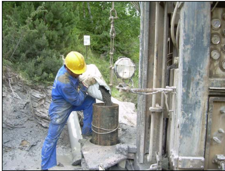
Imagen 2. Vertido de arcilla bentonítica.
