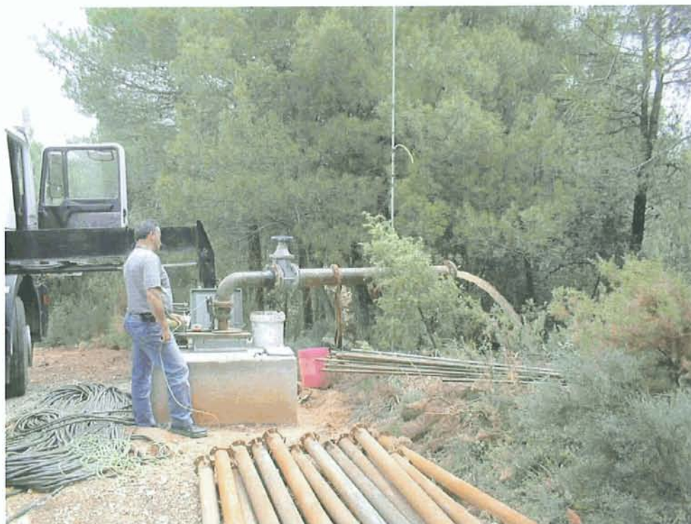
Bombeo y extracción de la bomba tras el mismo
