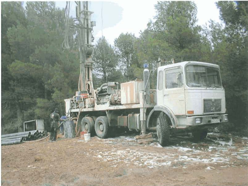
Final de la perforación e introducción de la sonda para la geofísica
