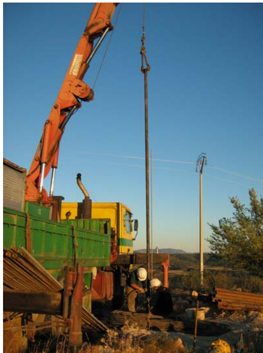
Uniando tuberías con el taladro
