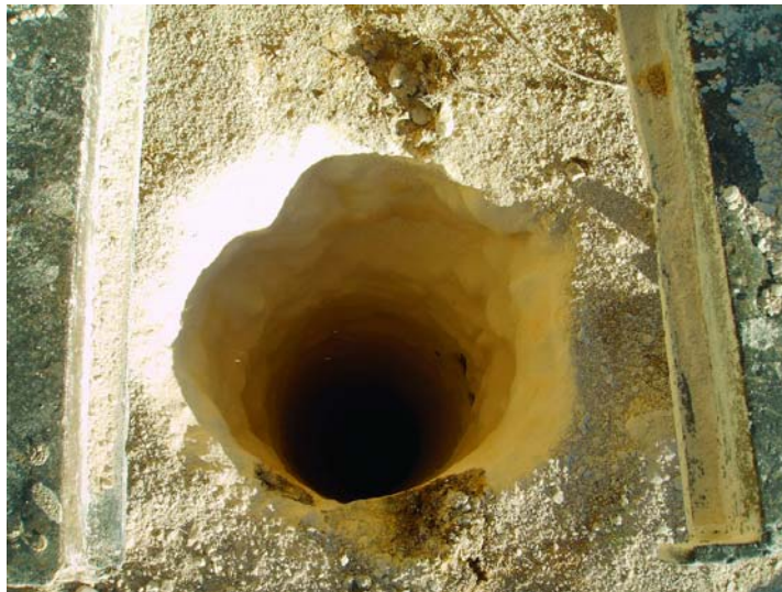
Perforación a 324 mm de diámetro
