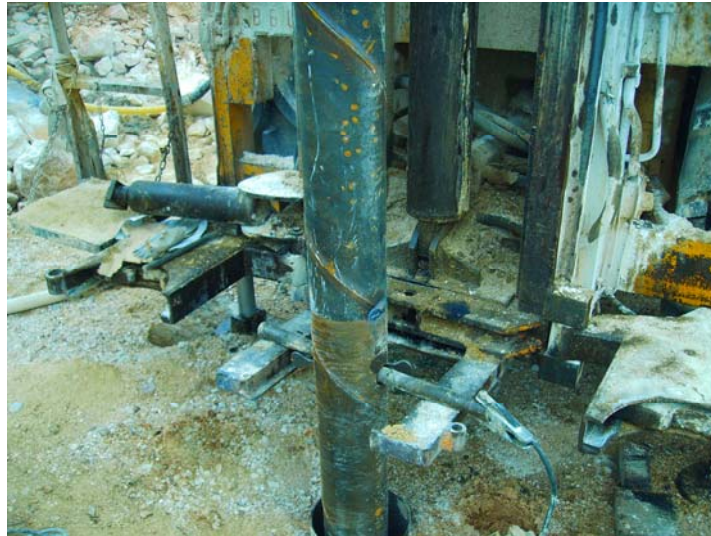
Tubería ciega preparada para ser soldada
