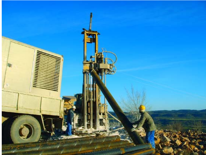
Elevando la tubería de emboquille
