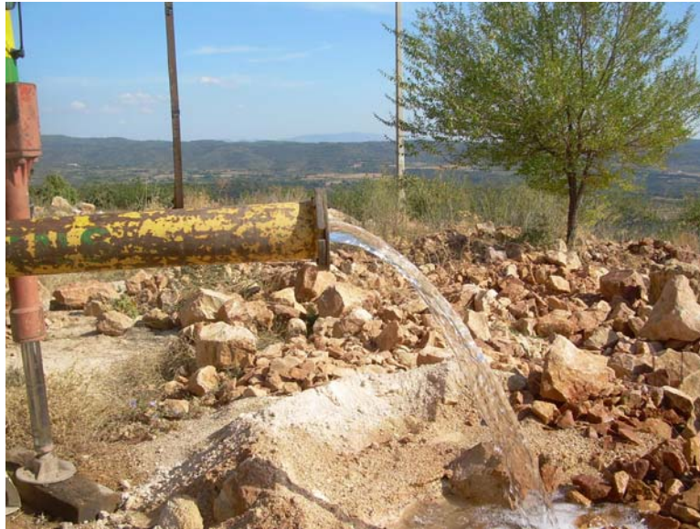
Tercer escalón (agua clara, 5 l/s)
