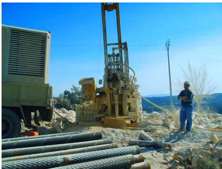
Perforación a 220 mm de diámetro a 175 m de profundidad
