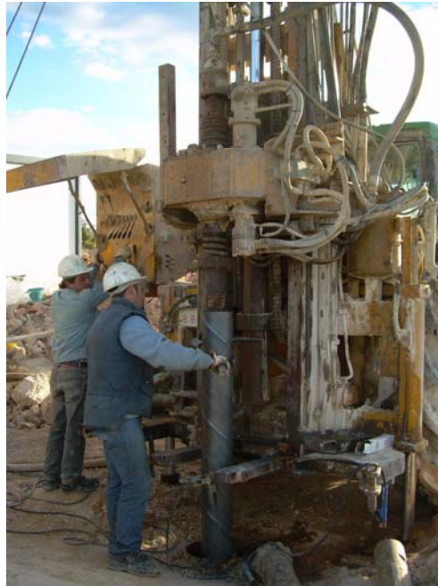
Introduciendo un tramo de tubería ciega
