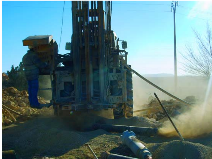
Perforación a 220 mm de diámetro
