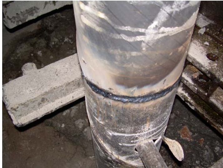
Soldadura entre tuberías ciegas
