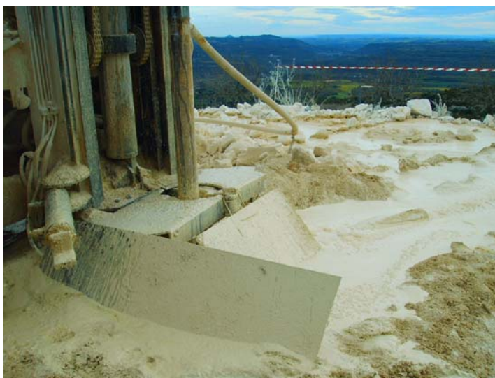
Perforando a 220 mm con inyección de agua y espumante (215 m de profundidad)
