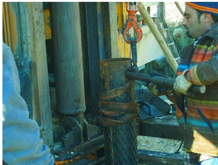
Sujeción de la tubería durante la entubación
