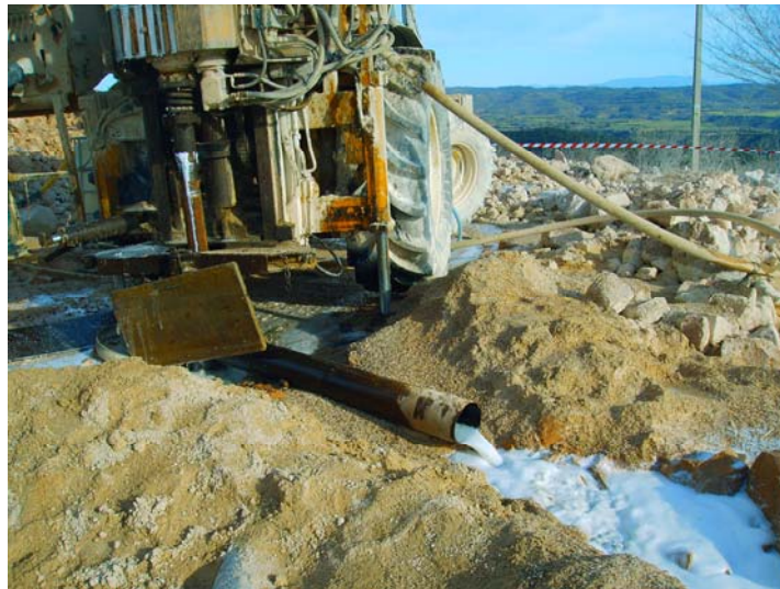
Perforando en 220 mm a 293 m de profundidad
