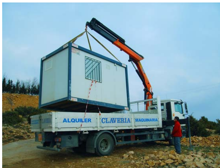
Pluma elevando la caseta de obra para el traslado
