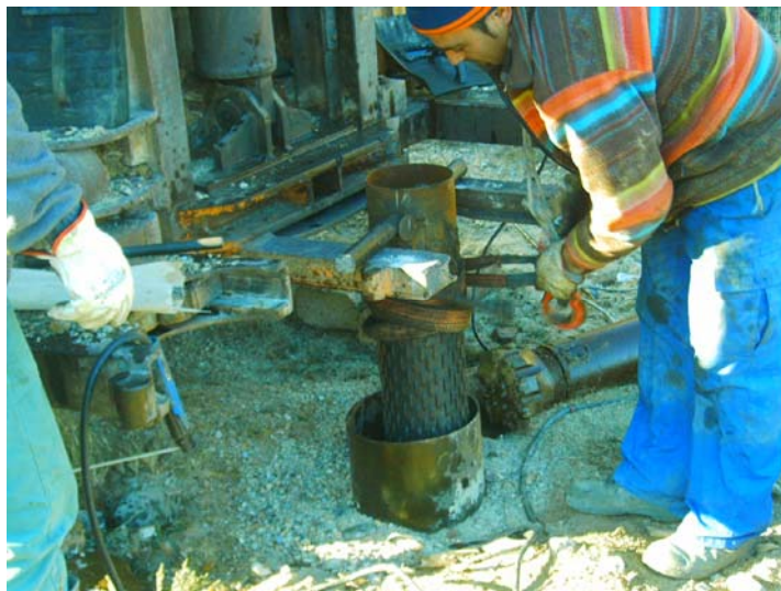
Sujeción de la tubería durante la entubación
