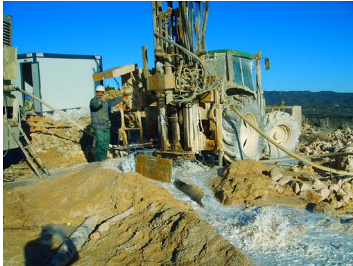
Perforando a 270 m de profundidad
