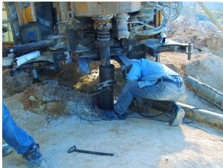
Soldando la tubería de 180 mm a la de 300 mm mediante unos tacos de acero
