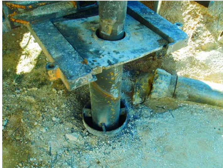
Tubería de 180 mm unida a la de 300 mm
