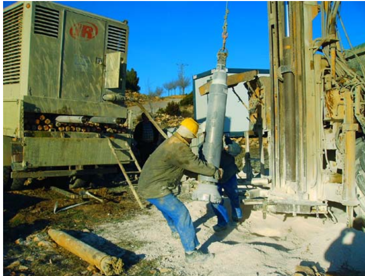
Maniobrando con el martillo de 324 mm
