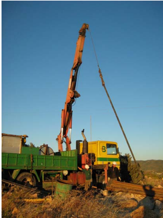
Elevando un tramo de tubería
