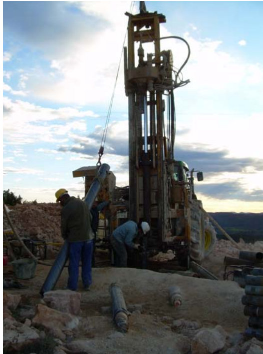
Elevando un tramo de tubería ciega
