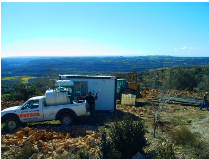
Emplazamiento de la maquinaria
