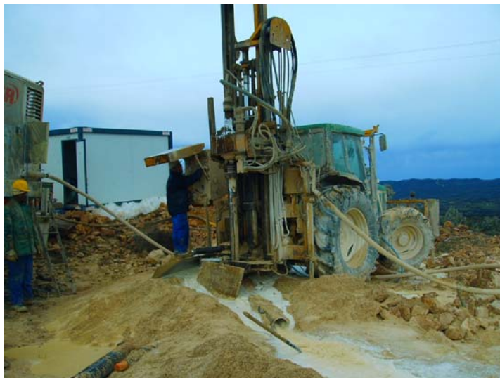
Perforación a 238 m de profundidad (primer aporte)
