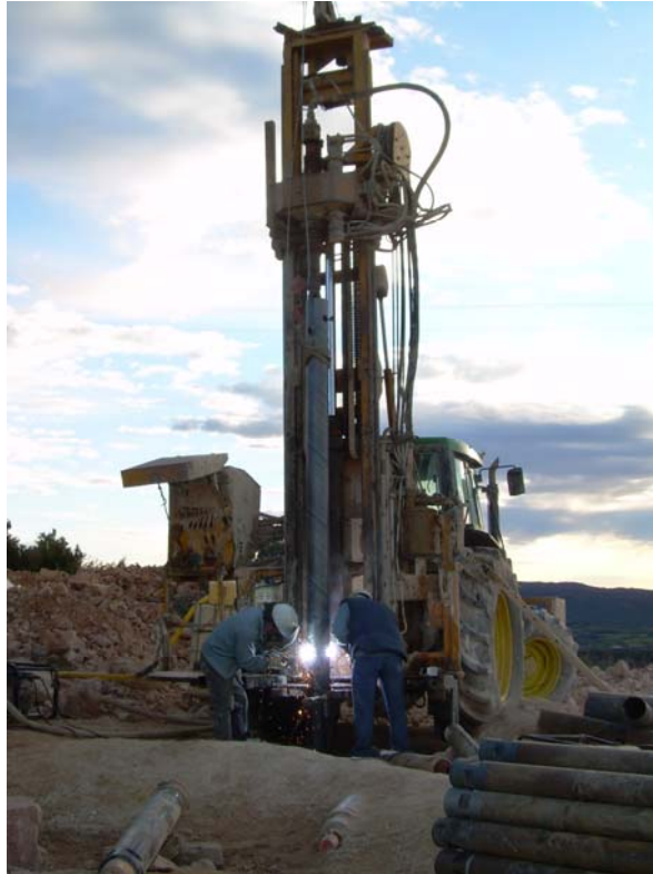
Soldando tuberías
