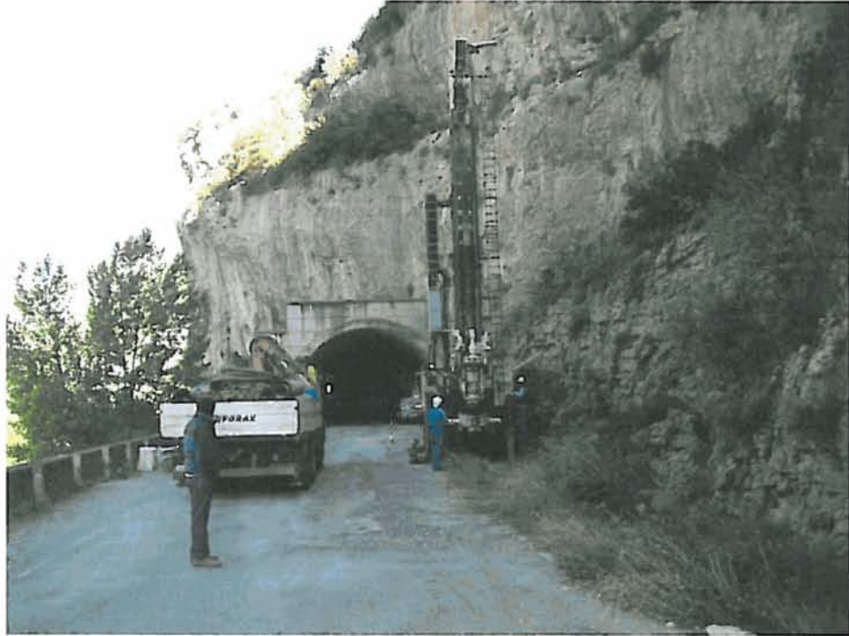
Máquina emplazamiento y perforación del emboquille
