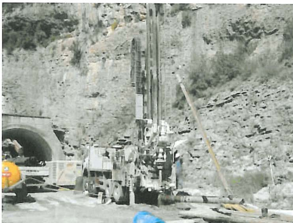
Perforación sondeo de Janovas en 140 m
