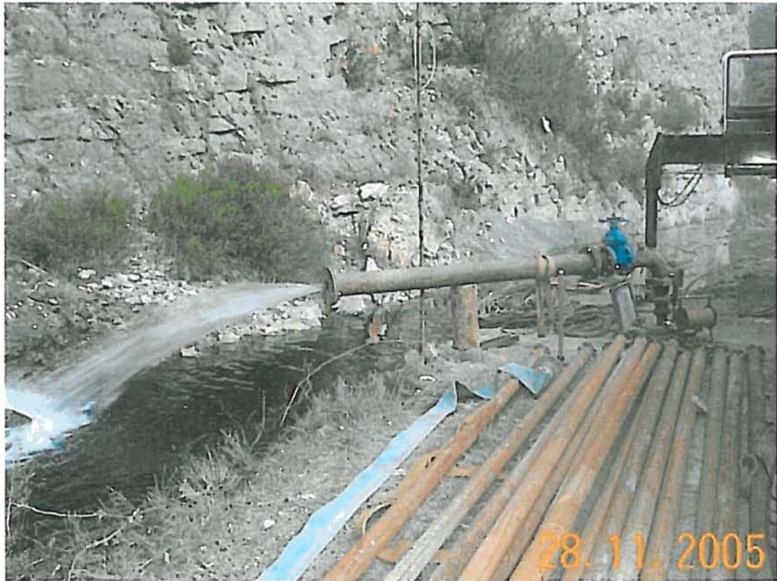
Primera parte del aforo (pitot)
