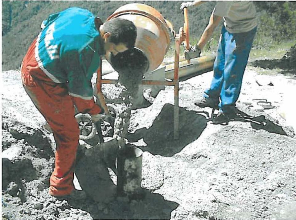
Proces de cementación del anular y detalle de la arqueta hormigonada a falta de regularizar el ripio de perforación.
