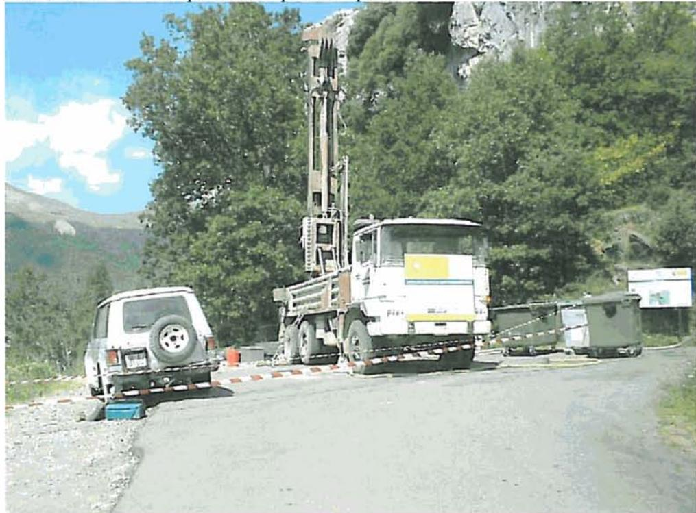
A las 17:45 se inicia por fin la perforación. Afortunadamente sólo se atraviesa un relleno de 4 metros y a partir de esa profundidad, se perforan las calizas dolomíticas y calcarenitas grises de la megacapa paleocena objeto de esta perforación. Se da por terminada la visita a las 19:30 con 14 metros perforados.
