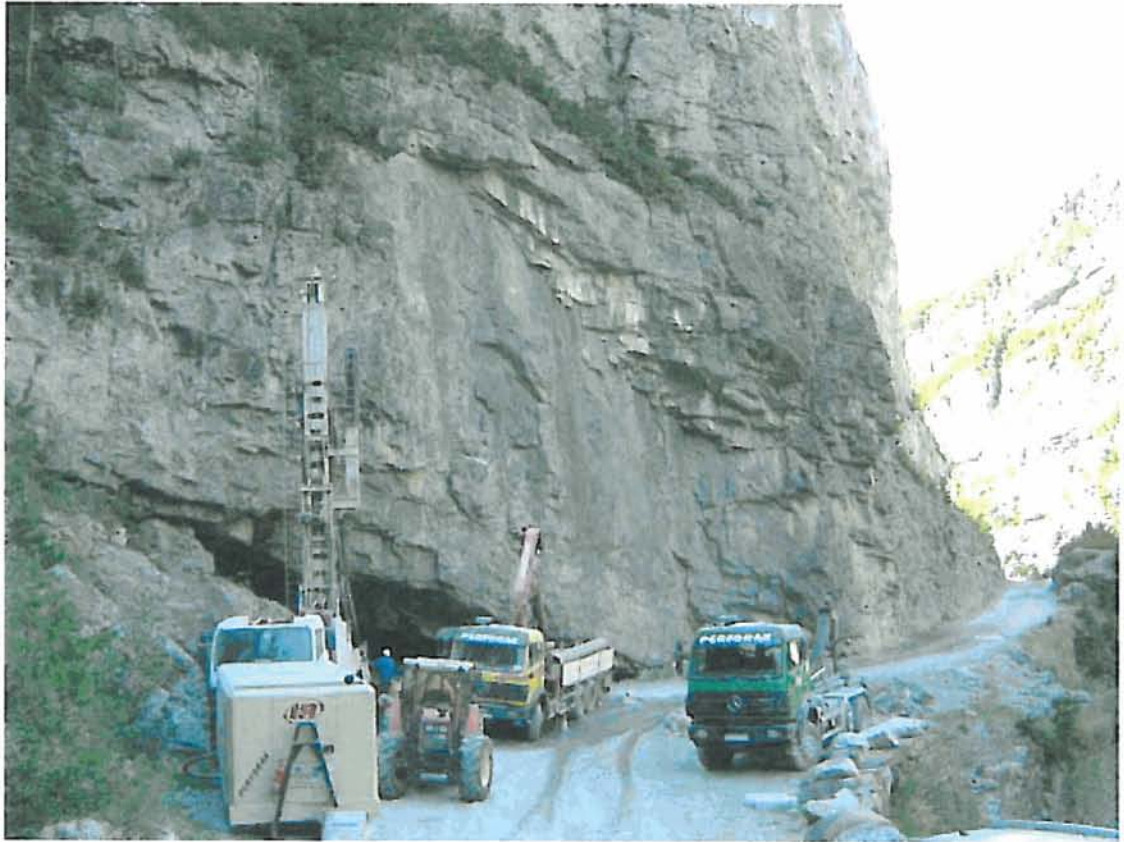
Perforación sondeo de Torla en 85 m
