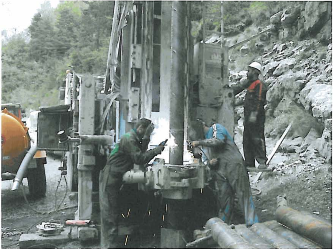
Soldadura de las aberturas para el izado de la tubería .
