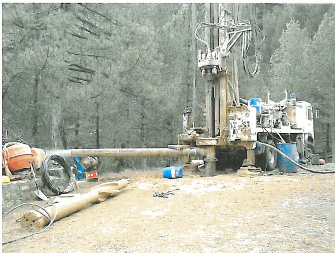
Perforación con diámetro 220 mm.
